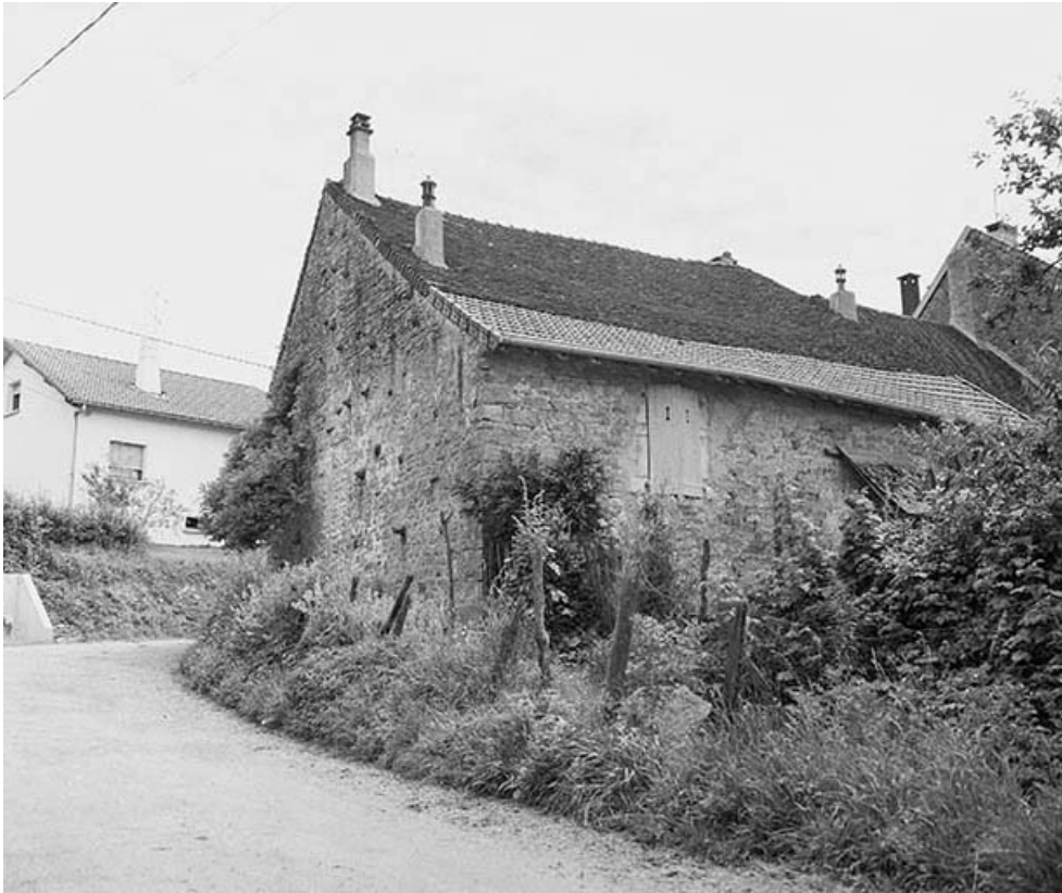
Façades postérieure et latérale droite.
