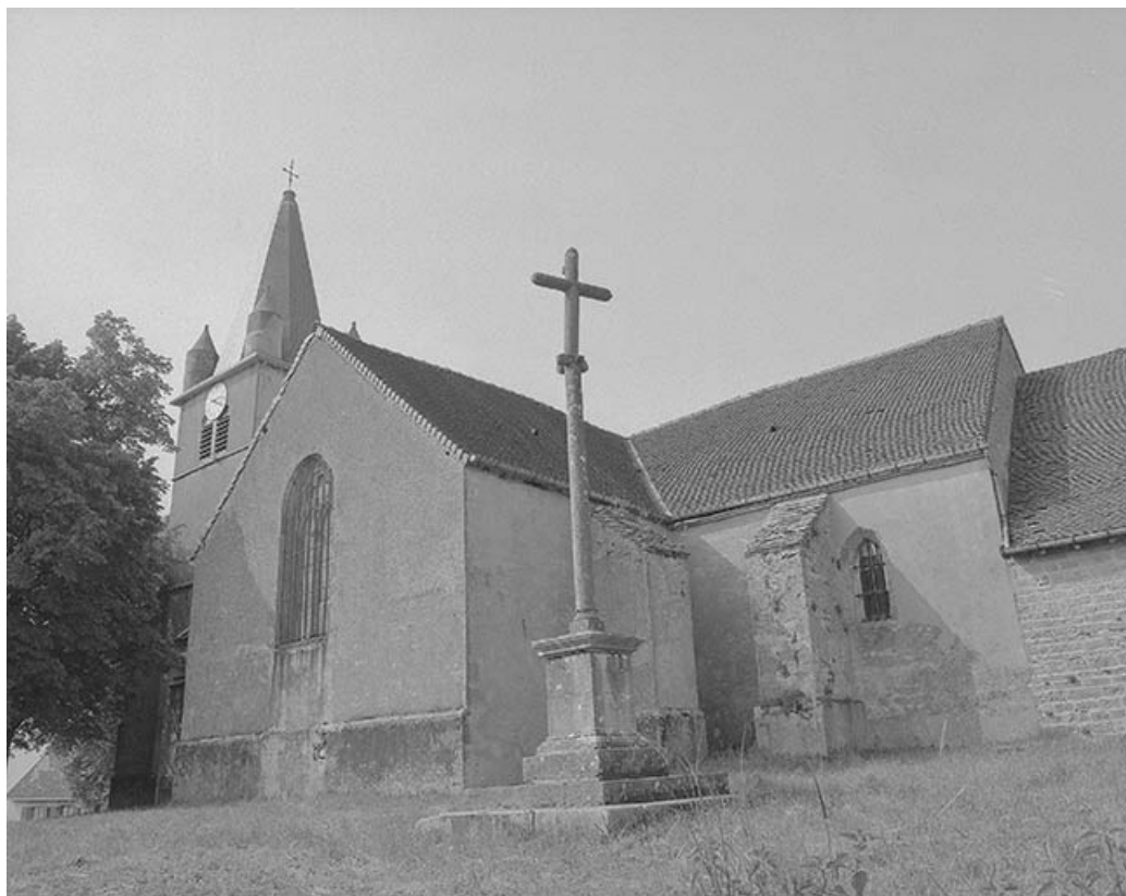
Façade latérale droite : transept et chœur, croix monumentale
