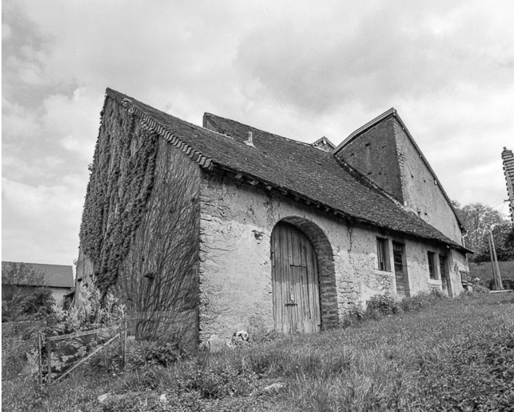
Ferme cadastrée 1952 U2 363, située rue Chateraine : vue d'ensemble. 39, Montain
