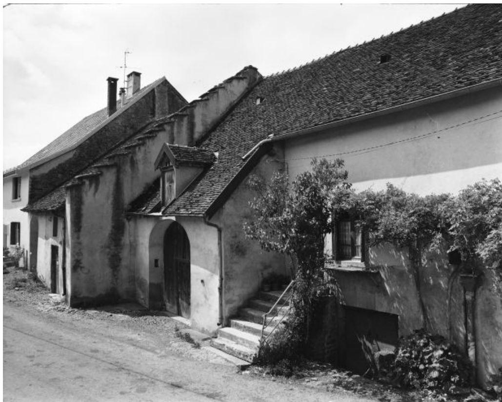
Façade antérieure vue de trois quarts droit. 39, Montain
