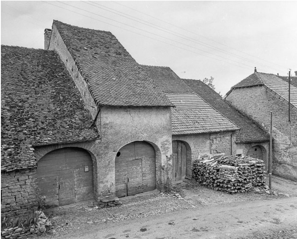
Vue de la façade sur le chemin des Vignes.
