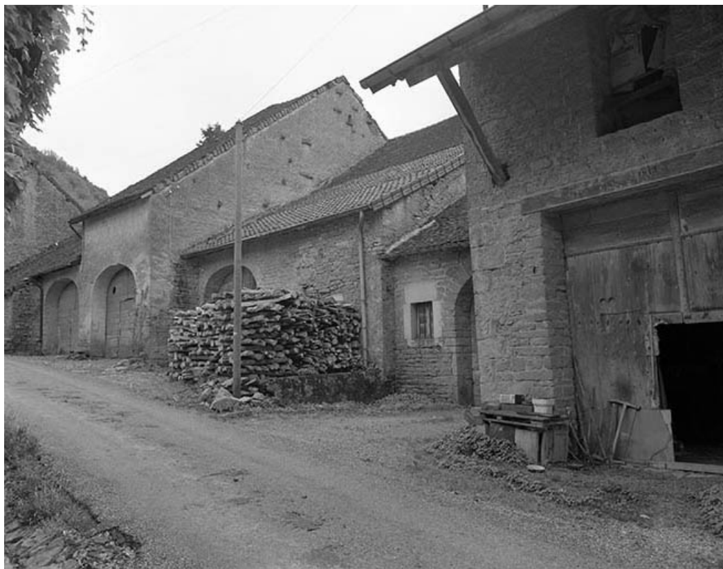
Vue de trois quarts droit depuis le chemin des Vignes.
