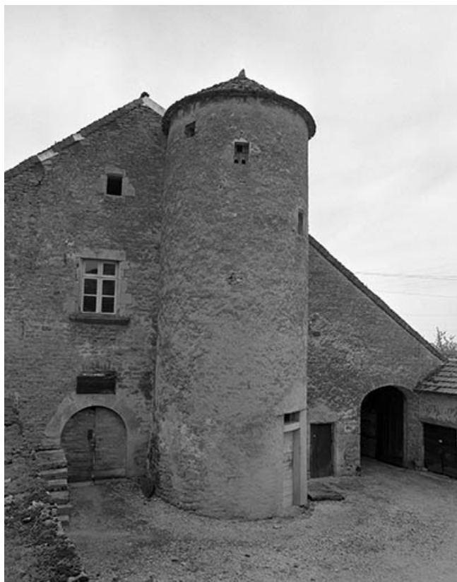
Façade sur la cour : la tourelle.
