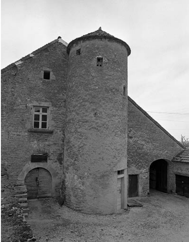
Façade sur la cour : la tourelle.
