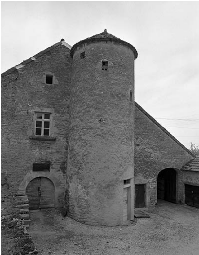
Façade sur la cour : la tourelle.
