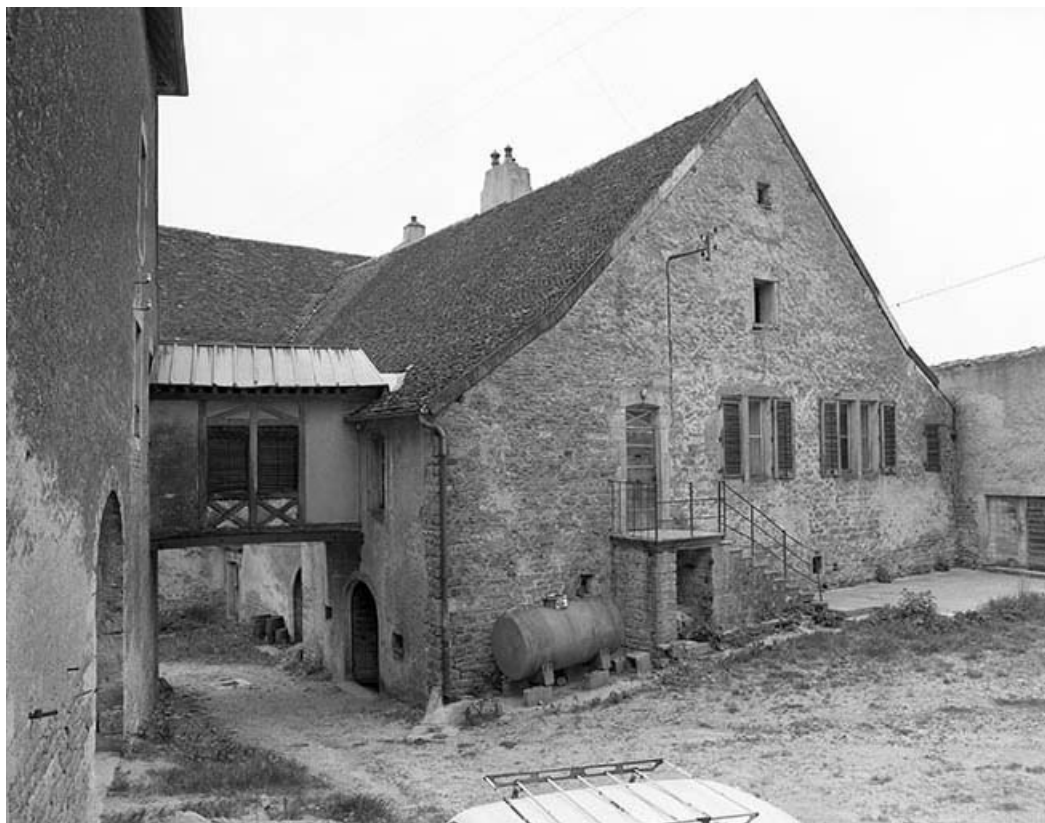
Façade est, partie droite.
