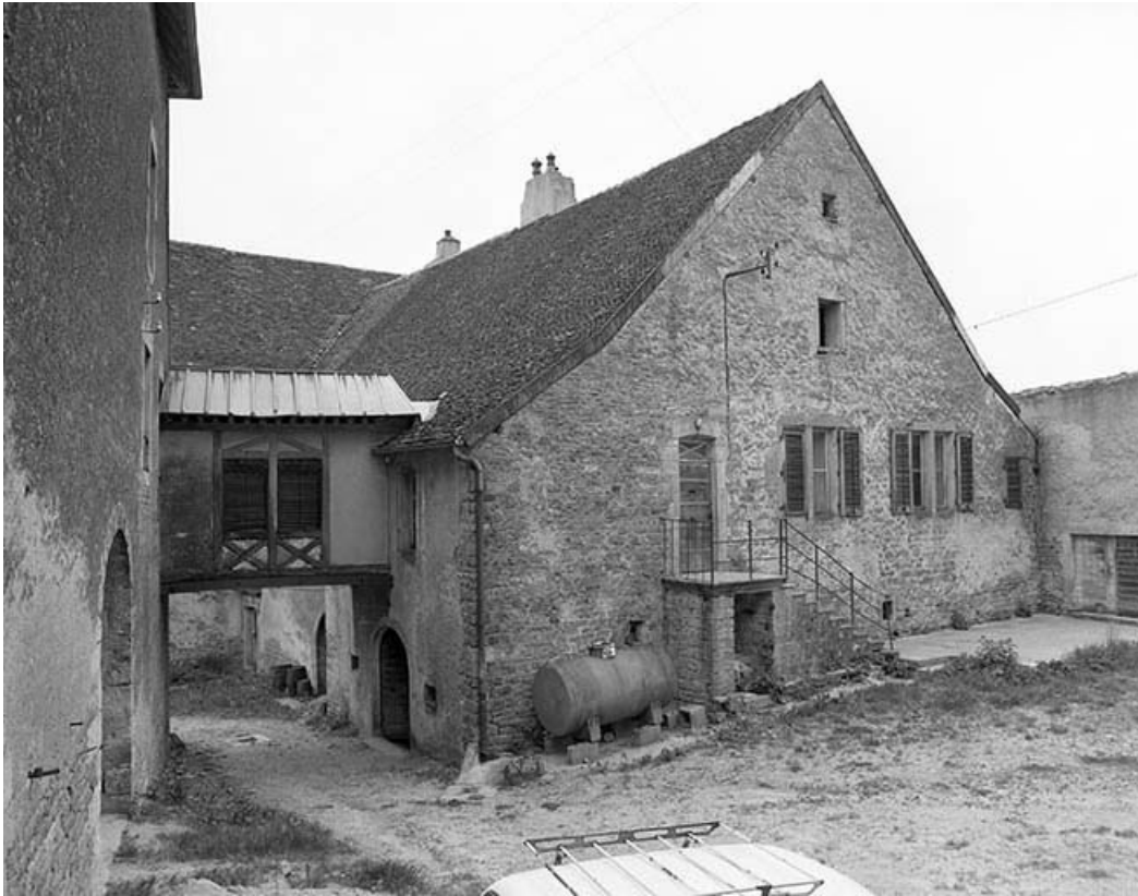
Façade est, partie droite.
