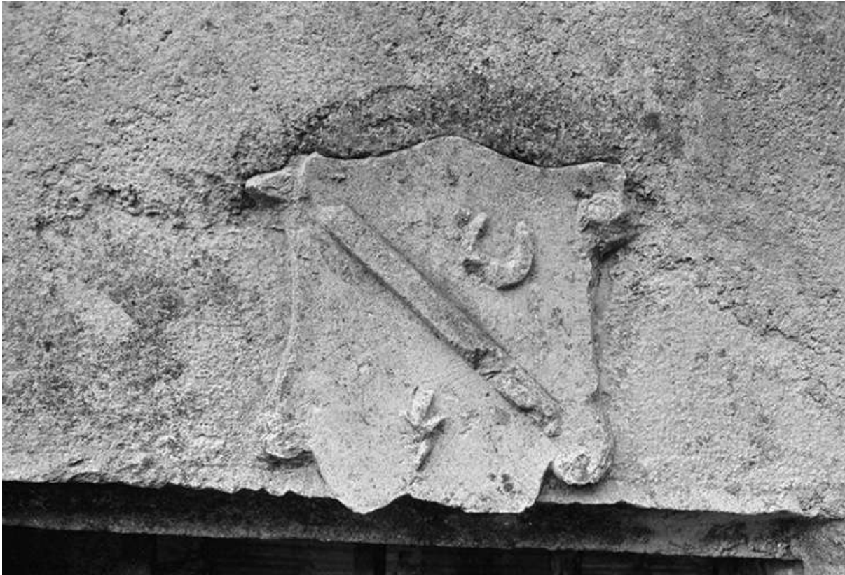
Linteau de fenêtre : vue du blason
