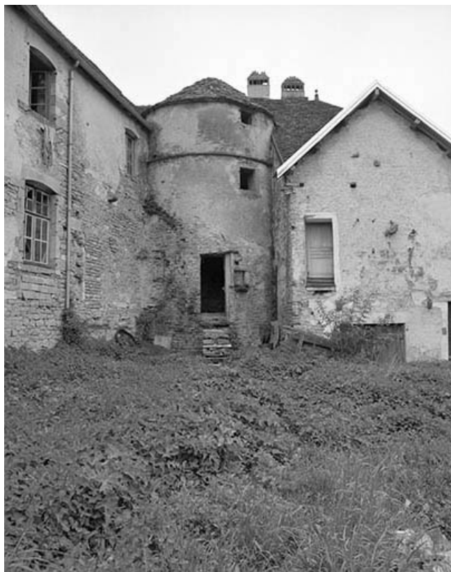
Façade ouest, partie gauche.
