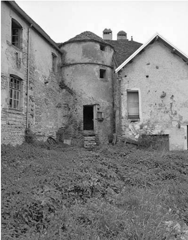
Façade ouest, partie gauche.
