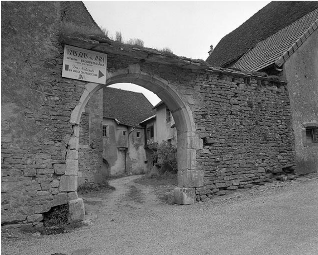
Façade sud : portail d'entrée de la cour. 39, Menétru-le-Vignoble rue de la Fontaine
