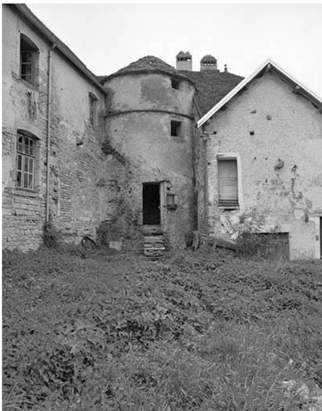
Façade ouest, partie gauche.
