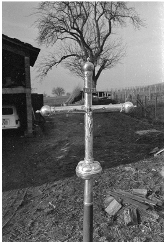
Croix de procession en cuivre argenté, XVI e siècle : face avant 39, Menétru-le-Vignoble rue de l' Église
