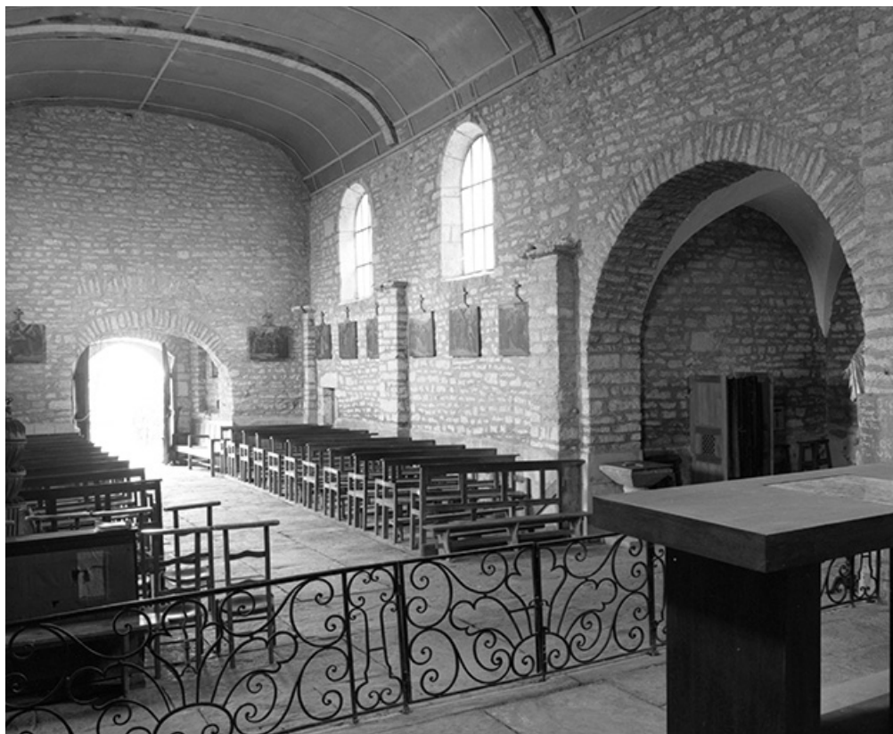
Nef, élévation gauche vue depuis le chœur.
