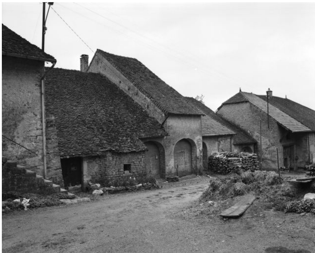
Vue de trois quarts gauche depuis le chemin des Vignes.
