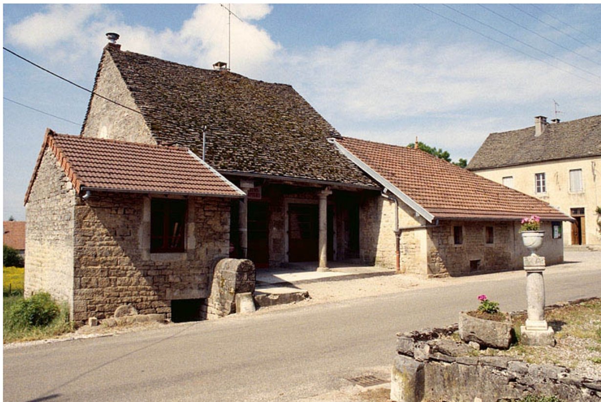
Façade antérieure (vue éloignée).
