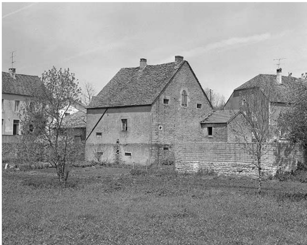
Façade postérieure et façade gauche.
