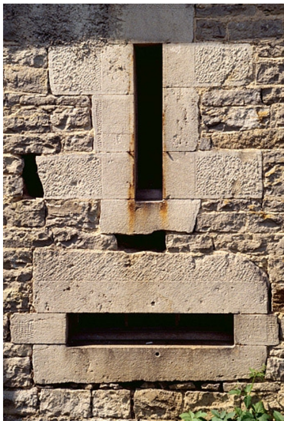
Fenêtres de la chambre à lait, mur ouest.
