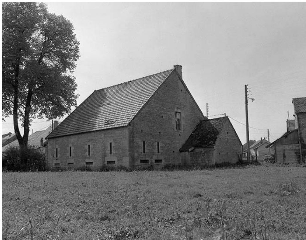
Façade postérieure et façade gauche.
