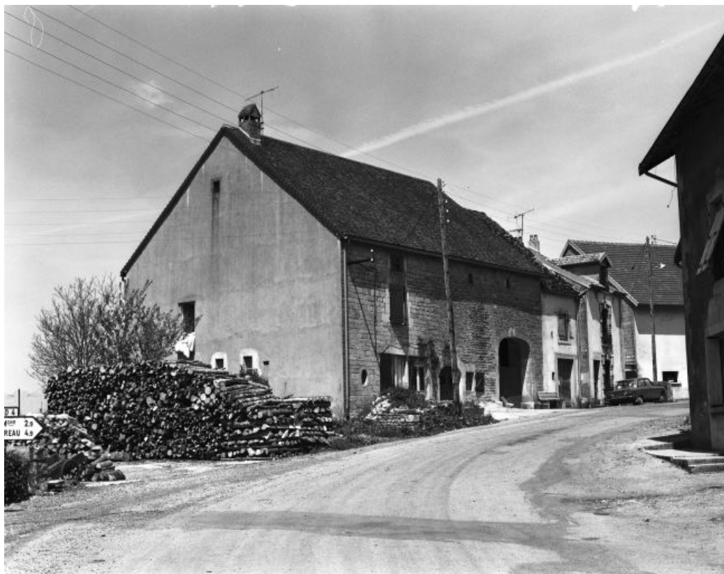
Façade antérieure vue de trois-quarts gauche en 1981.
