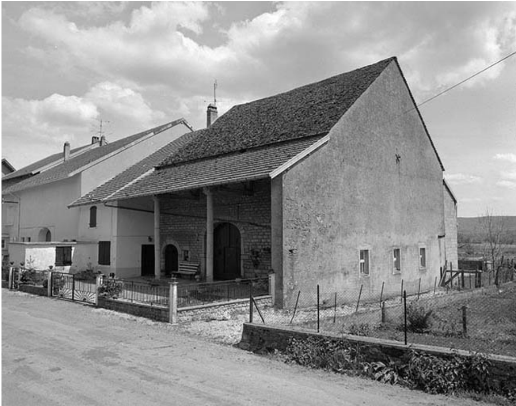
Façade antérieure et façade droite.
