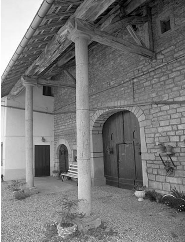
Façade antérieure : détail de l'avant-toit.
