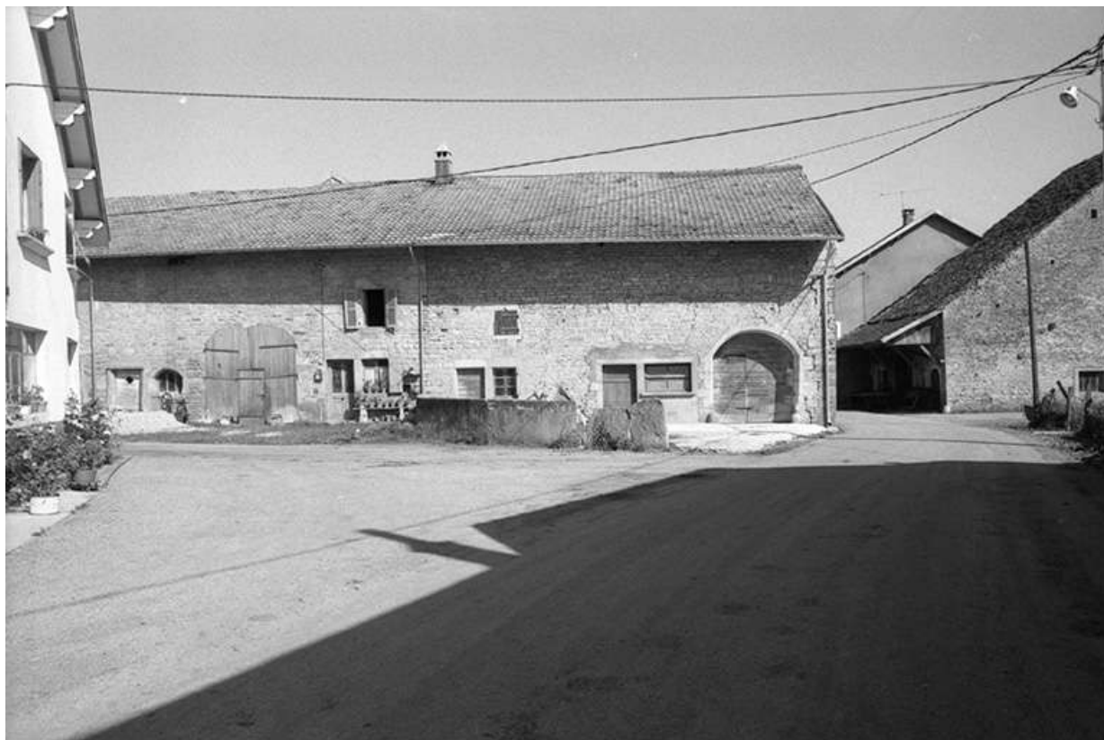
Ferme double cadastrée 1957 A1 89 et 92, située le long du chemin de grande communication n° 96 de Plasne à Mirebel : façade antérieure.
