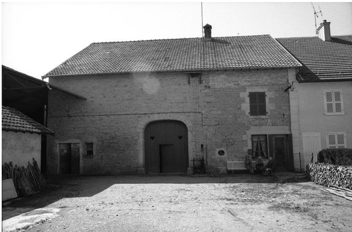
Ferme cadastrée 1957 A1 192, située le long du chemin de grande communication n° 4 d'Orgelet à Arbois : façade antérieure et cour.
