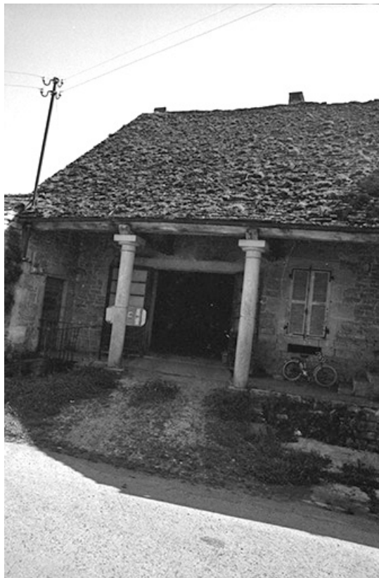
Ferme cadastrée 1957 A1 307, située le long du chemin de grande communication n° 96 de Plasne à Mirebel : façade antérieure 39, La Marre
