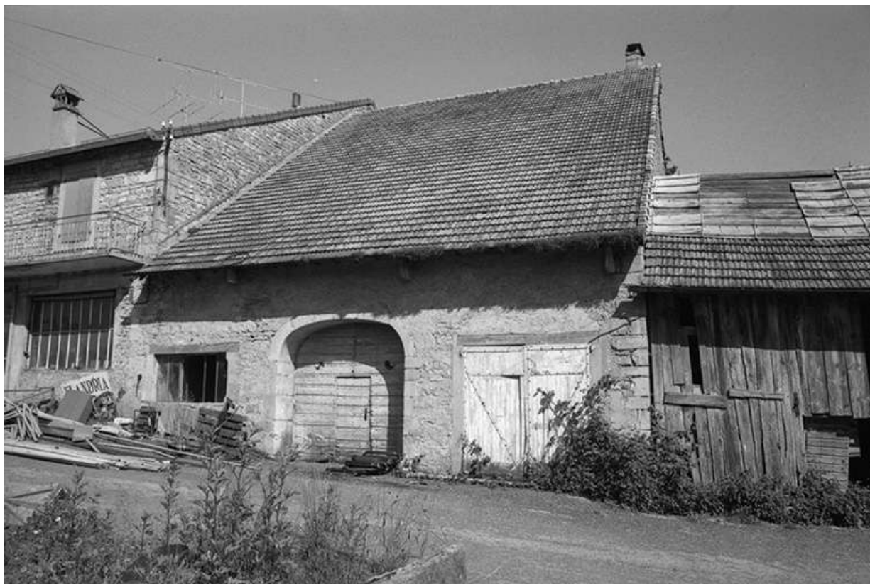
Ferme cadastrée 1957 A1 135-138 : façade postérieure. 39, La Marre
