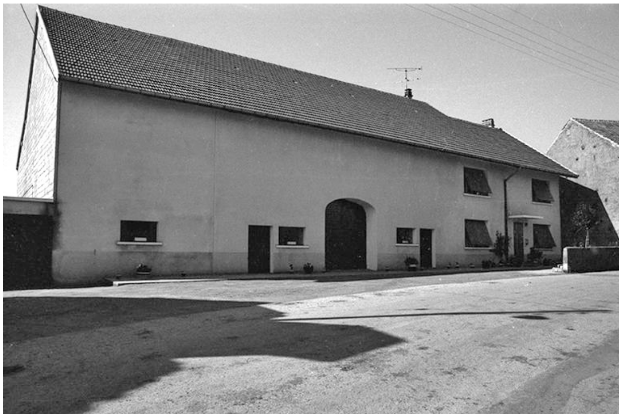
Ferme cadastrée 1957 A1 276, située le long du chemin de grande communication n° 4 d'Orgelet à Arbois : façade antérieure. 39, La Marre
