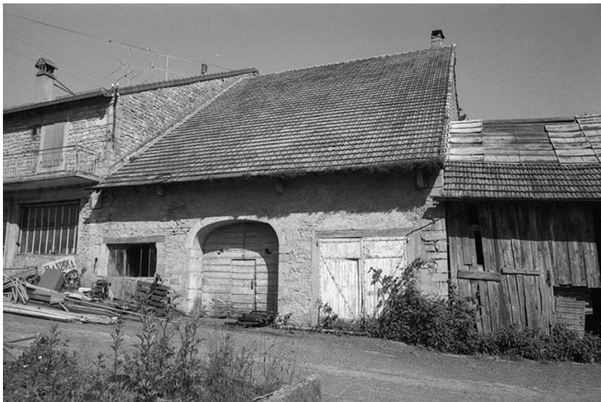
Ferme cadastrée 1957 A1 135-138 : façade postérieure. 39, La Marre
