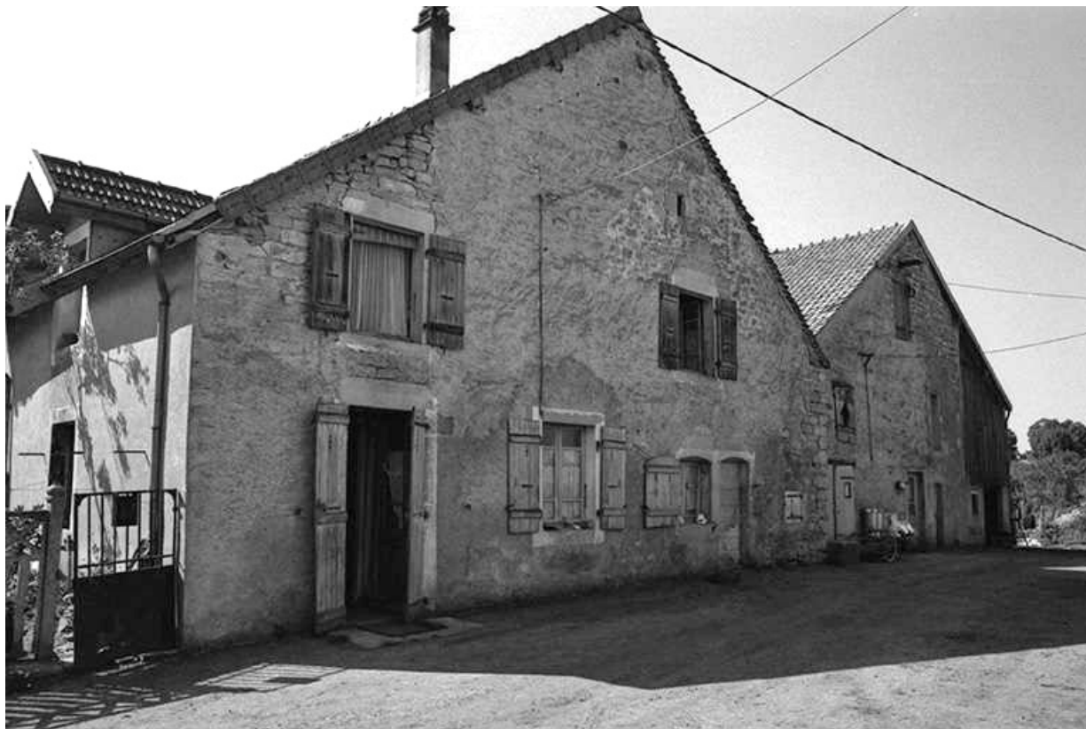
Maison cadastrée 1957 A1 73-74, située le long du chemin de grande communication n° 96 de Plasne à Mirebel : façade antérieure. 39, La Marre
