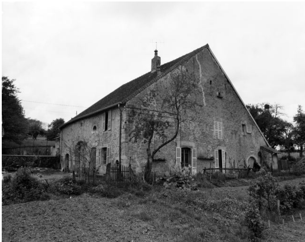
Façades antérieure et latérale droite.
