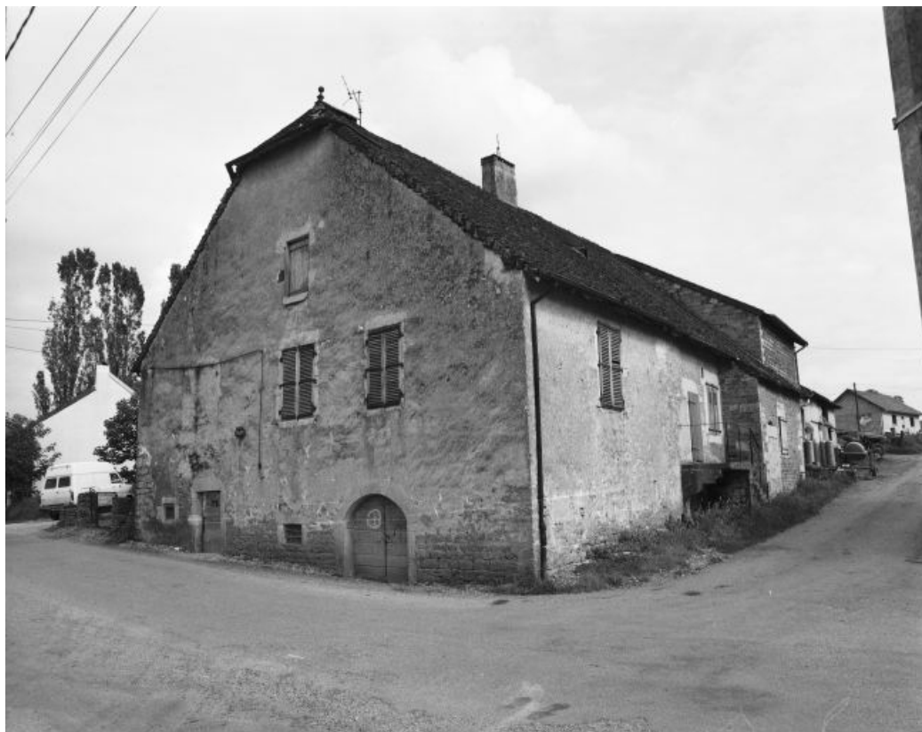
Façades postérieure et latérale droite.
