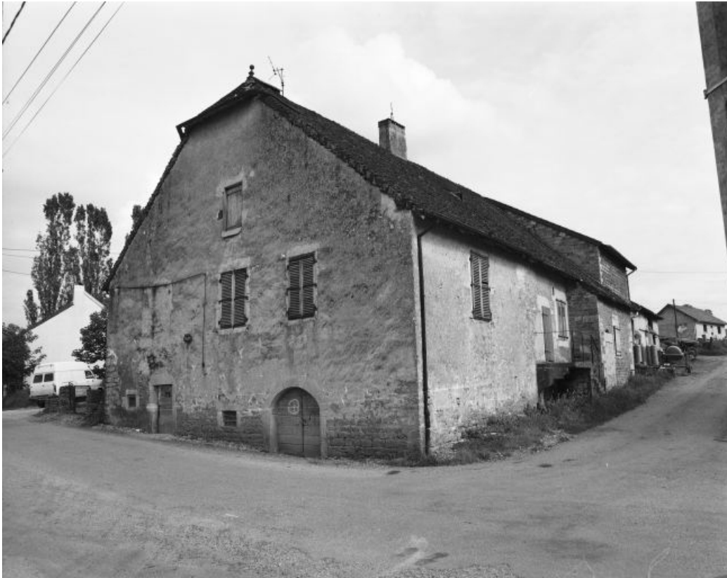
Façades postérieure et latérale droite.
