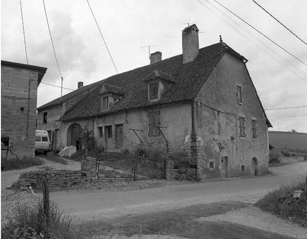
Façades antérieure et latérale droite.
