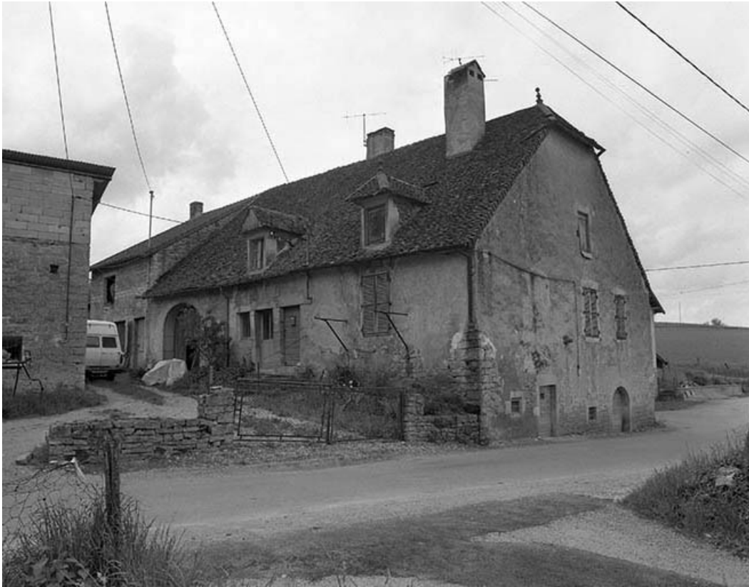
Façades antérieure et latérale droite.
