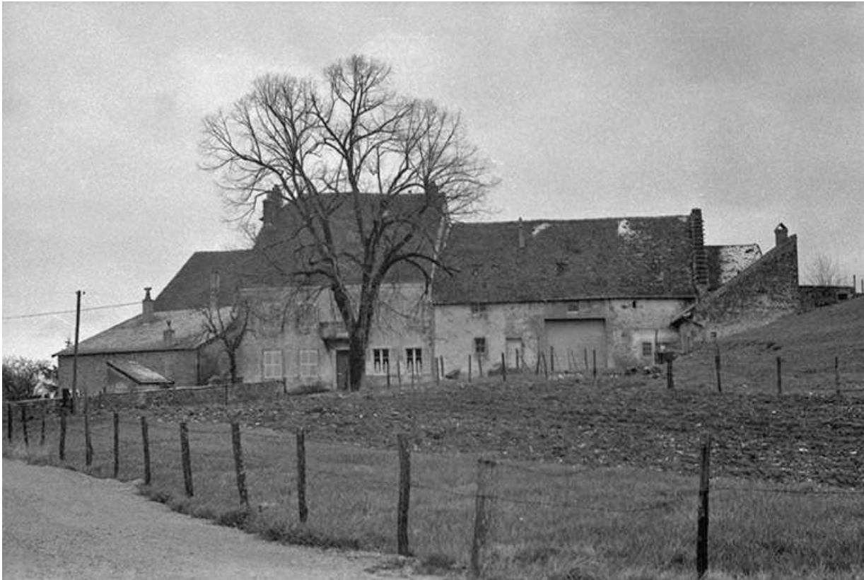
Ferme, fin 18e siècle : vue depuis le chemin 39, Le Louverot
