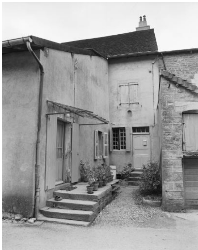
Façade sur la rue de la Forge.
