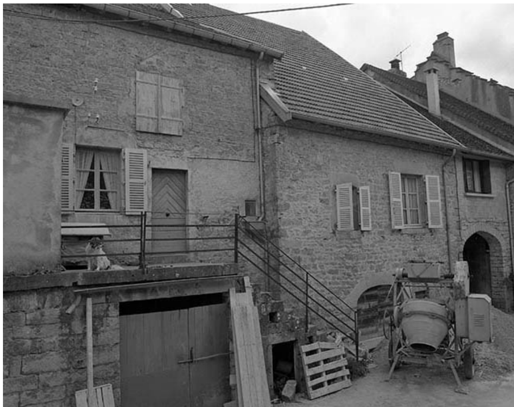
Façade sur l'impasse du quart d'Amont.
