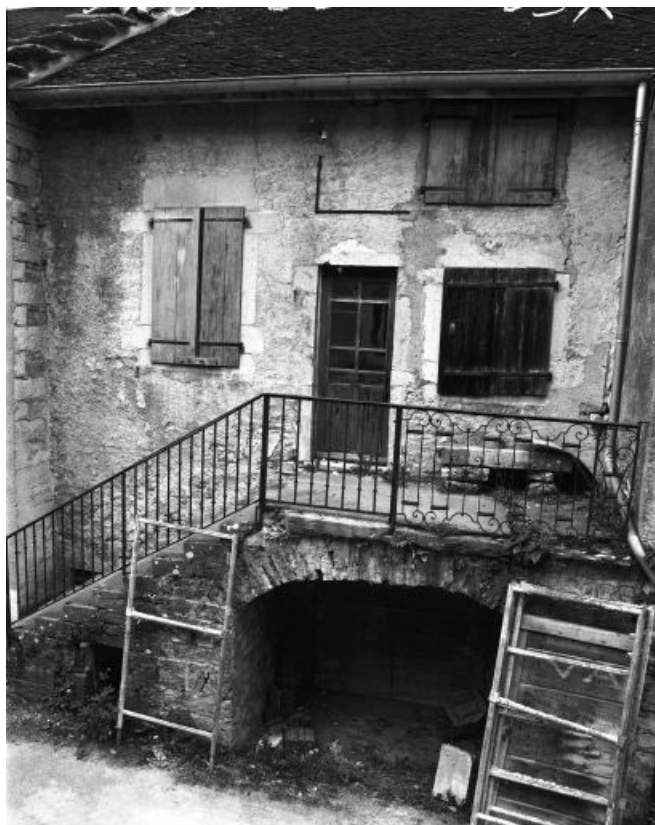
Façade antérieure vue de face en 1981.
