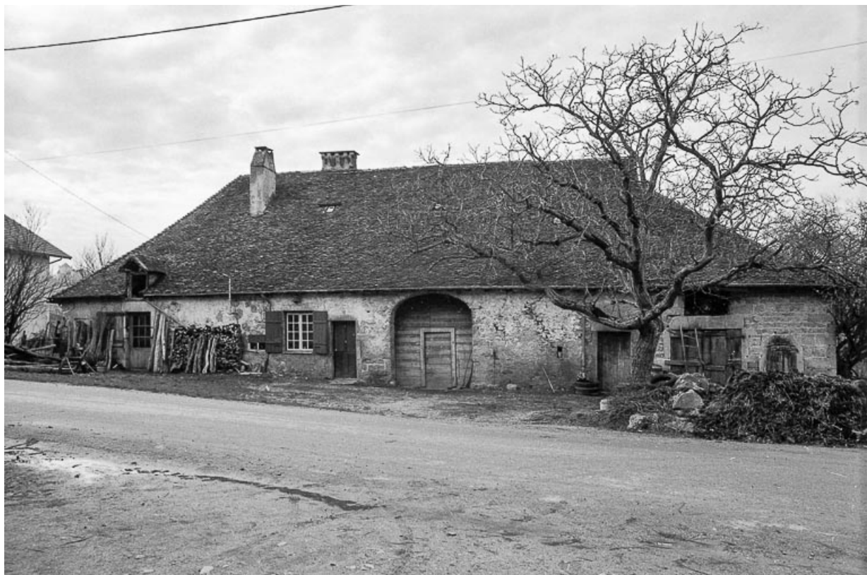
Maison cadastrée 1967 AH 220, située au lieu-dit Traverse de Lavigny : : façade antérieure. 39, Lavigny
