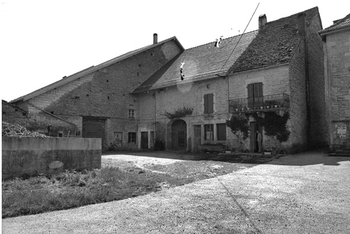
Ferme cadastrées 1965 AB 51-52, situées le long du chemin départemental n° 210 de Crançot à La Marre : façades antérieures. 39, Granges-sur-Baume
