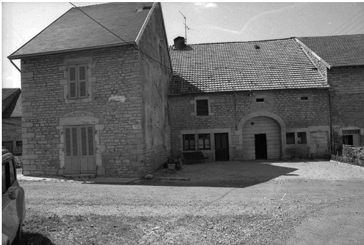
Ferme cadastrée 1965 AB 73 ou 74 située le long de la voie communale n° 2 dite des Saugettes : façade antérieure. 39, Granges-sur-Baume
