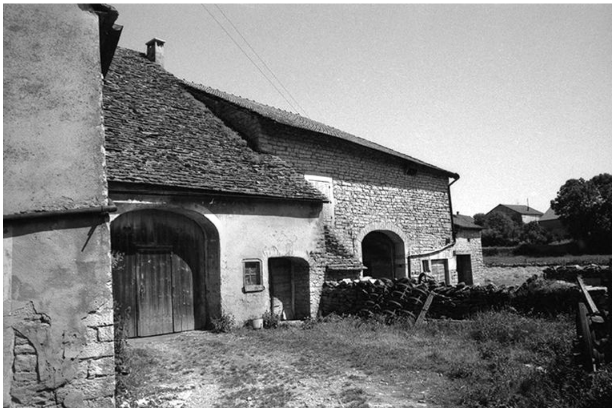
Ferme cadastrées 1965 AB 139 et 142, située le long de la voie communale n° 2 dite des Saugettes : façades antérieures et toits en lave.
