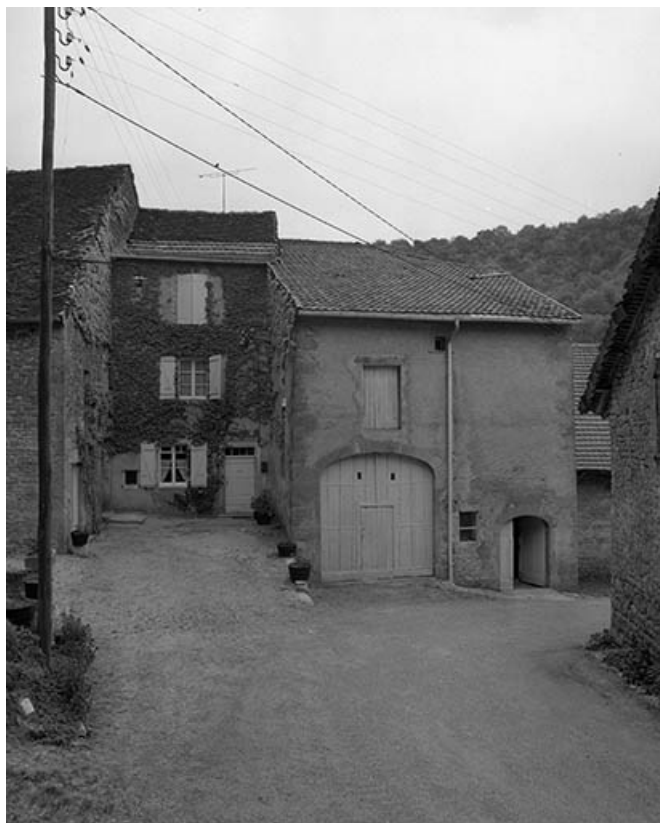
Façade antérieure, partie droite.
