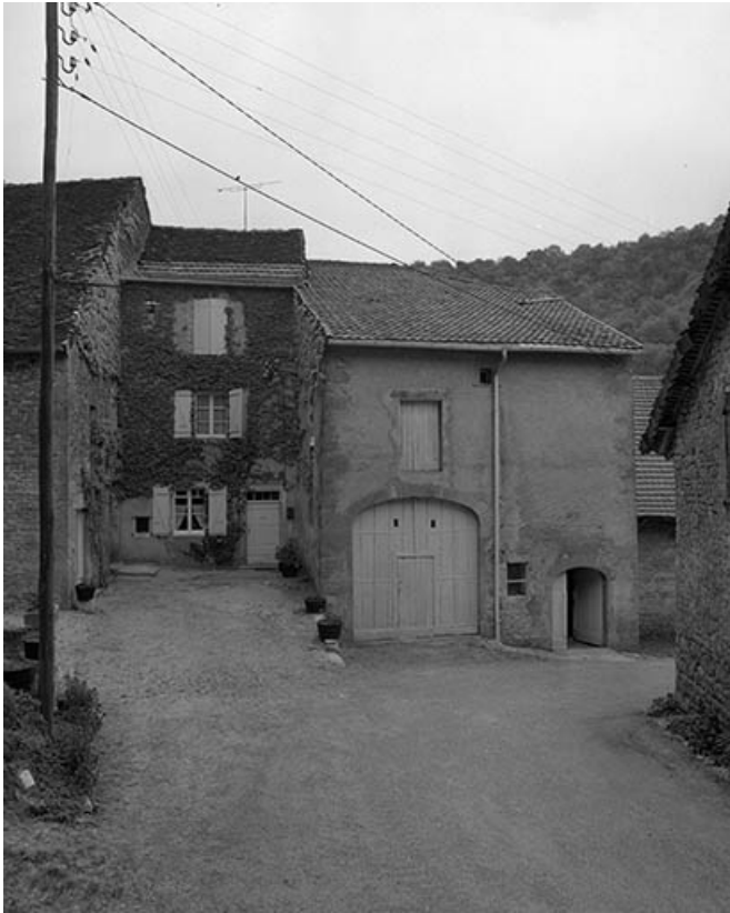
Façade antérieure, partie droite.
