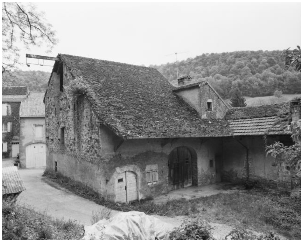
Façades antérieure et latérale gauche.
