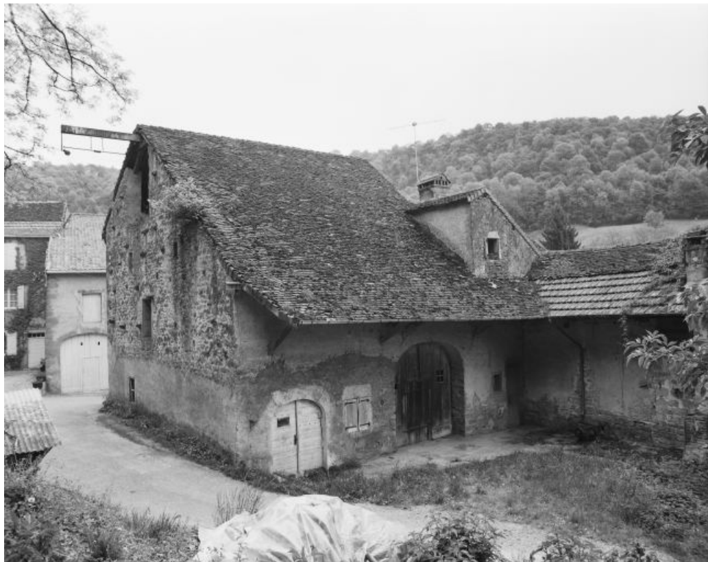
Façades antérieure et latérale gauche.
