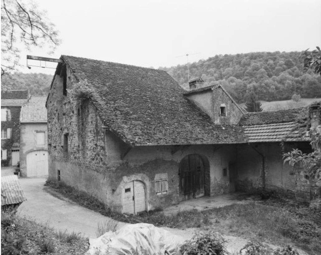
Façades antérieure et latérale gauche.
