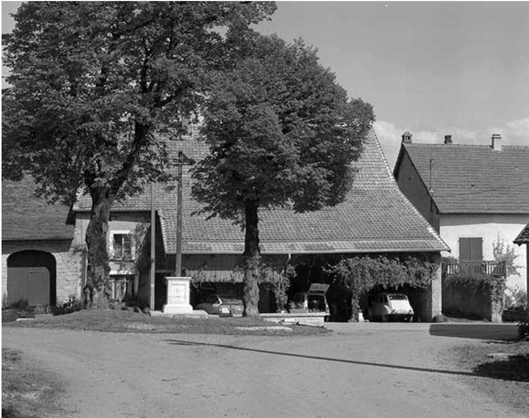
Façade antérieure vue de face en 1981. 39, Le Fied
