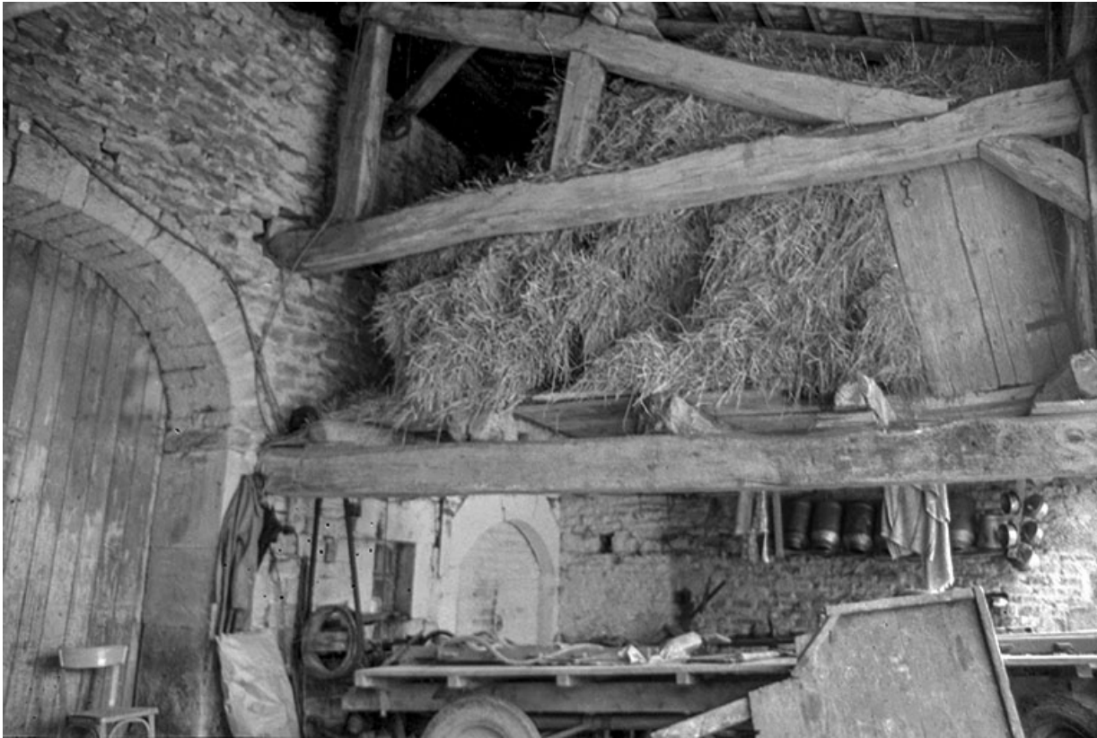
Détail de la charpente en 1974.
