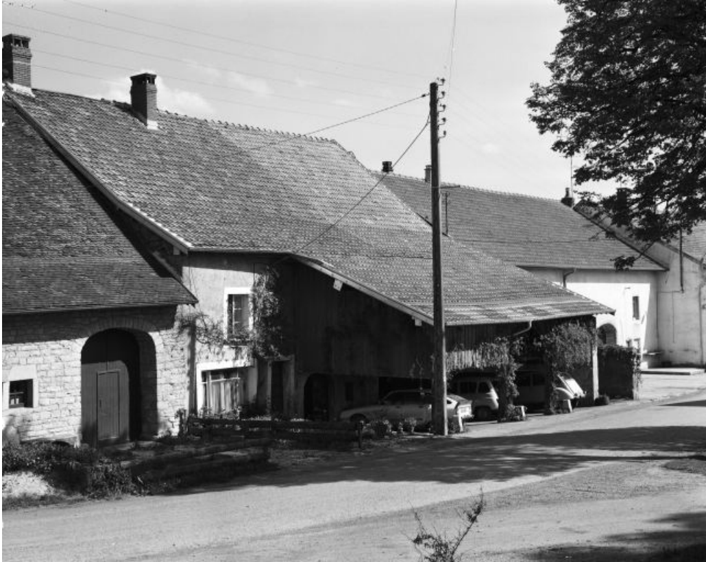
Façade antérieure vue de trois quarts en 1981.
