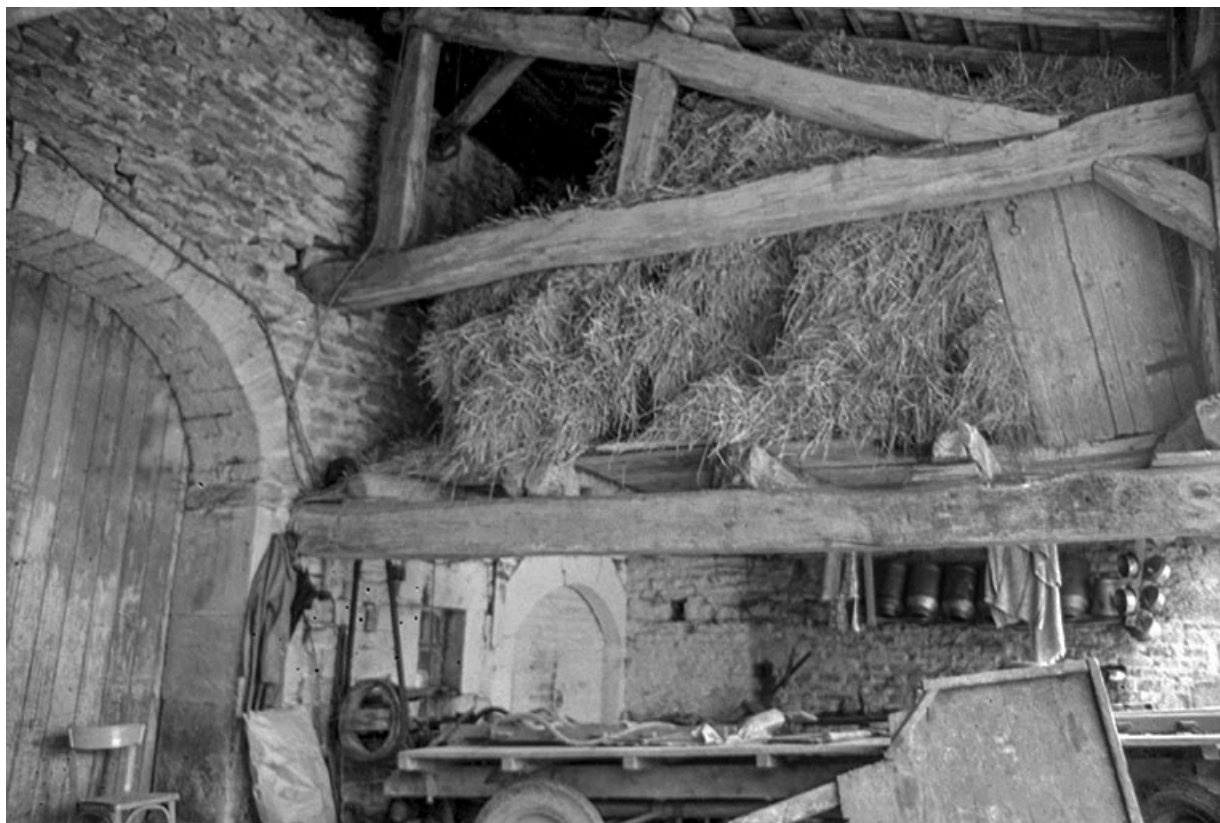
Détail de la charpente en 1974.
