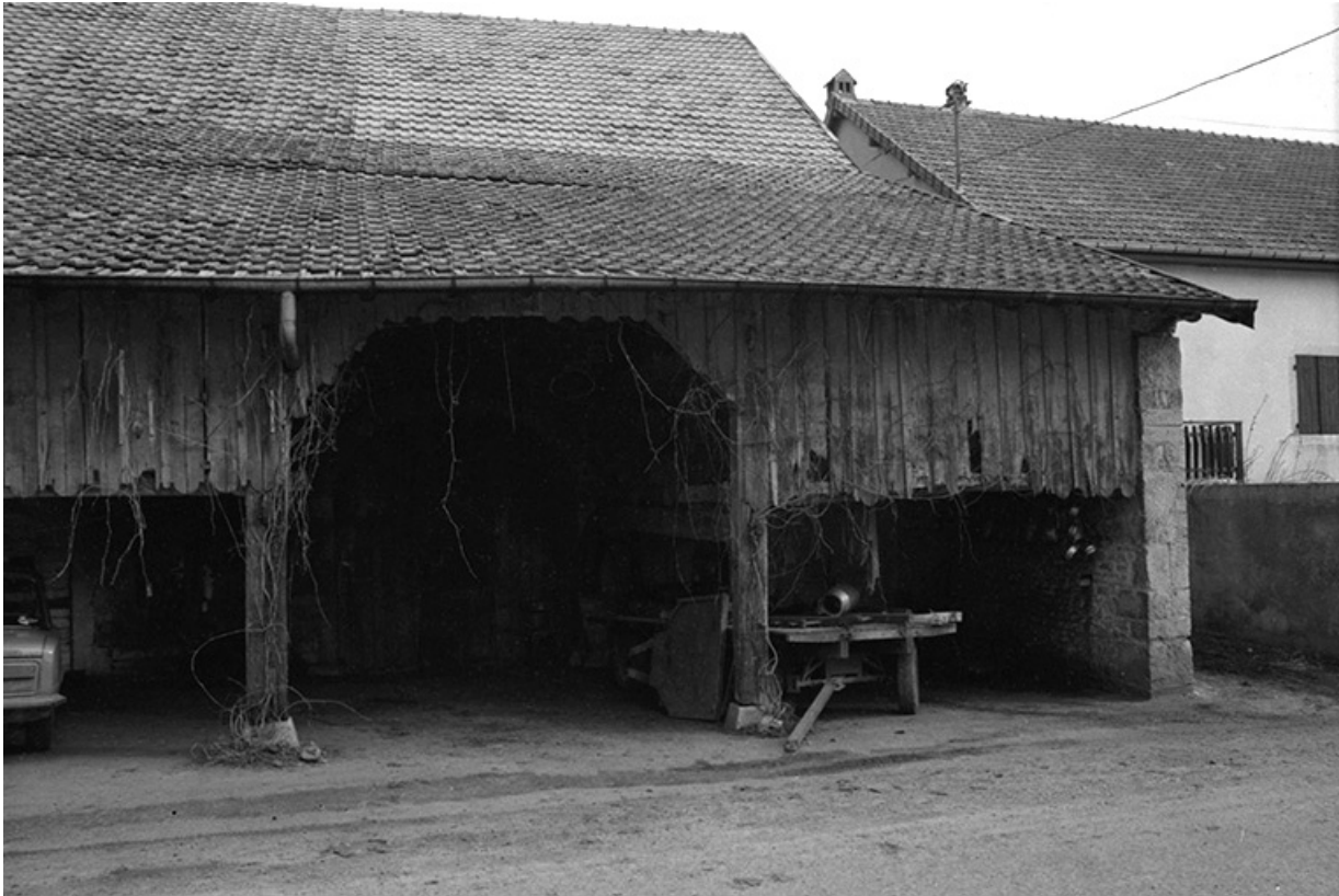
Vue rapprochée de l' "avant-couvert".
