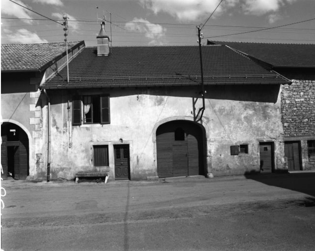
Façade antérieure de face.
