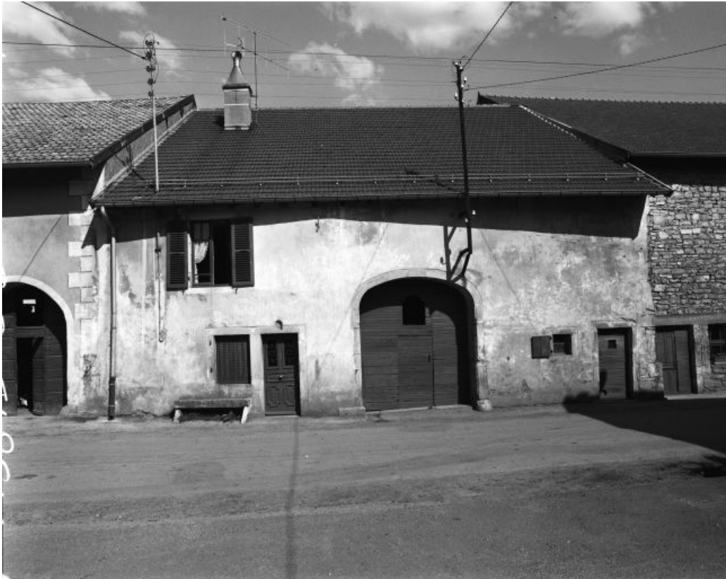
Façade antérieure de face.
