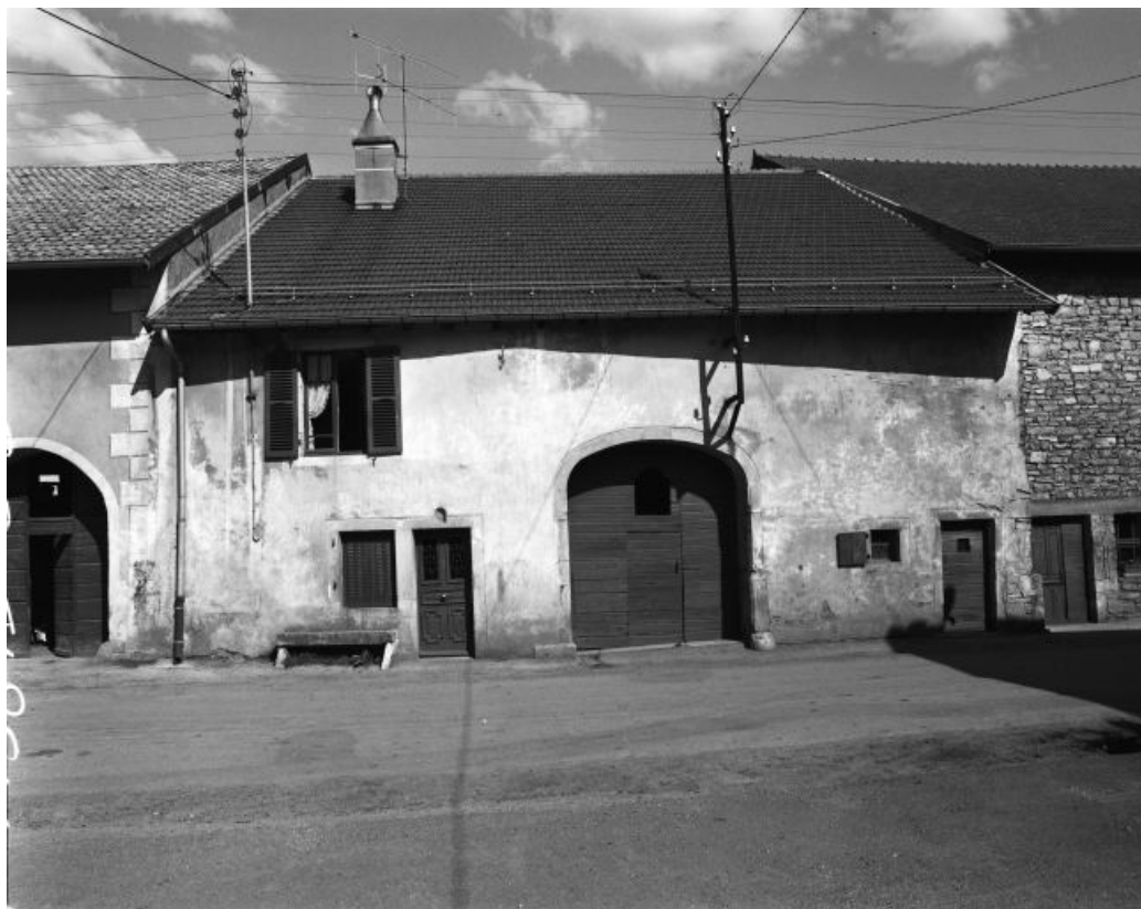
Façade antérieure de face.
