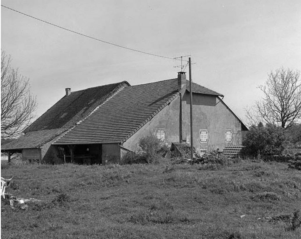
Façade postérieure et façade droite.
