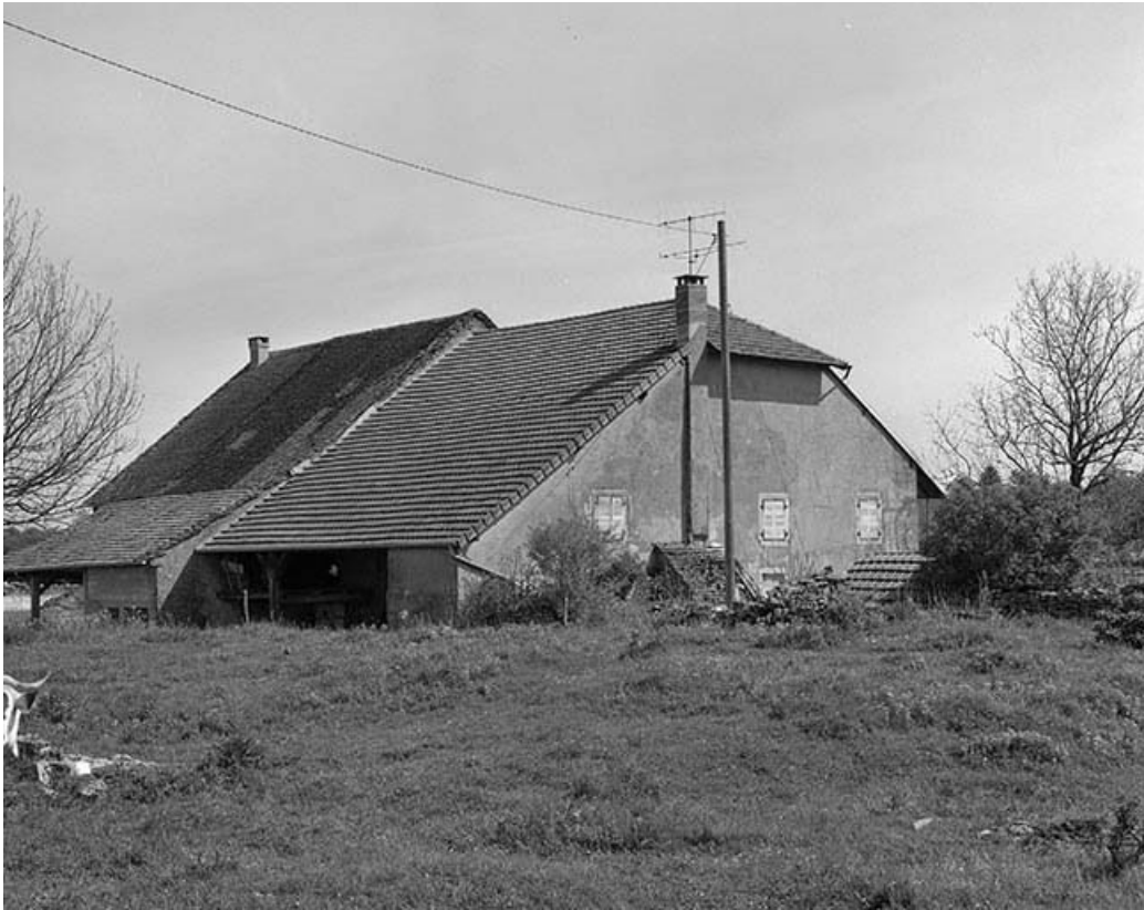
Façade postérieure et façade droite.
