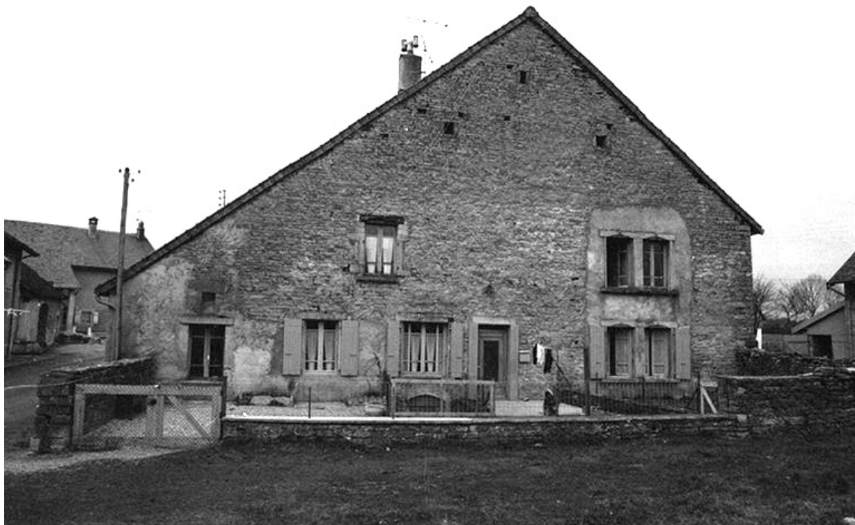
Ferme cadastrée 1940 B 478 située le long du chemin de grande communication n° 68 : façade antérieure. 39, Le Fied
