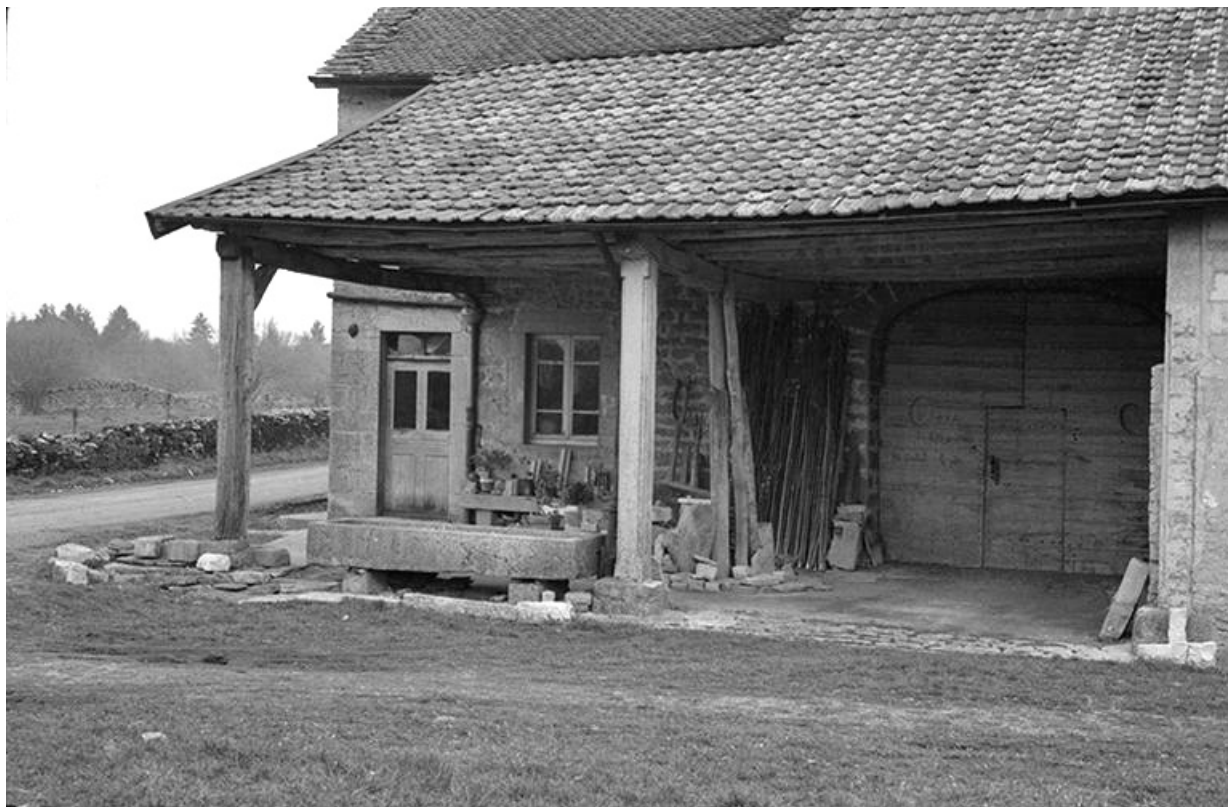
Ferme cadastrée 1940 B4 401 située le long du chemin vicinal ordinaire n° 4, datées de 1864 (?) : façade antérieure. 39, Le Fied
