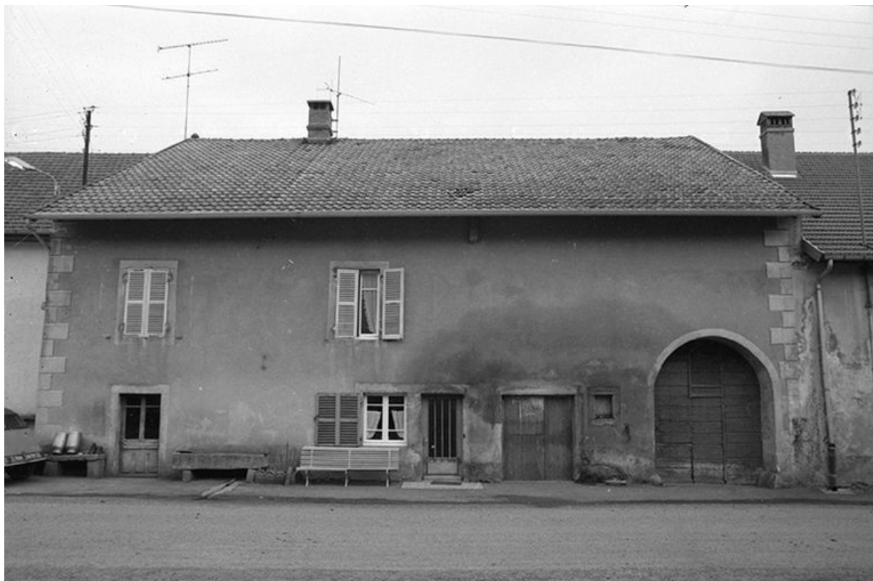
Ferme cadastrée 1940 B4 314 située au lieudit Coin du Dessus : façade antérieure. 39, Le Fied
