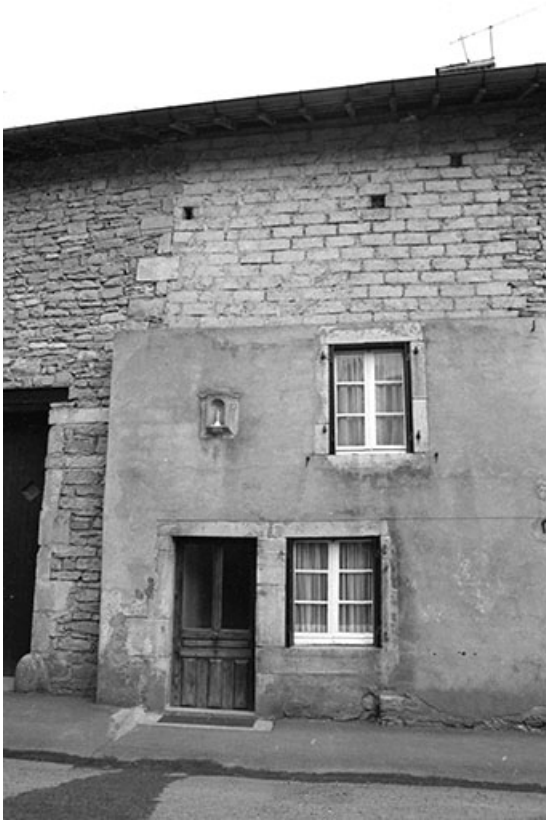
Maison cadastrée 1940 B4 située au lieudit Coin du Dessus, datée de 1728 (?) : façade antérieure. 39, Le Fied
