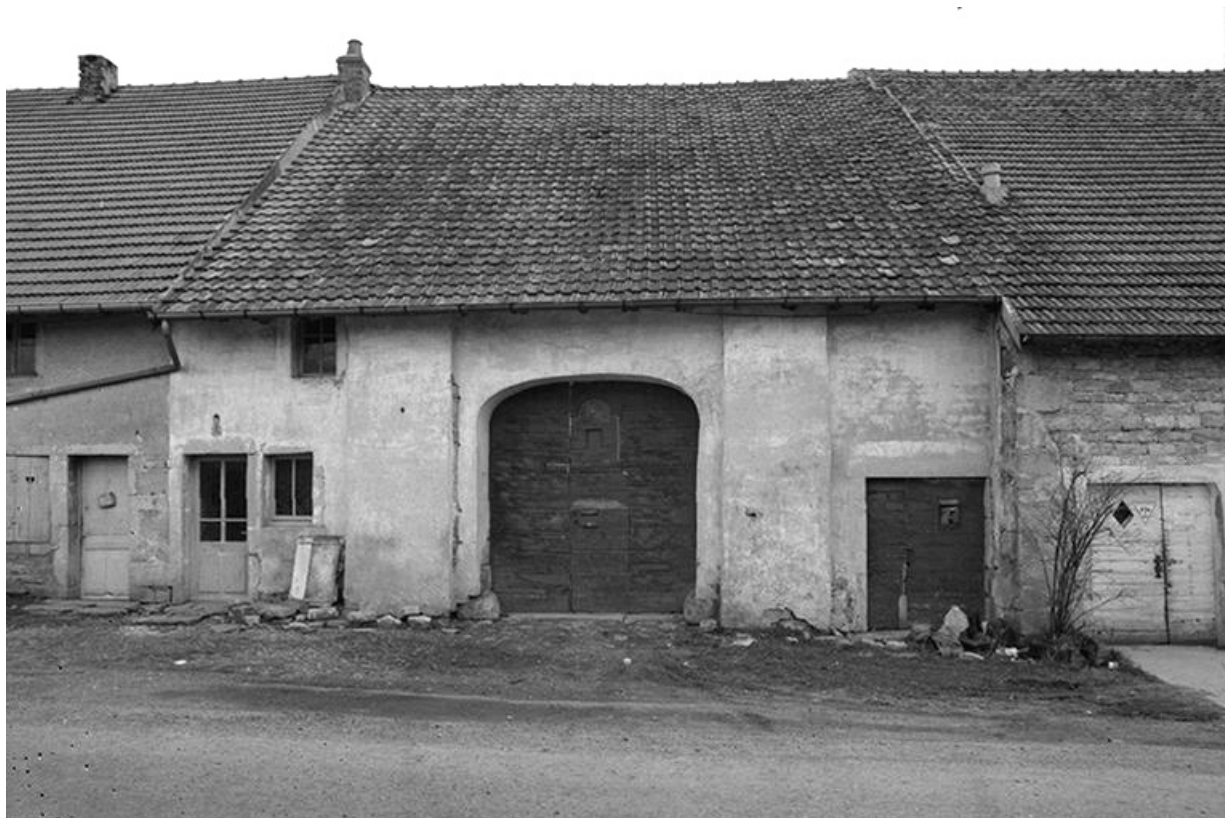
Ferme cadastrée 1940 B4 Coin du Dessus située au lieudit Coin du Dessus : façade antérieure. 39, Le Fied
