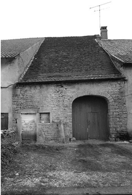
Ferme cadastrée 1940 B4 327 située au lieudit Coin du Dessus : façade postérieure. 39, Le Fied
