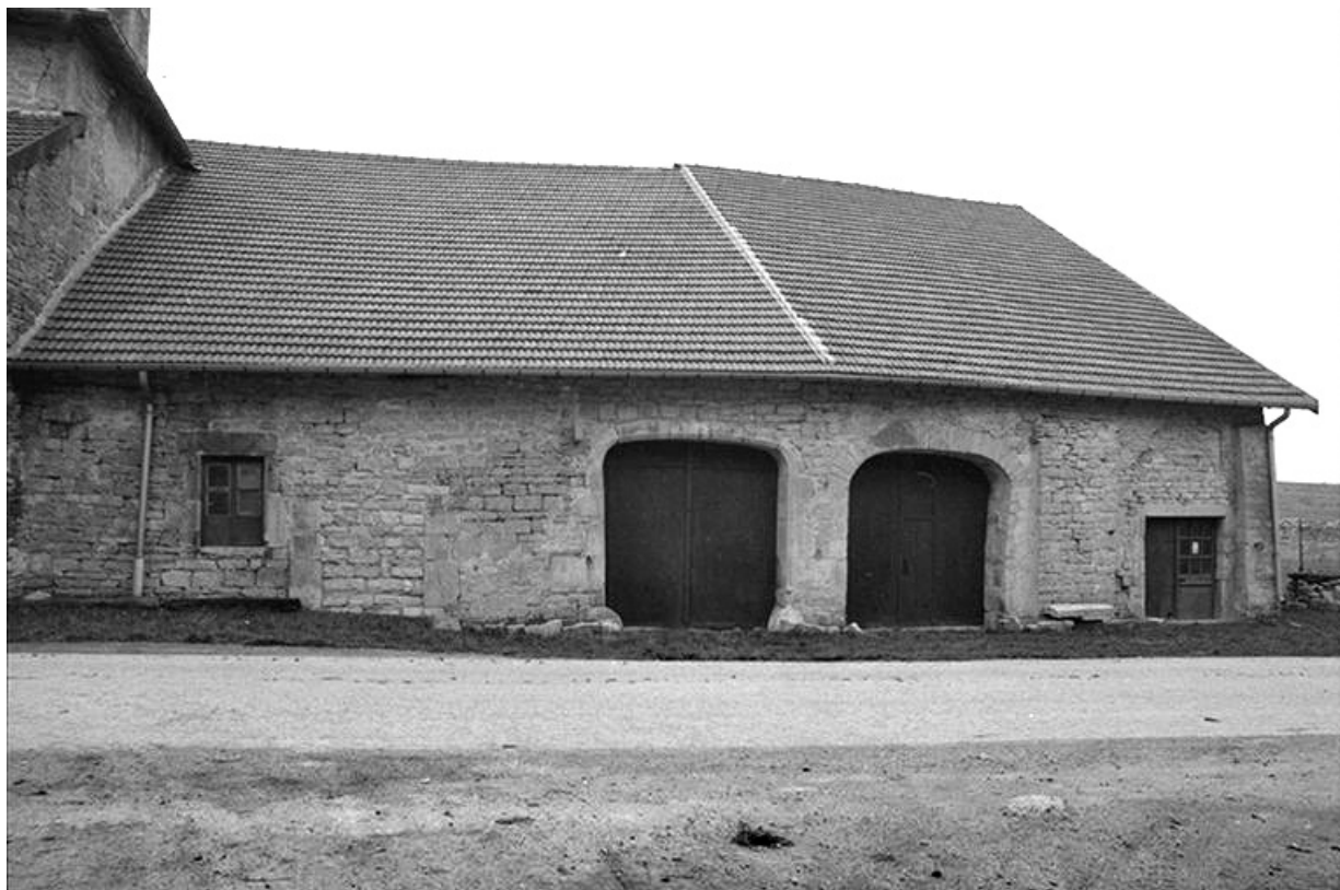
Ferme cadastrée 1940 B2 142 située le long du chemin de grande communication n° 68 : façade sur rue. 39, Le Fied
