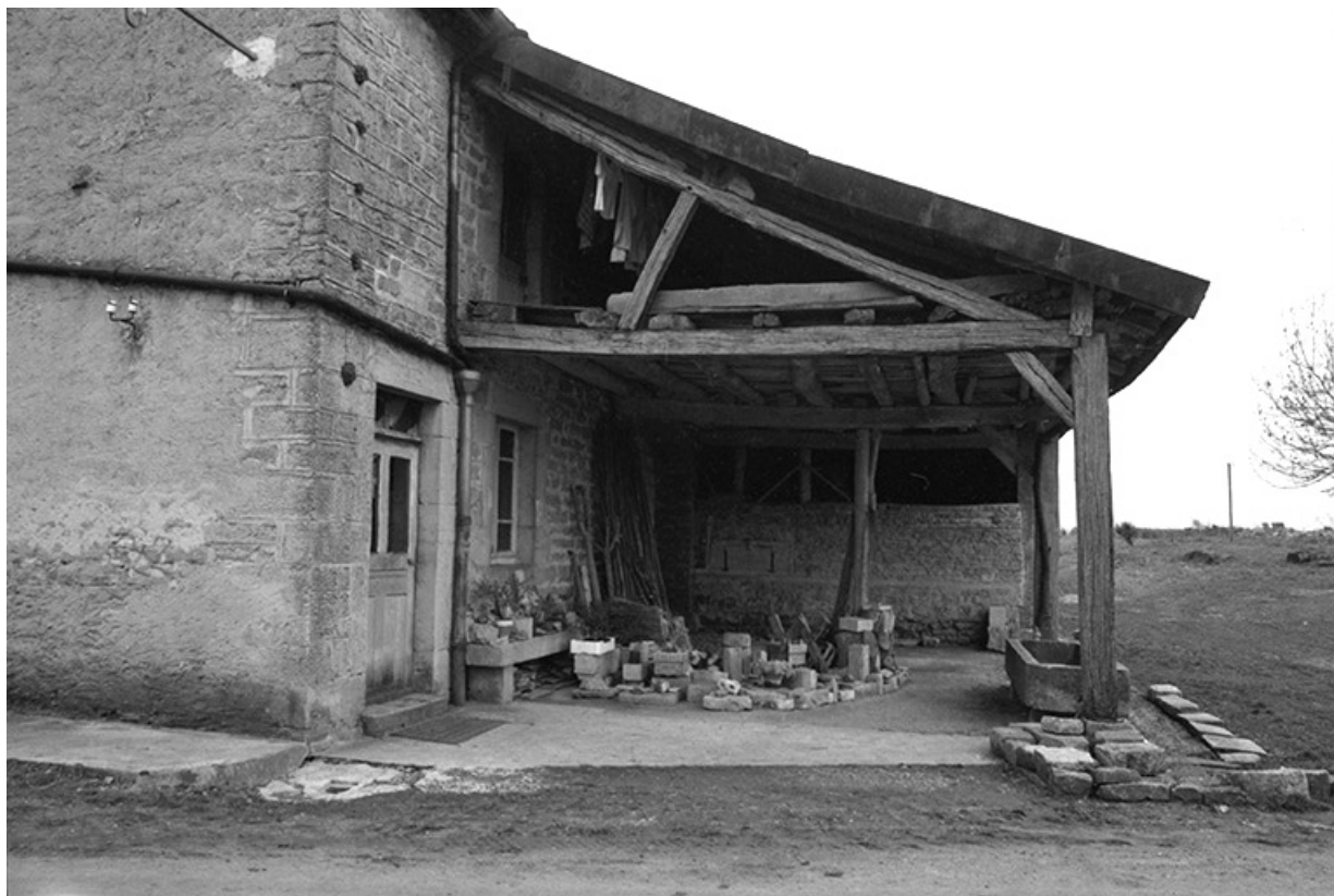
Ferme cadastrée 1940 B4 401 située le long du chemin vicinal ordinaire n° 4 : façade antérieure et avant-toit. 39, Le Fied
