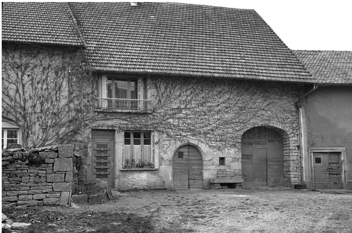
Ferme cadastrée 1940 B2 147 située le long du chemin de grande communication de Poligny à Picarreau : façade antérieure. 39, Le Fied
