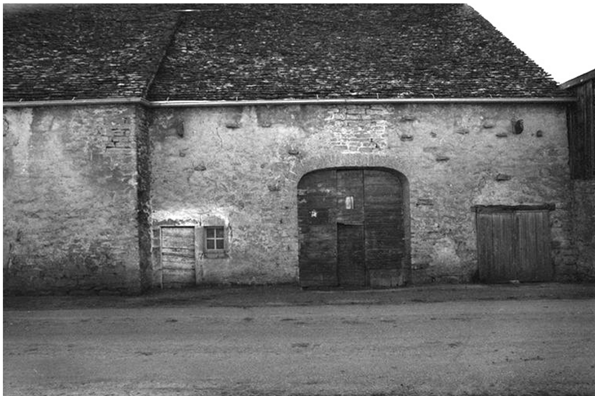
Ferme cadastrée 1940 B4 477, située le long du chemin de grande communication n° 68 : façade sur rue. 39, Le Fied
