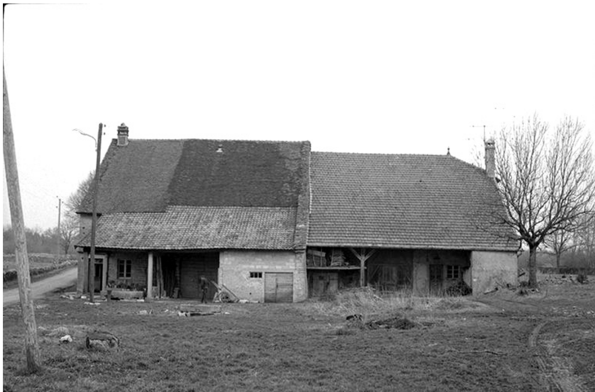
Ferme cadastrées 1940 B4 401-402 situées le long du chemin vicinal ordinaire n° 4, datées de 1864 (?) : vue d'ensemble. 39, Le Fied
