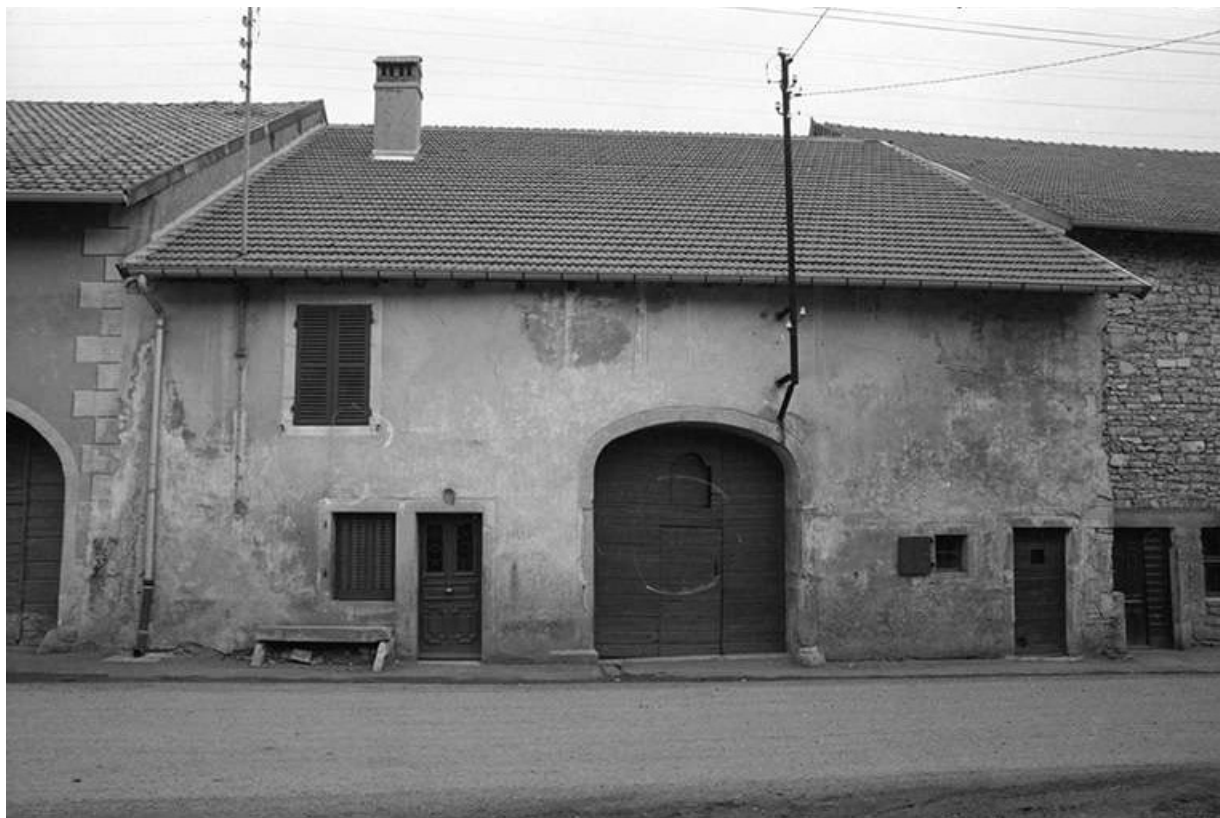
Ferme cadastrée 1940 B4 313 située au lieudit Coin du Dessus : façade antérieure. 39, Le Fied
