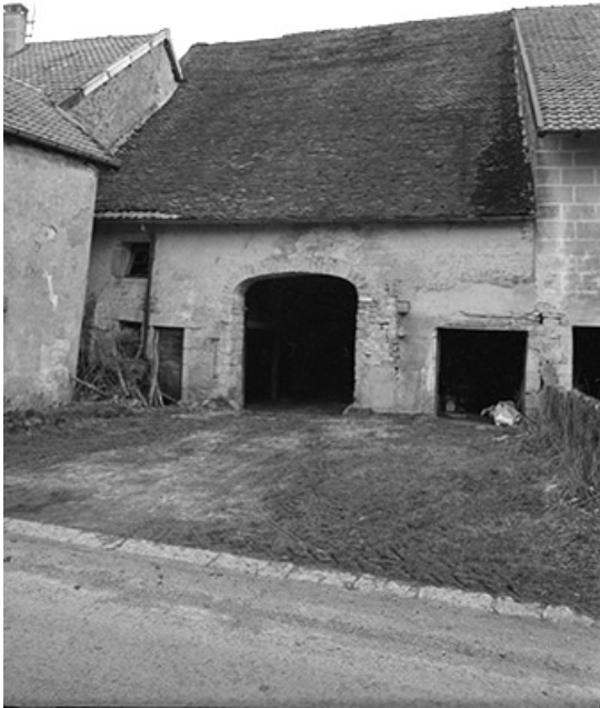
Ferme cadastrée 1940 B4 339 située au lieudit Coin du Dessus : façade sur rue. 39, Le Fied
