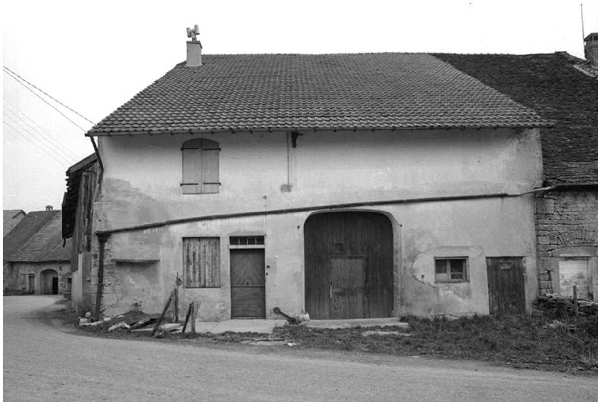
Ferme cadastrée 1940 B4 328 située au lieudit Coin du Dessus : façade antérieure. 39, Le Fied
