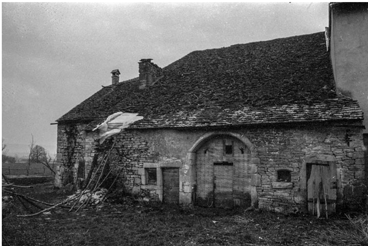
Ferme cadastrée 1940 B4 291 située le long du chemin vicinal n° 3 : façade antérieure. 39, Le Fied
