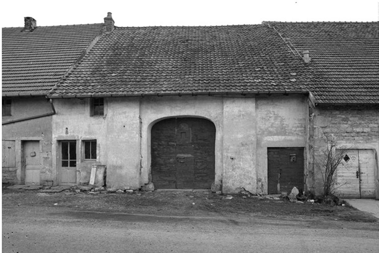
Ferme cadastrée 1940 B4 Coin du Dessus située au lieudit Coin du Dessus : façade antérieure. 39, Le Fied
