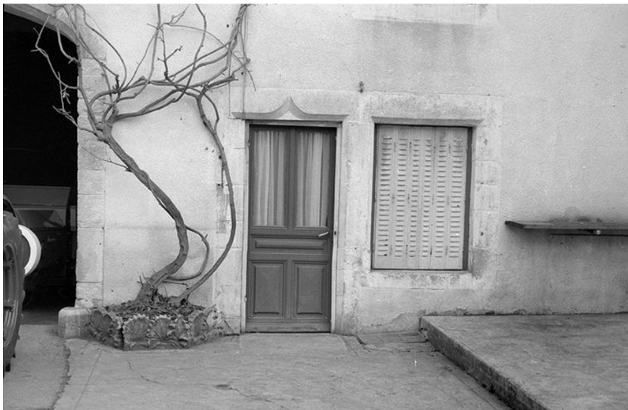
Ferme cadastrée 1940 B4 323 située le long du chemin de grande communication de Poligny à Picarreau : façade antérieure. 39, Le Fied
