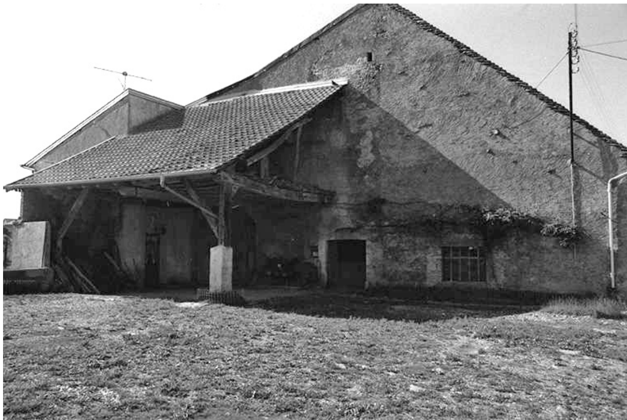
Ferme cadastrée 1940 B4 477, située le long du chemin de grande communication n° 68 : façade postérieure. 39, Le Fied
