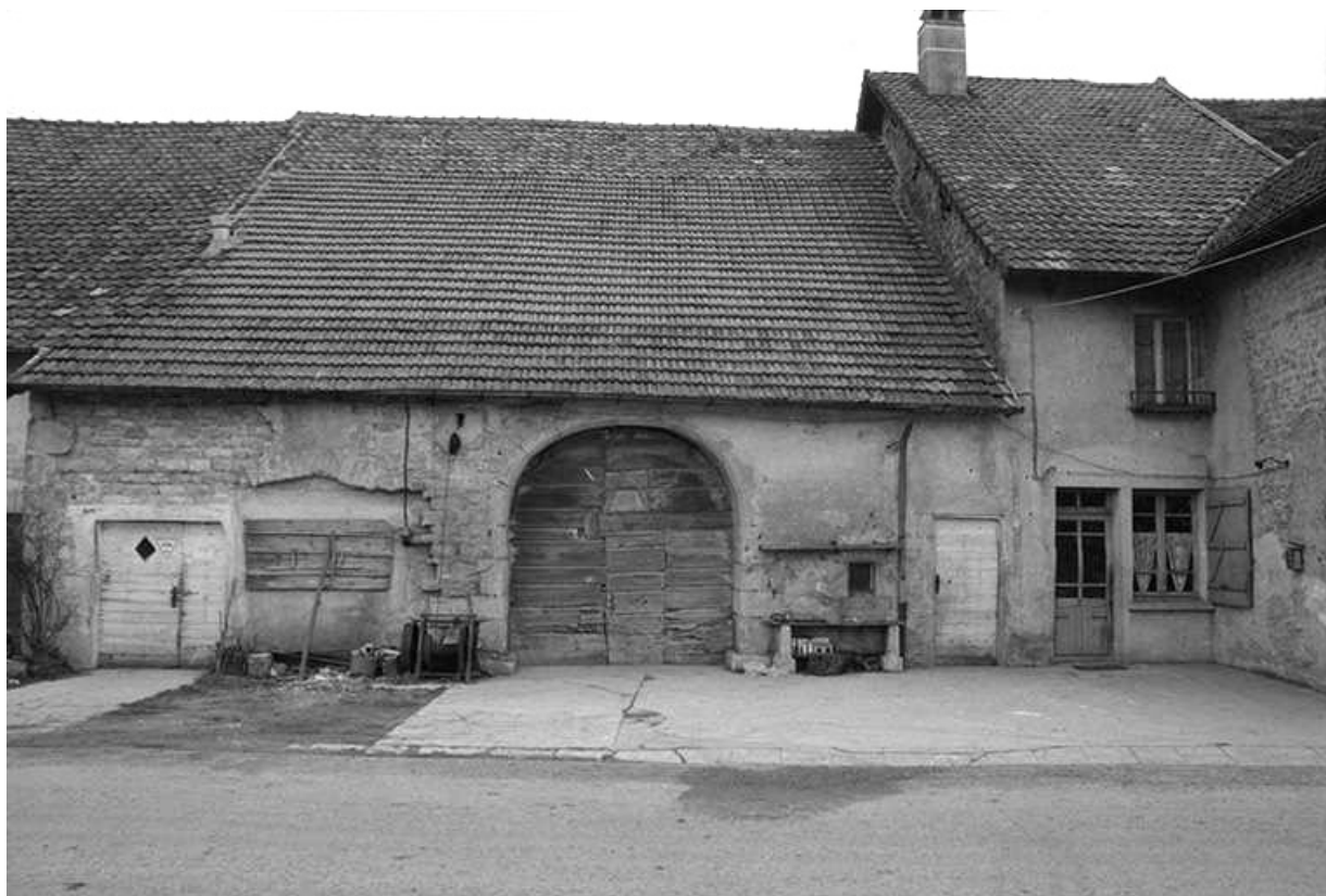
Ferme cadastrée 1940 B4 340 située au lieudit Coin du Dessus : façade antérieure. 39, Le Fied
