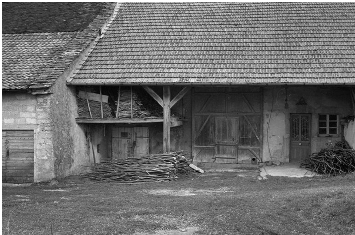
Ferme cadastrée 1940 B4 402 située le long du chemin vicinal ordinaire n° 4, datées de 1864 (?) : façade antérieure. 39, Le Fied
