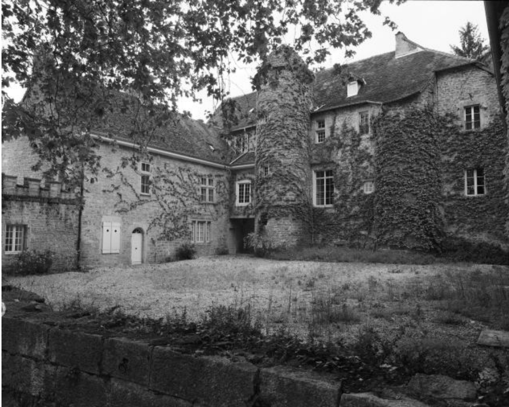
Façade sur cour et aile gauche.
