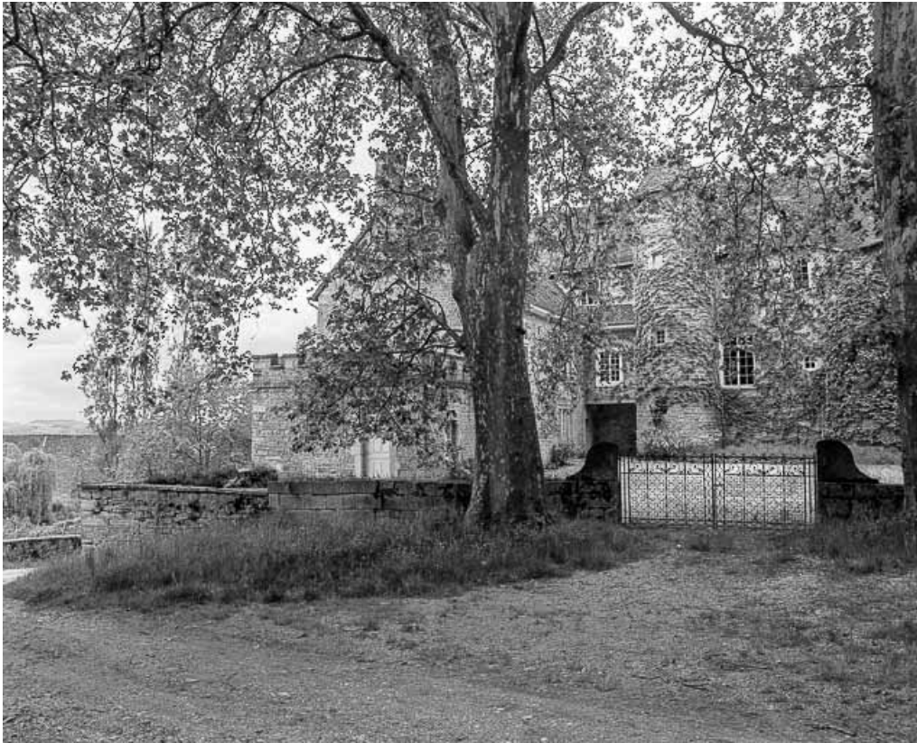
Façade sur cour et portail d'entrée.
