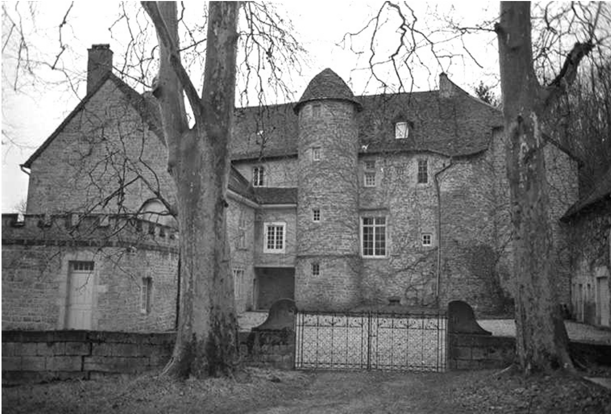
Façade sur cour et portail d'entrée.
