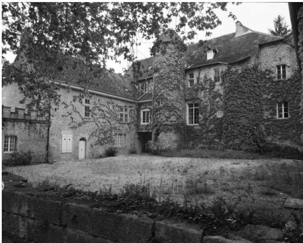
Façade sur cour et aile gauche.
