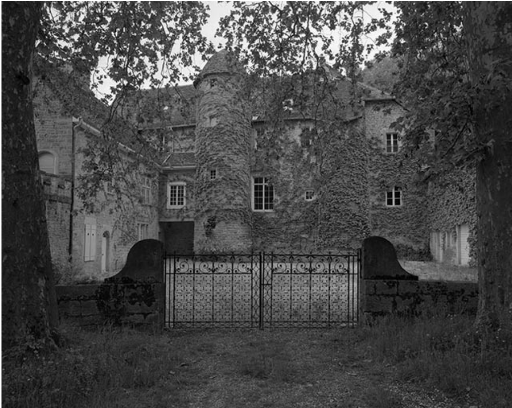
Façade sur cour et portail d'entrée.
