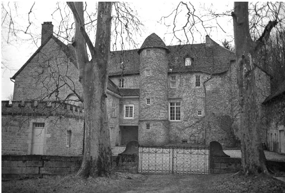
Façade sur cour et portail d'entrée.
