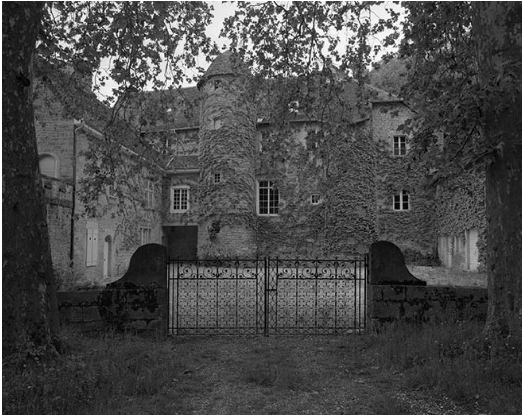
Façade sur cour et portail d'entrée.
