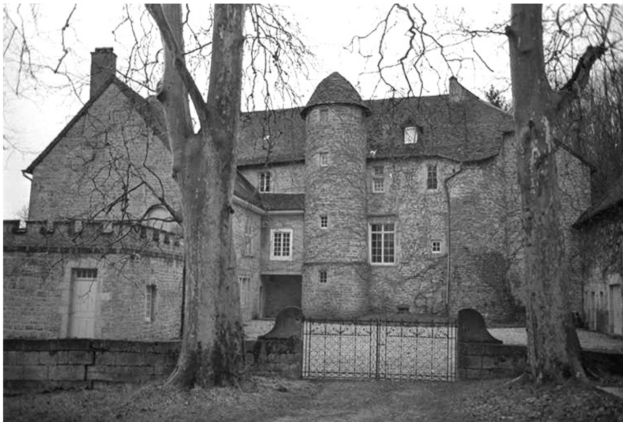
Façade sur cour et portail d'entrée.
