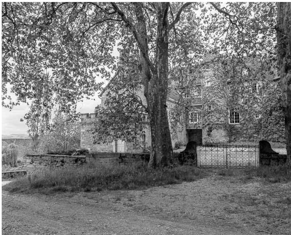
Façade sur cour et portail d'entrée.
