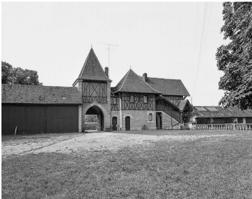
Bâtiment d'entrée : façade nord.
