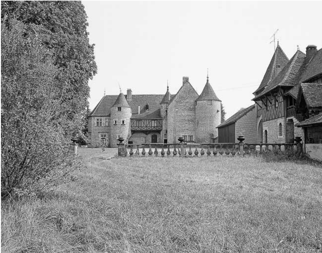
Vue générale depuis l'est 39, Domblans rue de l'Église
