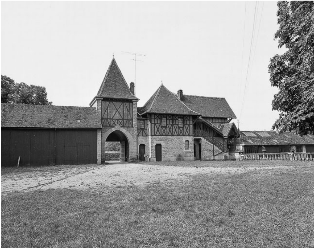
Bâtiment d'entrée : façade nord.
