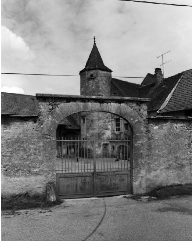
Vue du portail depuis la rue.
