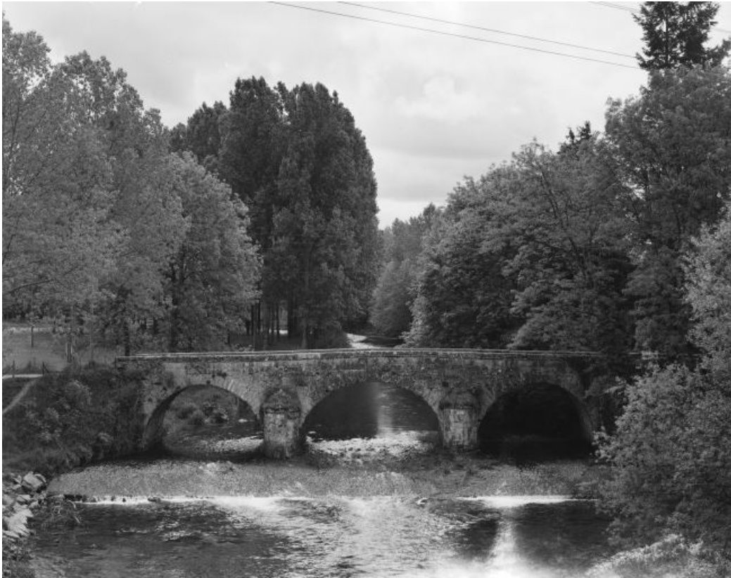
Face aval, vue de face.
