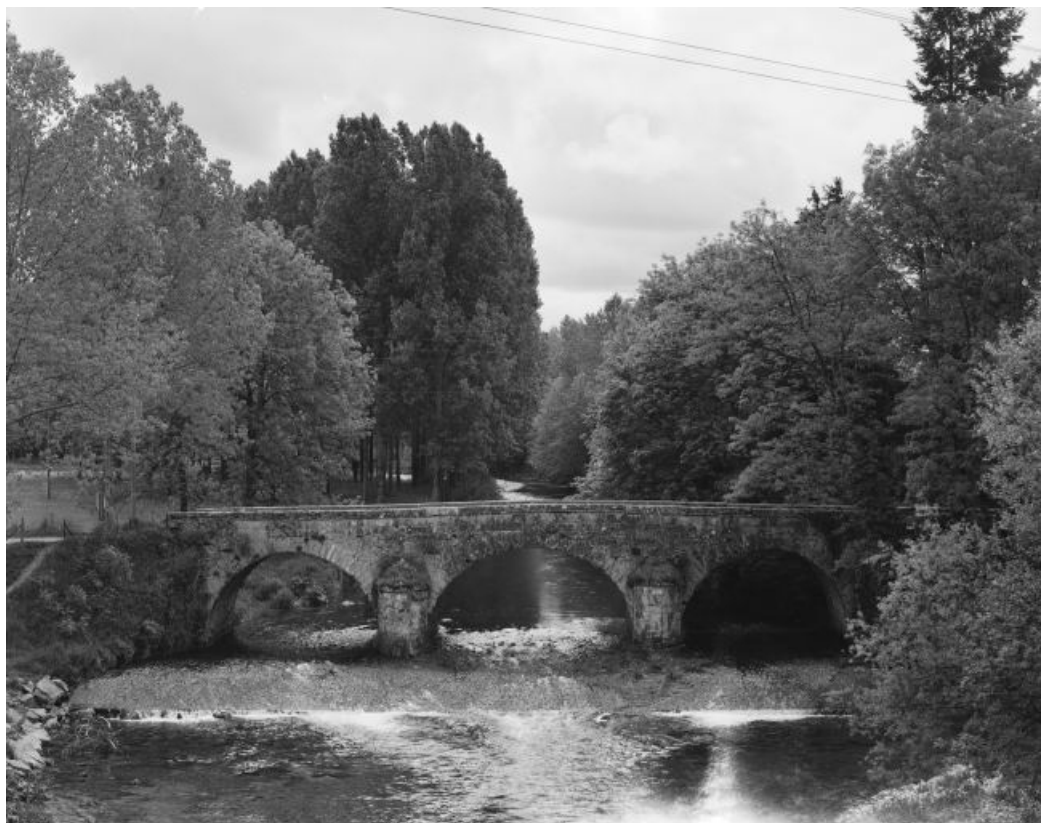
Face aval, vue de face.
