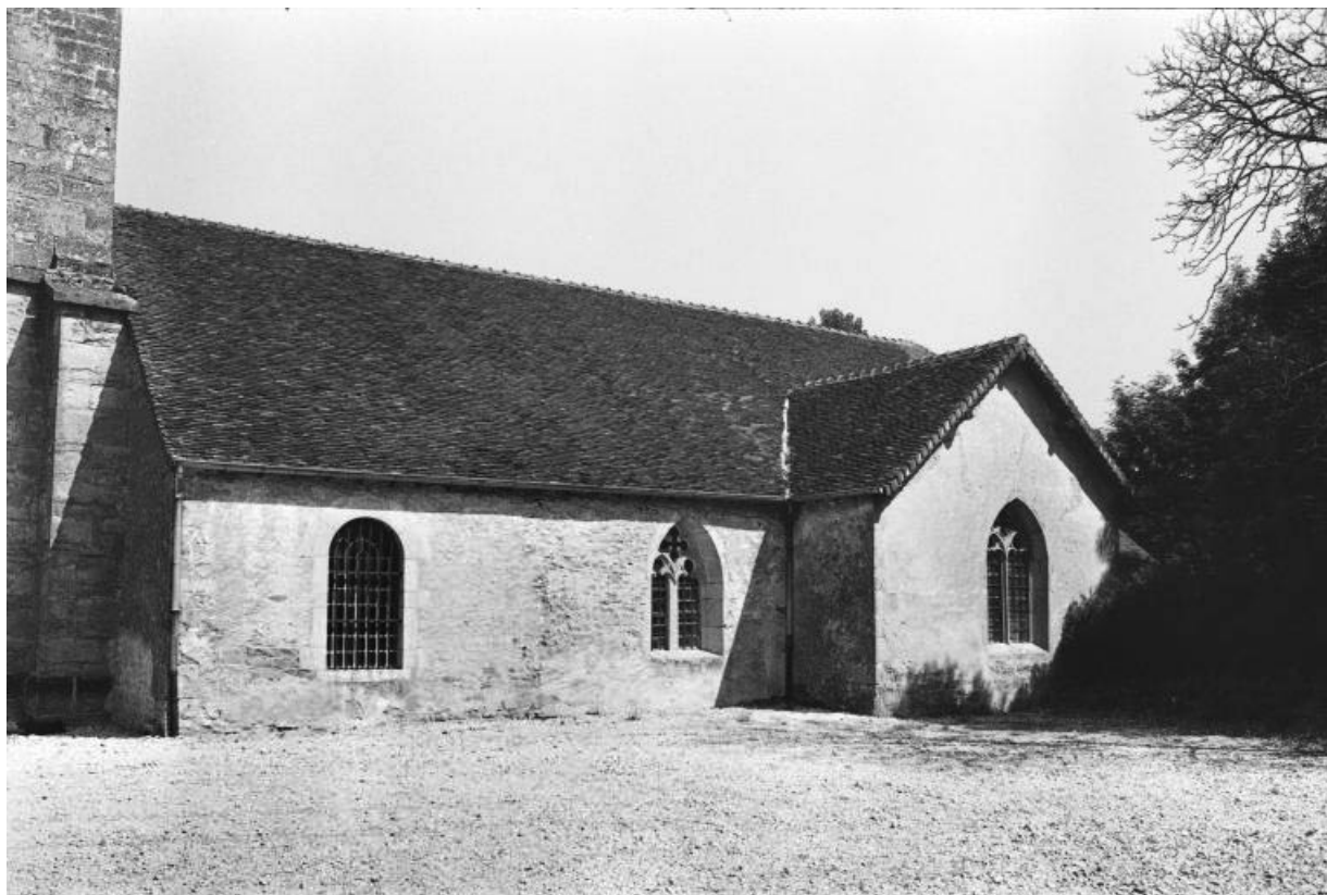
Façade latérale droite.
