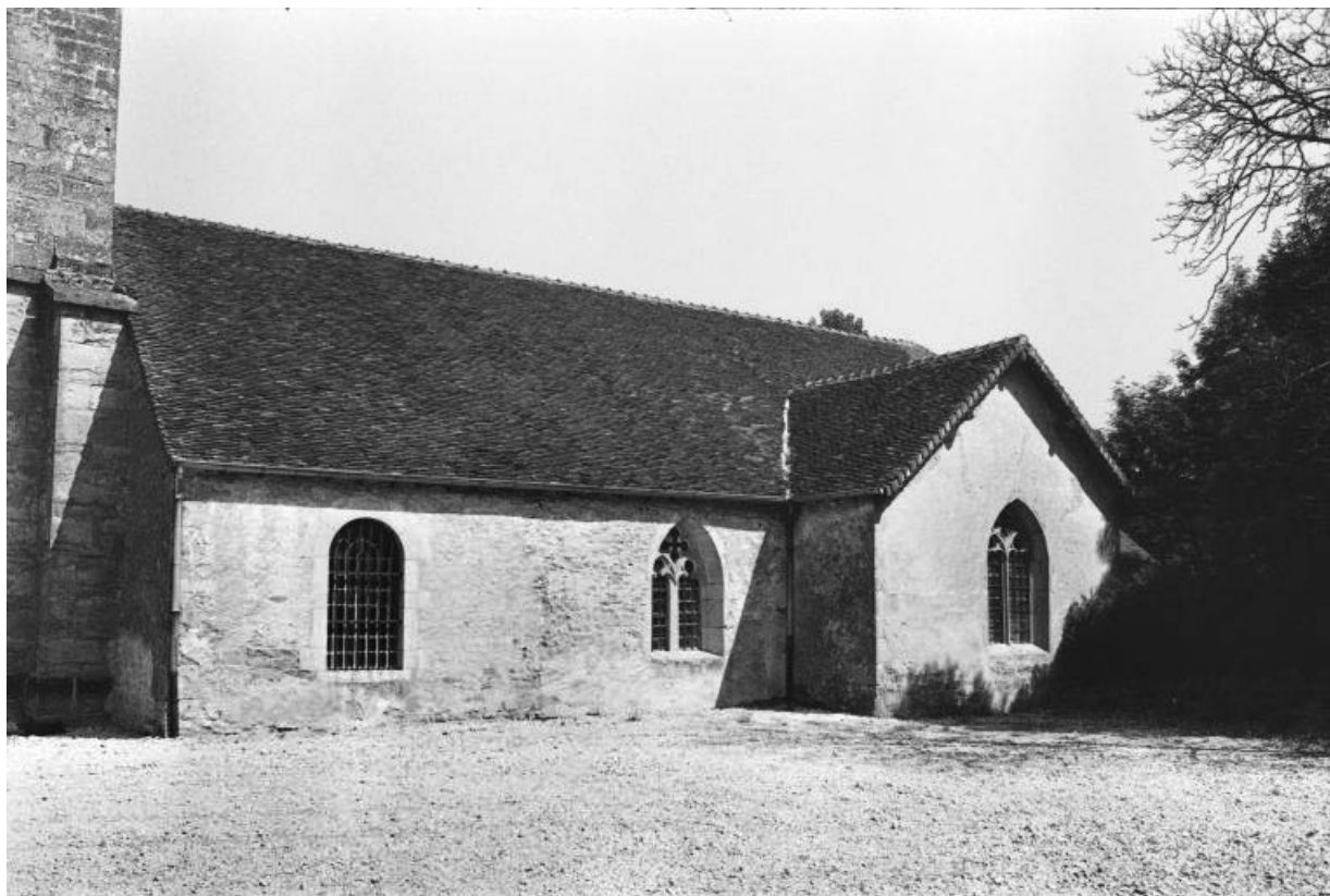
Façade latérale droite.
