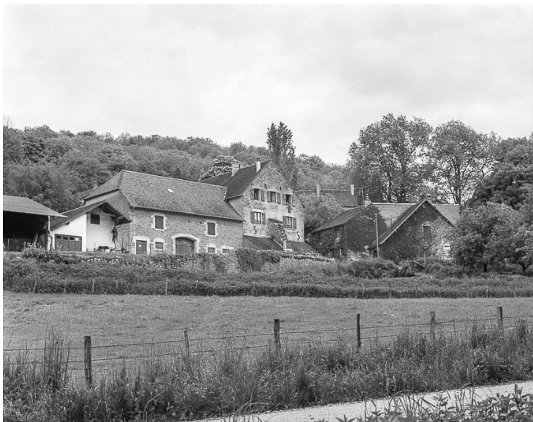
Maisons et fermes situées à Blandans : façades antérieures.
