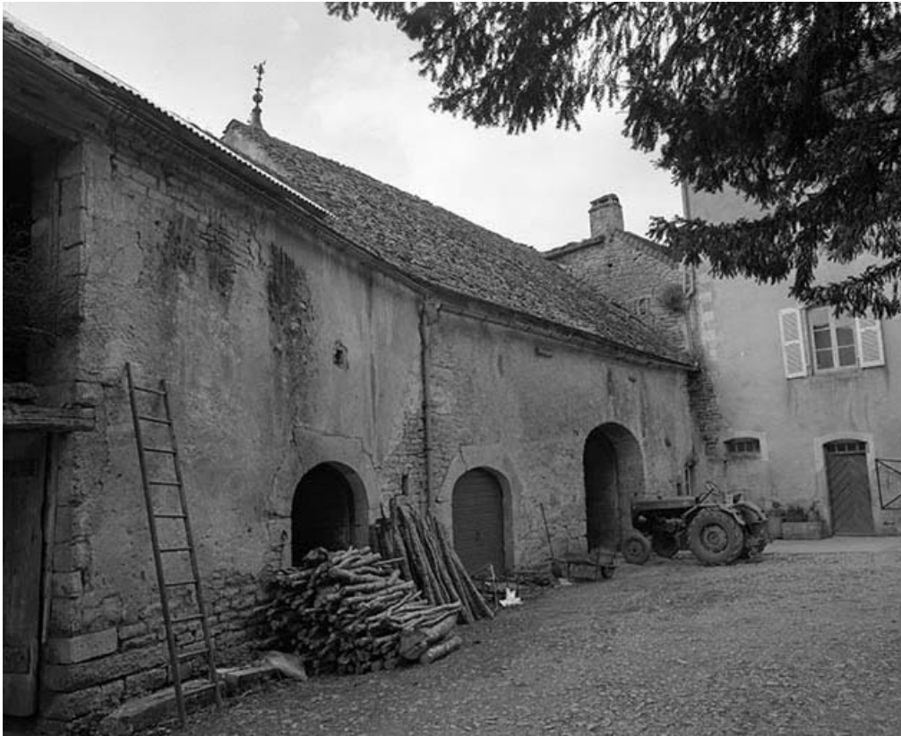
Dépendances : élévation sur cour de trois quarts.
