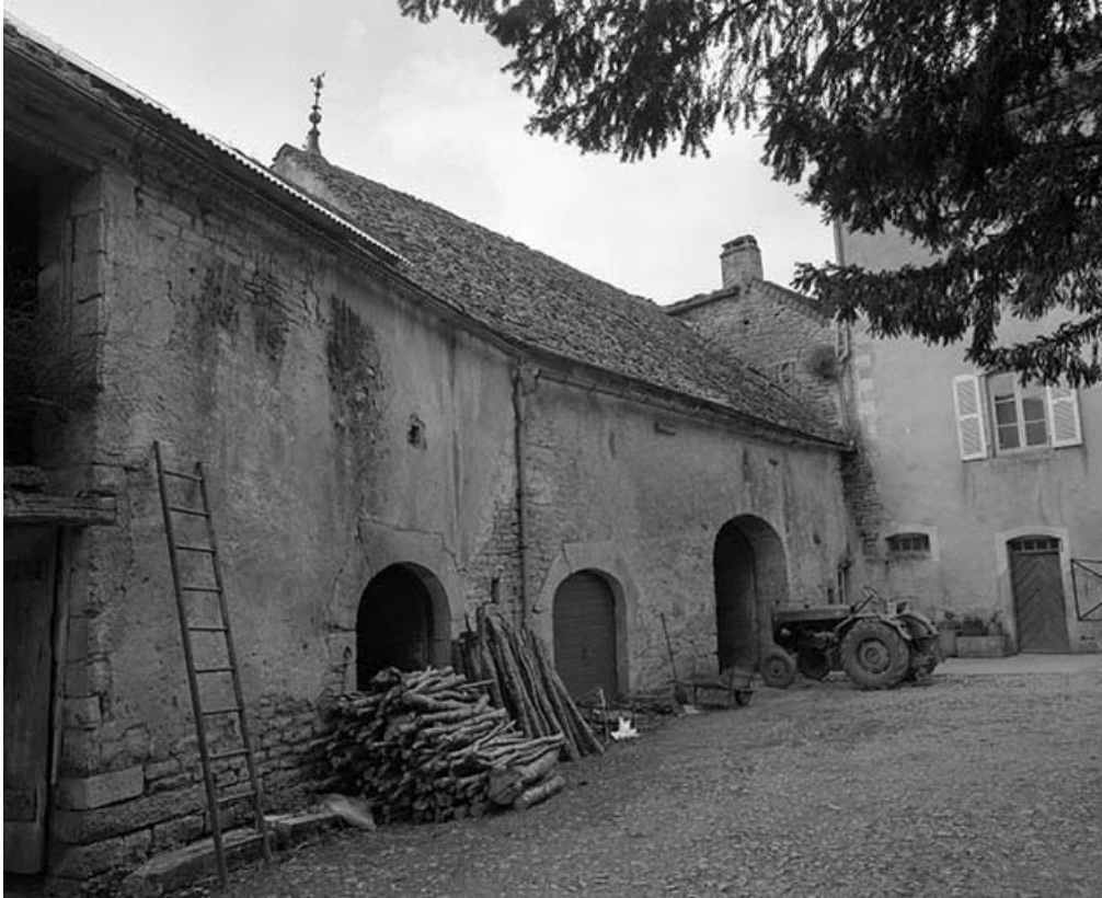
Dépendances : élévation sur cour de trois quarts.
