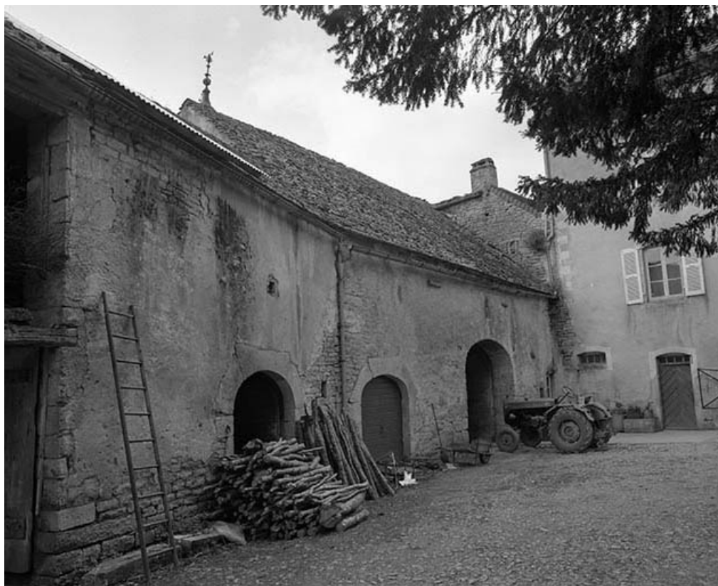
Dépendances : élévation sur cour de trois quarts.
