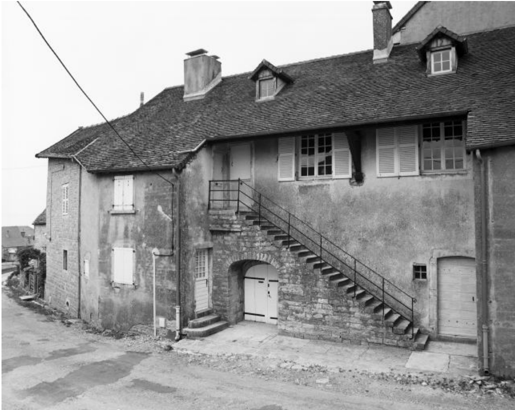
Façade antérieure. 39, Château-Chalon
