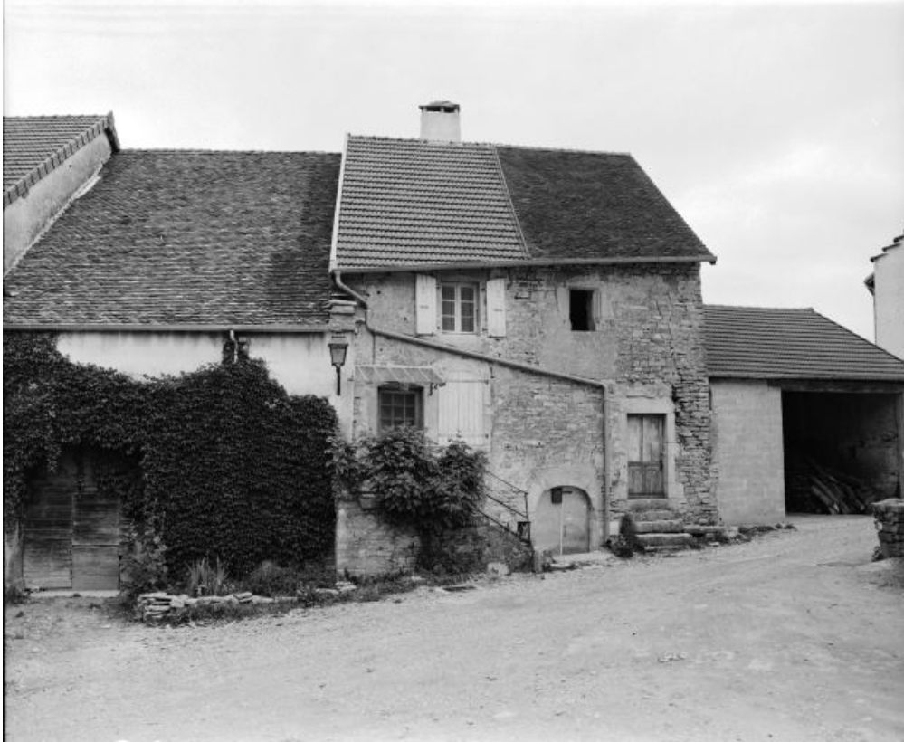
Façade antérieure. 39, Château-Chalon
