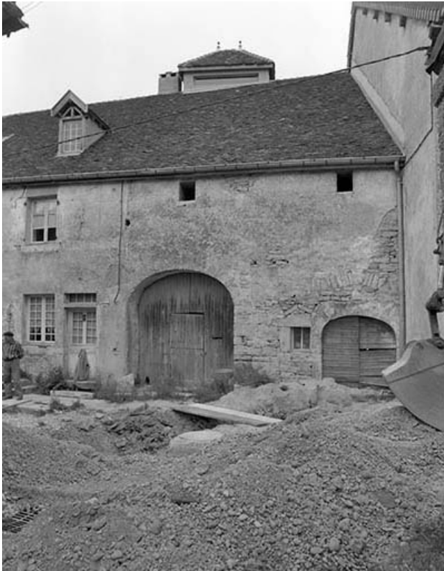
Façade antérieure, partie droite.
