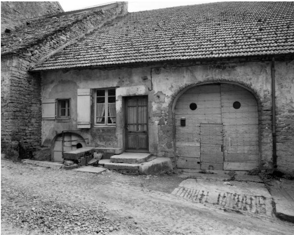
Façade antérieure, vue de face. 39, Château-Chalon
