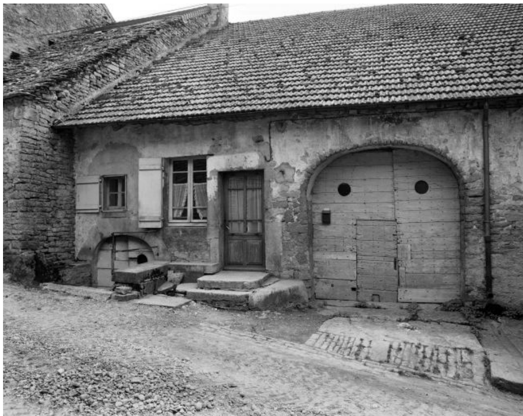
Façade antérieure, vue de face.
