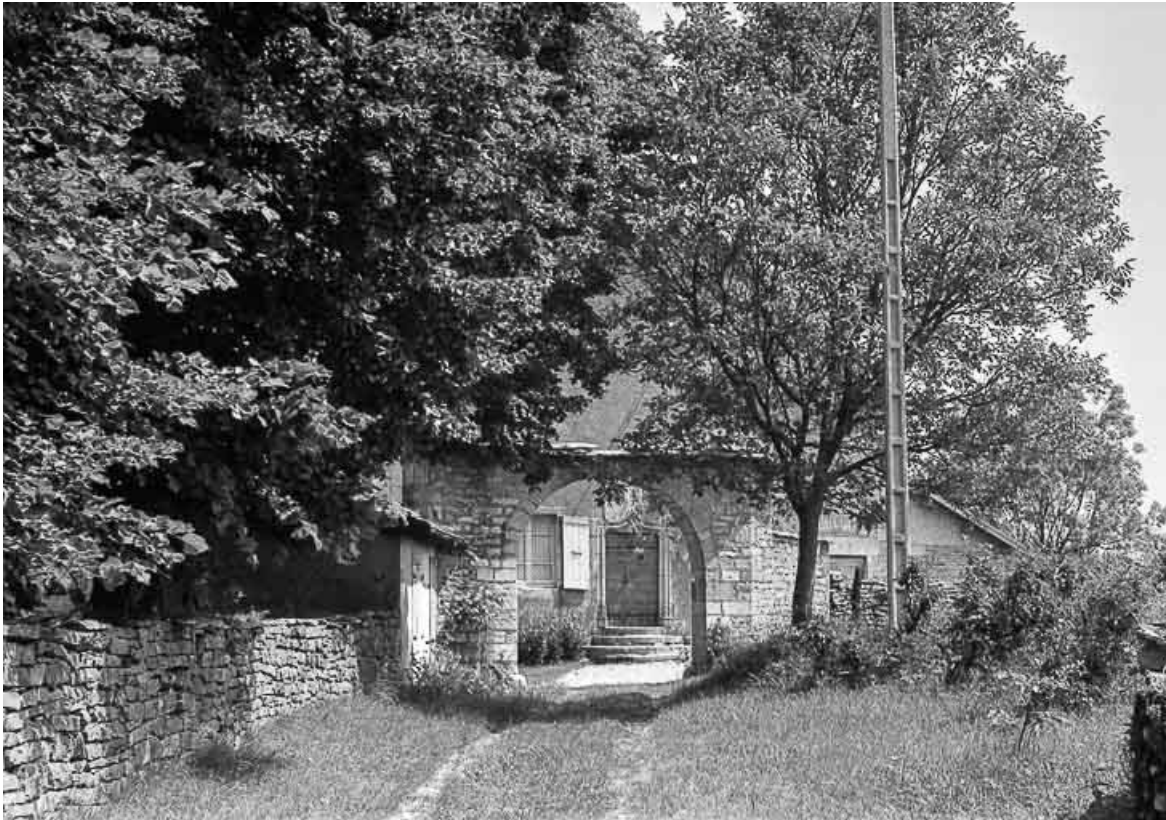
Porte surmontée d'un arc en accolade : vue depuis le porche d'entrée.
