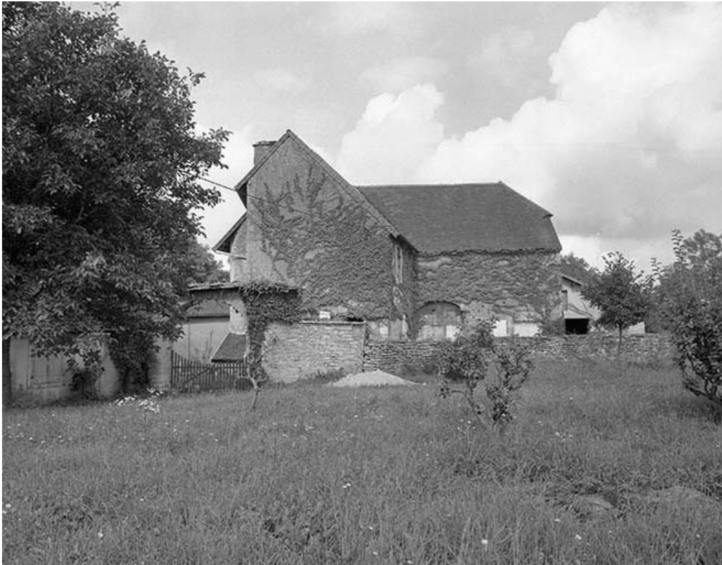
Vue générale depuis le sud.
