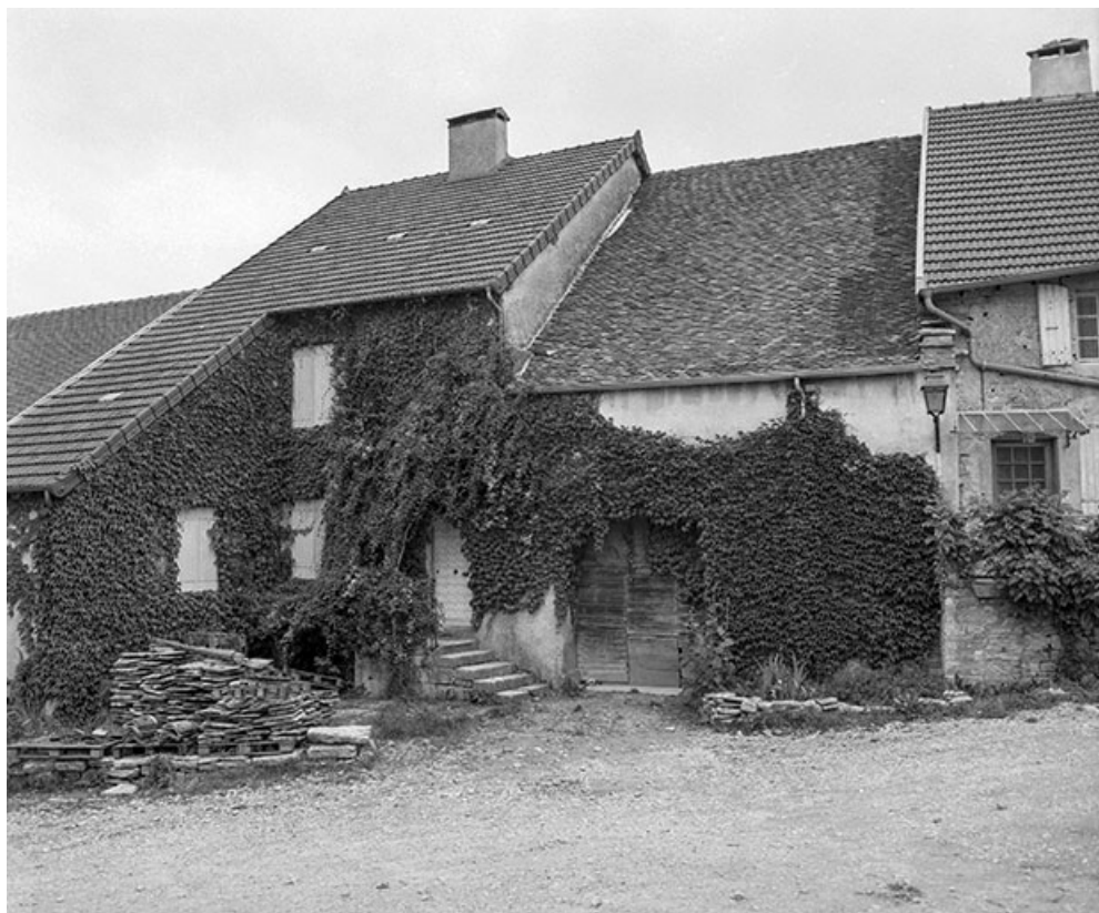
Maison cadastrée 1965 AB 206, située rue de l'Eglise : façade antérieure. 39, Château-Chalon
