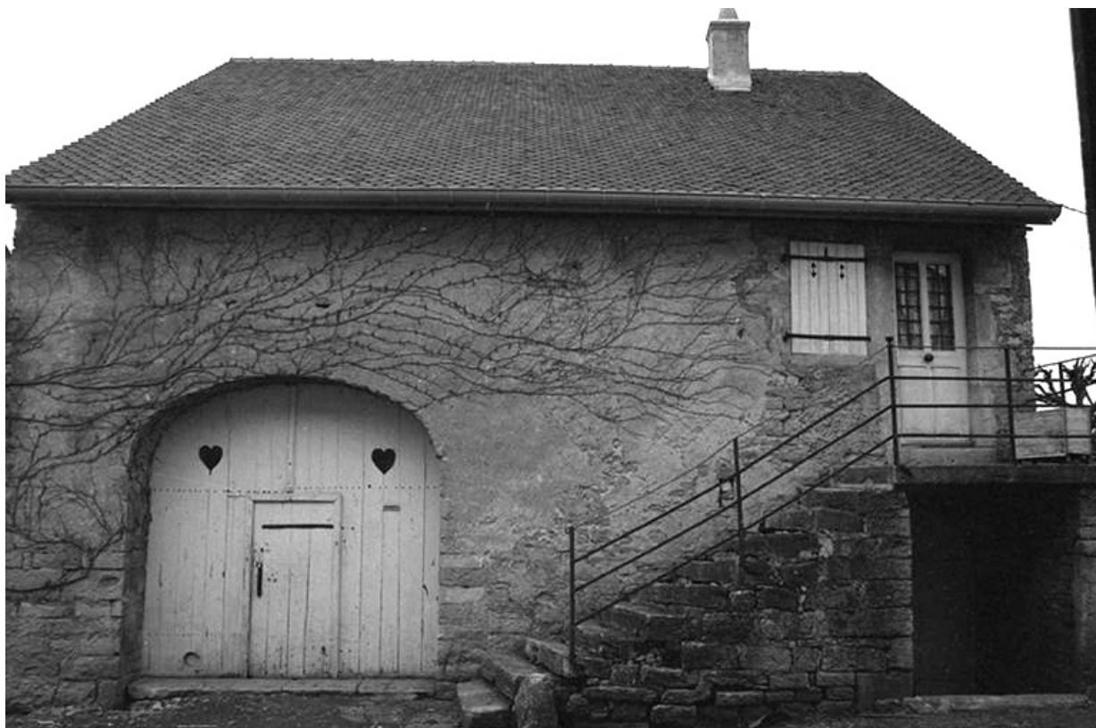
Maison de vigneron (?) cadastrée 1965 AB 186, située rue de la Roche : façade antérieure. 39, Château-Chalon
