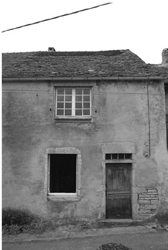
Ferme cadastrée 1965 AB 246, située rue de la Roche : partie habitation. 39, Château-Chalon
