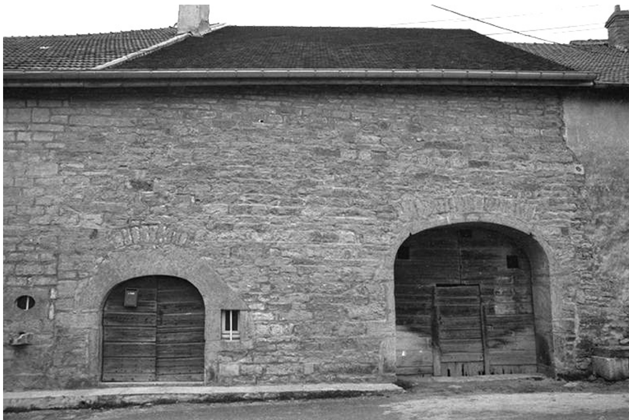
Ferme cadastrée 1965 AB 249 et 252 : façade antérieure. 39, Château-Chalon
