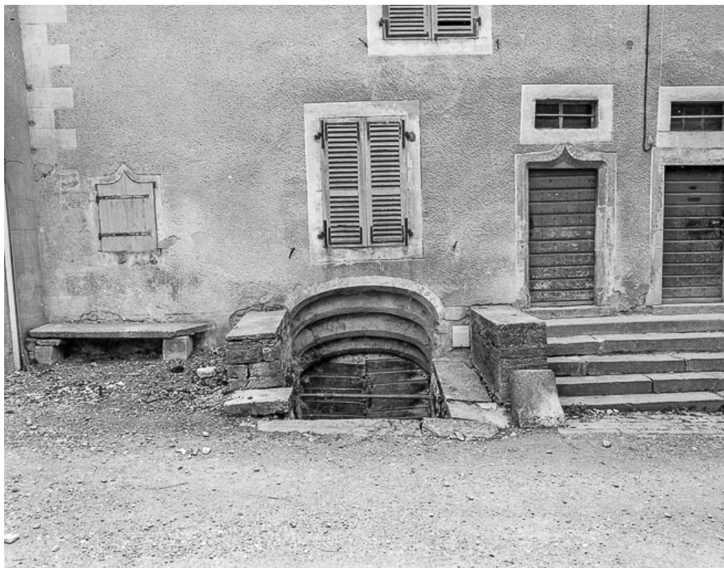
Maison située rue de l'Eglise : porte de cave. 39, Château-Chalon
