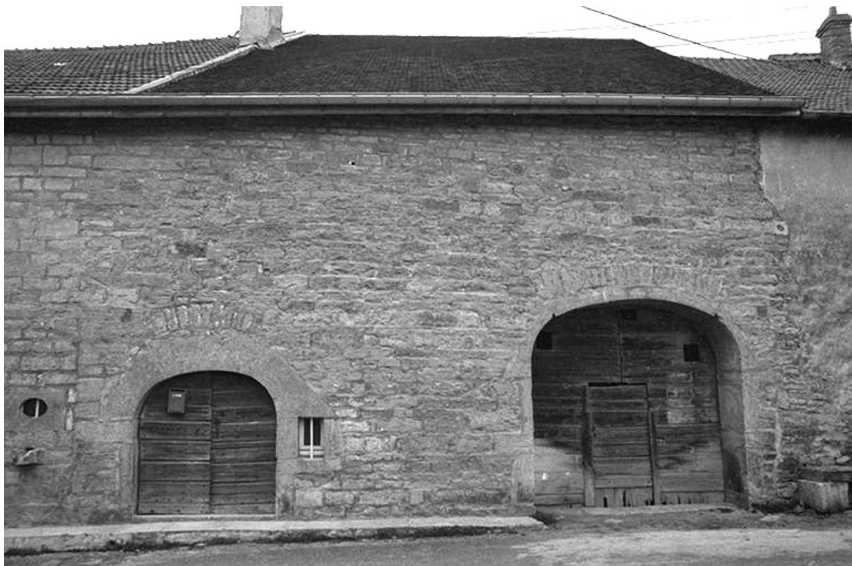
Ferme cadastrée 1965 AB 249 et 252 : façade antérieure. 39, Château-Chalon
