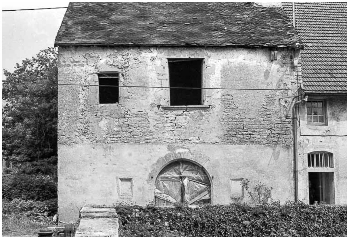
Maison attenante au presbytère : façade postérieure.
