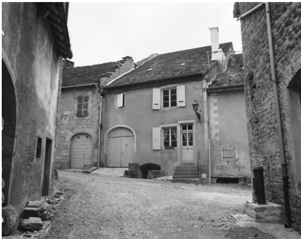
Façade antérieure. 39, Château-Chalon
