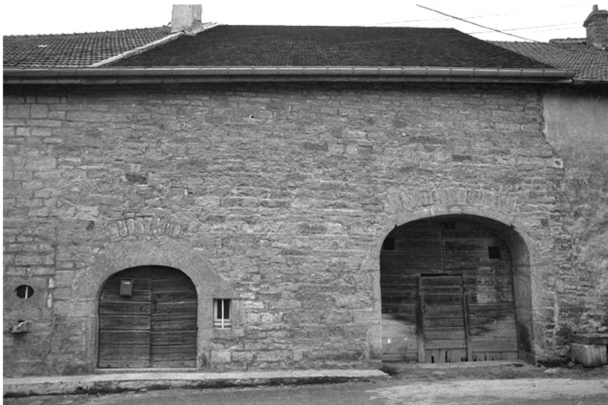
Ferme cadastrée 1965 AB 249 et 252 : façade antérieure. 39, Château-Chalon
