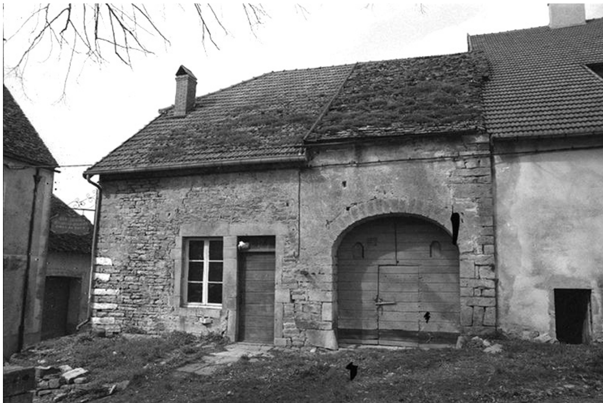
Ferme cadastrée 1965 AB 205, située rue de l'Eglise : façade antérieure. Une partie du toit est en laves. 39, Château-Chalon
