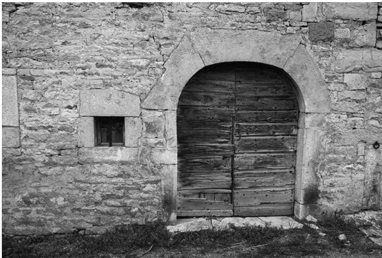
Ferme cadastrée 1965 AB 253, située rue de la Roche : porte de la grange. 39, Château-Chalon
