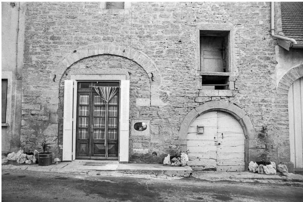
Ferme cadastrée 1965 AB 96, située le long du chemin départemental n° 5 : façade antérieure. 39, Château-Chalon
