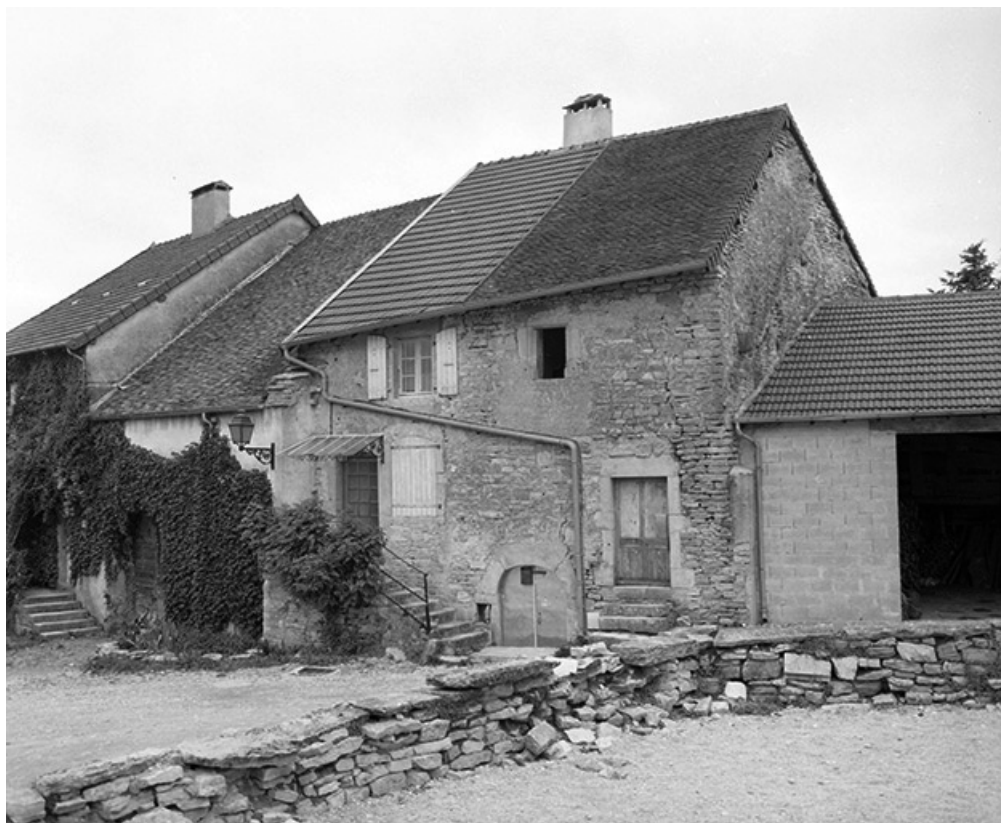
Maison située rue de l'Eglise : façade antérieure.
