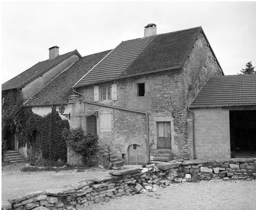
Maison située rue de l'Eglise : façade antérieure.
