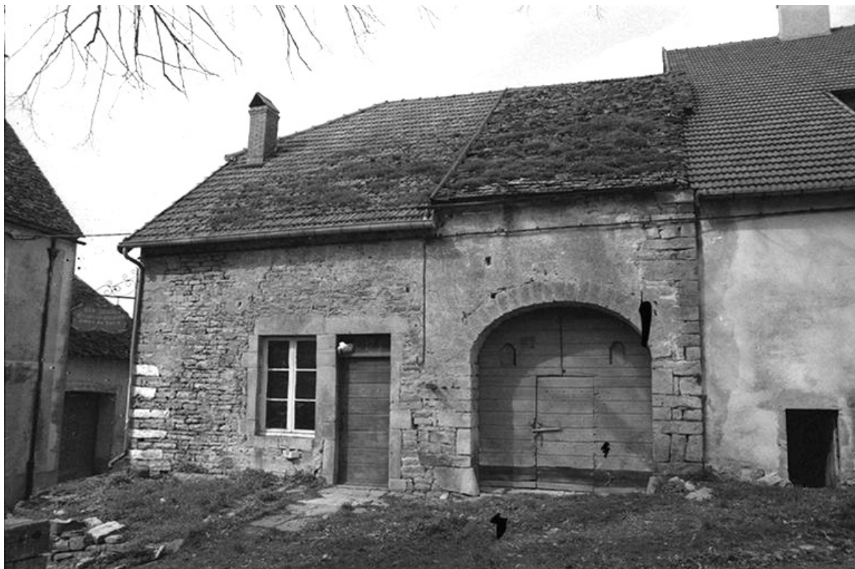
Ferme cadastrée 1965 AB 205, située rue de l'Eglise : façade antérieure. Une partie du toit est en laves. 39, Château-Chalon
