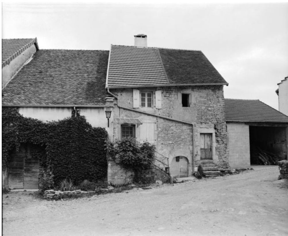
Façade antérieure. 39, Château-Chalon
