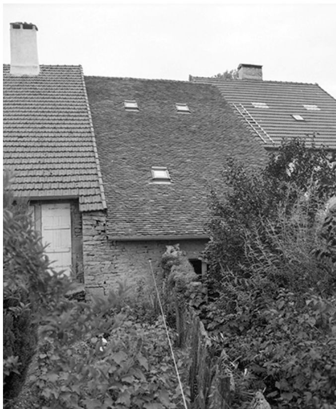
Maisons situées rue de l'Eglise : façades postérieures. 39, Château-Chalon
