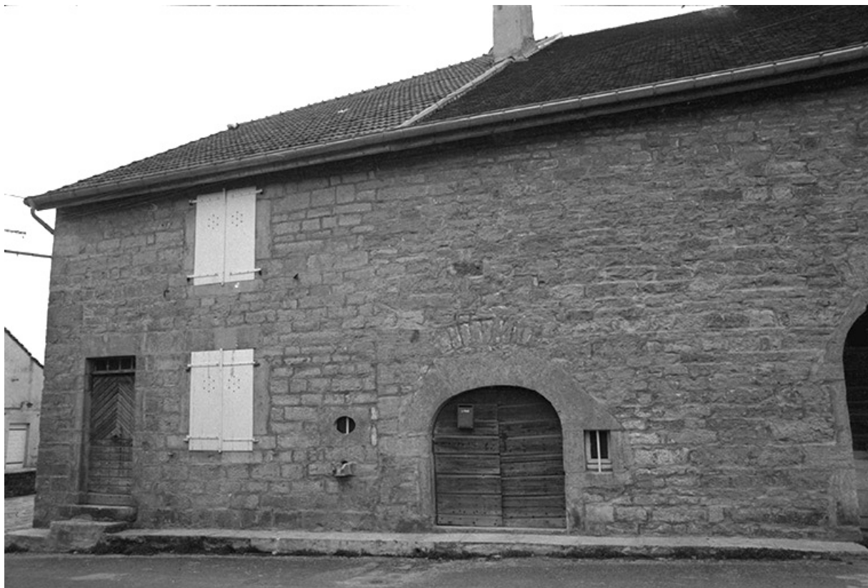
Ferme cadastrée 1965 AB 249 et 252 : façade antérieure. 39, Château-Chalon
