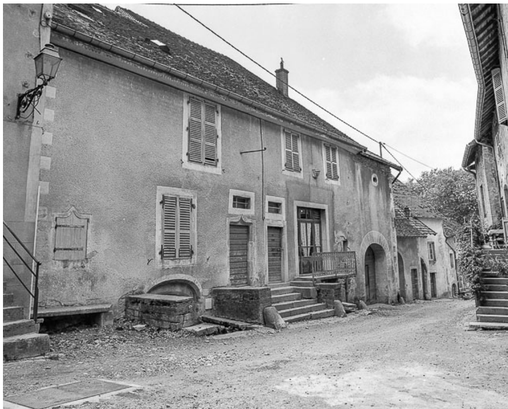
Maison située rue de l'Eglise : façade antérieure.
