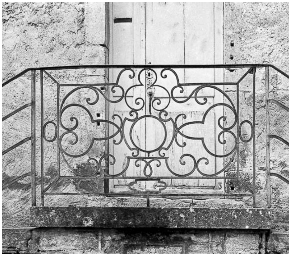
Maison située rue de la Roche, avec escalier à double volée: détail de la rampe en fer forgé. 39, Château-Chalon
