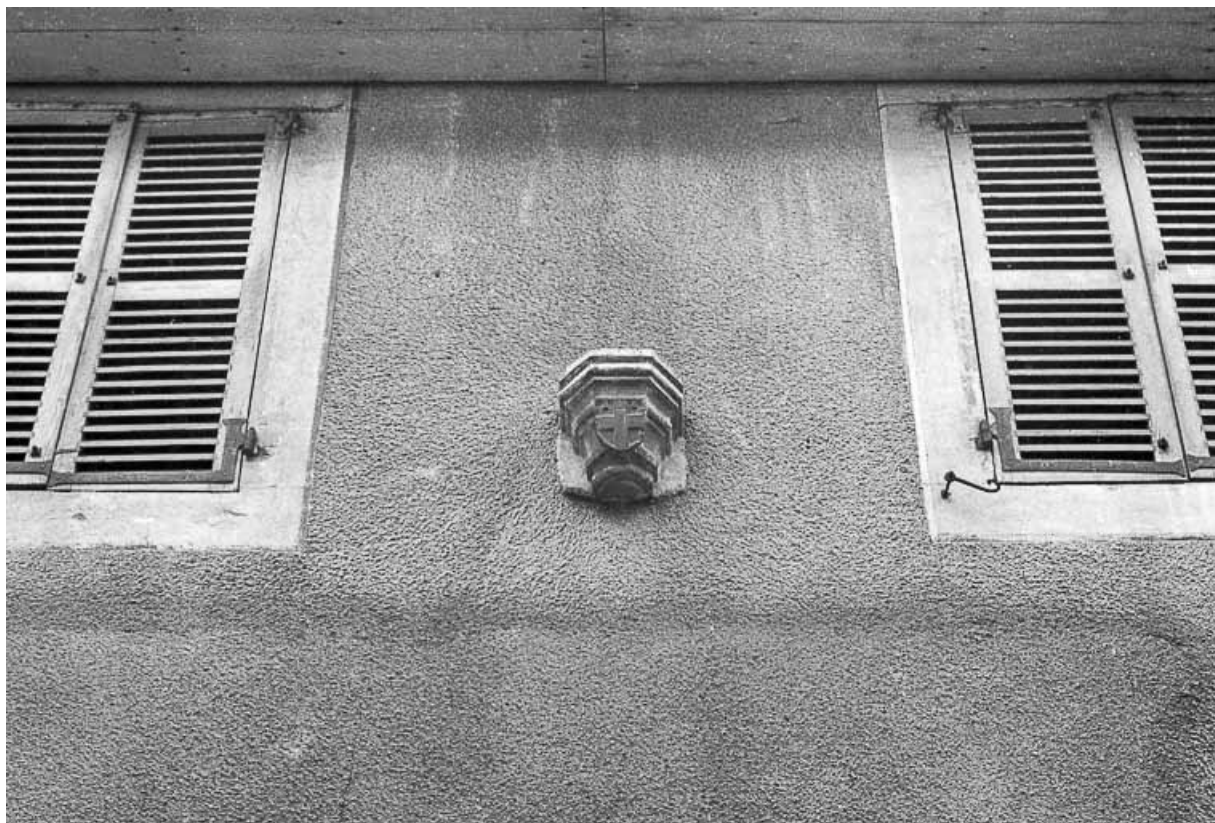
Maison située rue de l'Eglise : blason. 39, Château-Chalon
