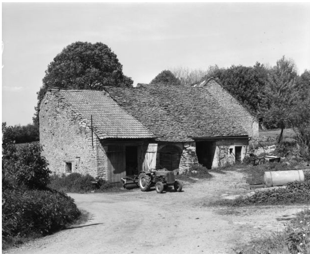
Vue générale de la façade antérieure.
