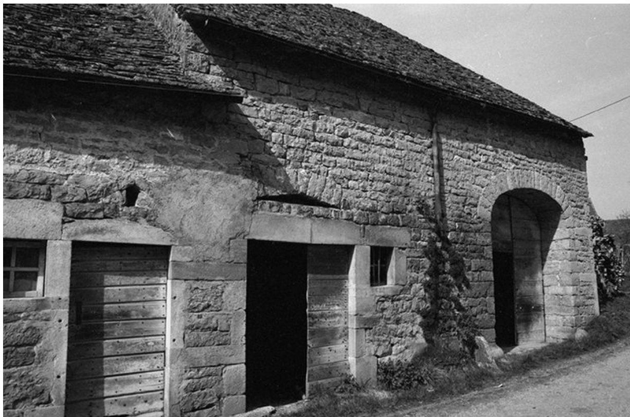
Ferme cadastrée 1964 AB 51 : façade antérieure vue de trois-quarts gauche, toit de laves. 39, Blois-sur-Seille
