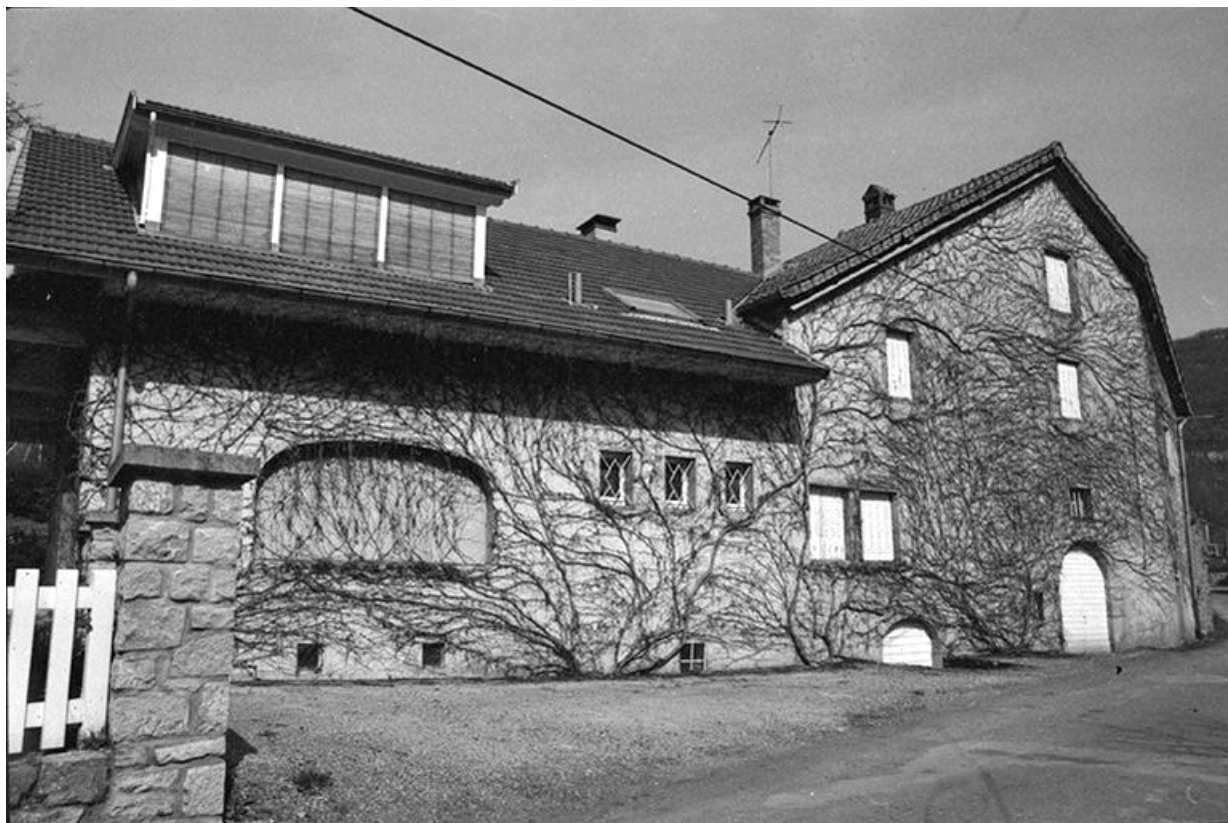
Maison cadastrée 1964 AB 13 : façade antérieure. 39, Blois-sur-Seille
