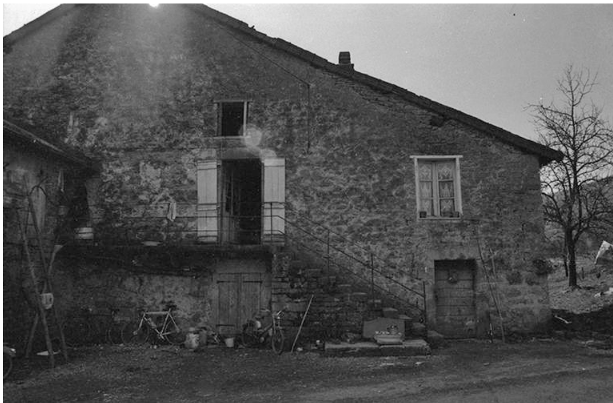
Maison cadastrée 1964 AB 32 : façade antérieure.
