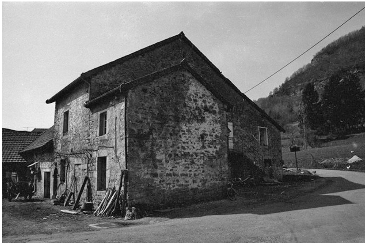
Maison cadastrée 1964 AB 32 : façade antérieure.
