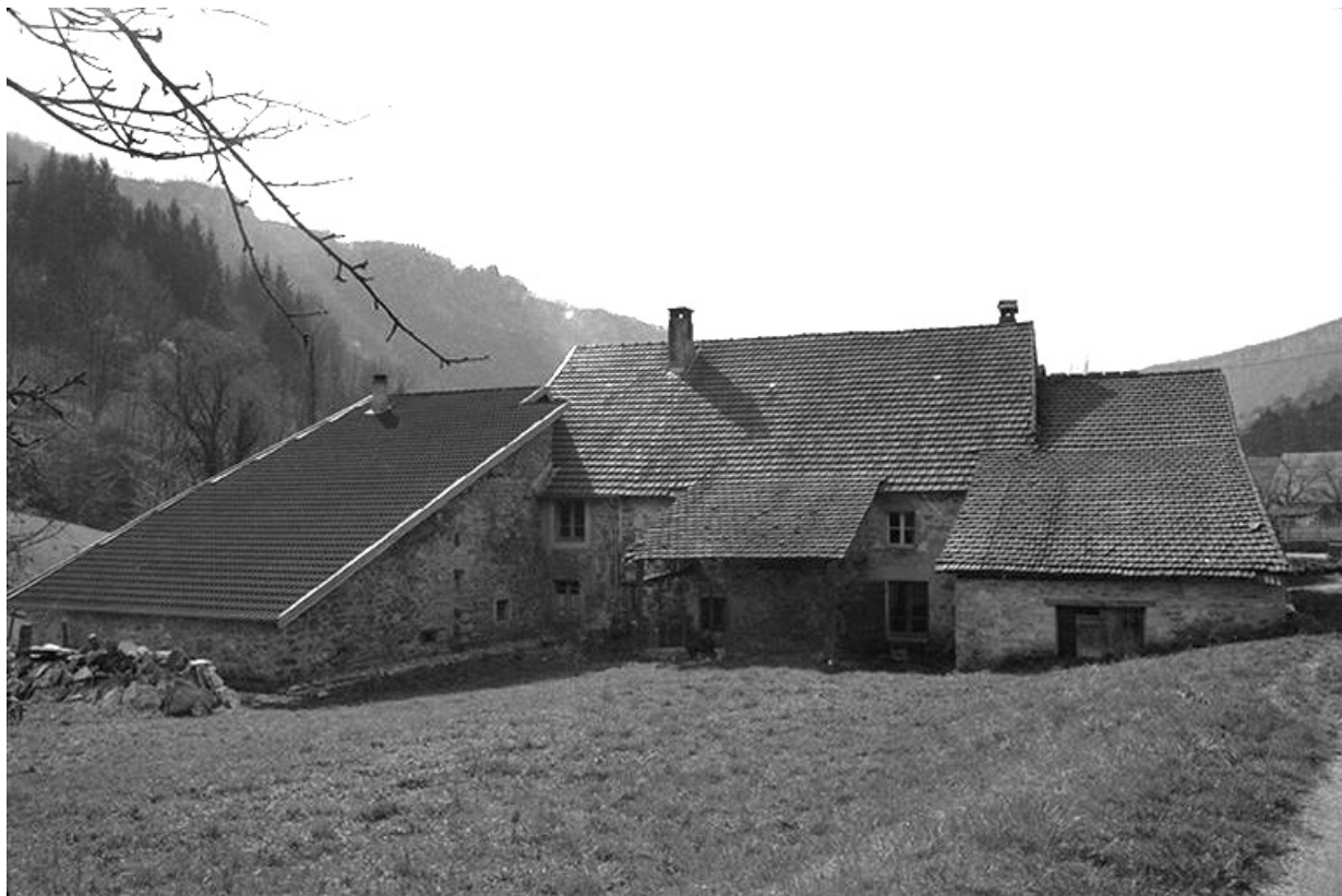
Ferme cadastrée 1964 AB 142 : façade est. 39, Blois-sur-Seille
