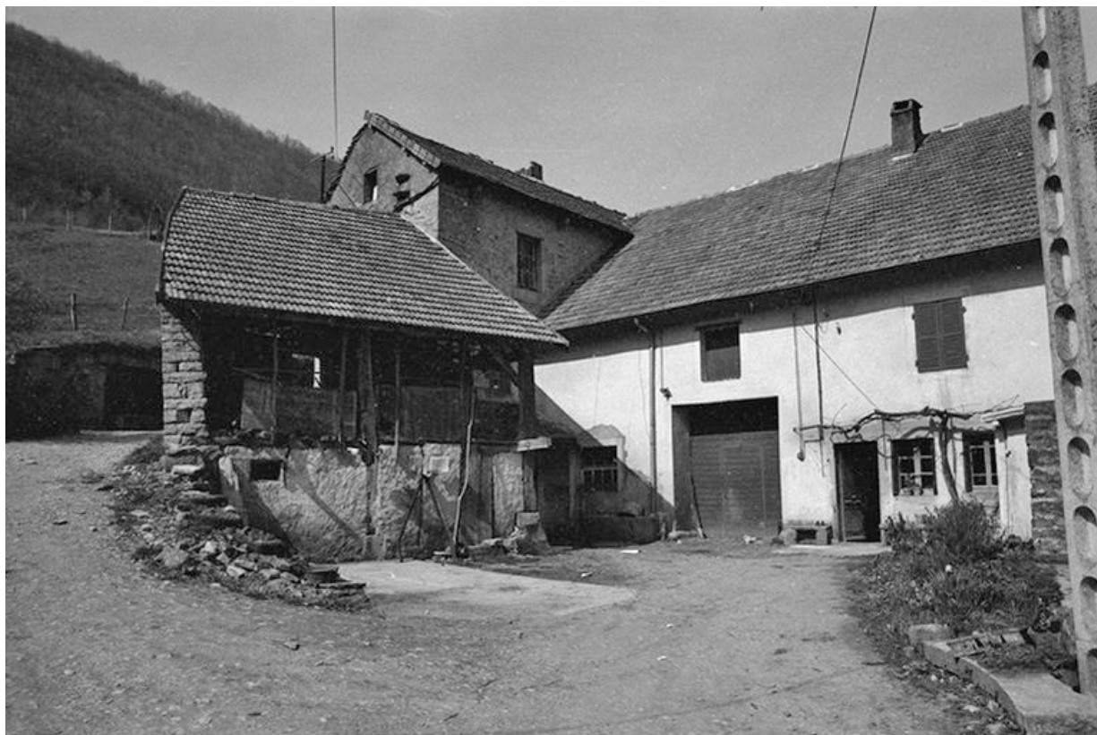
Ferme cadastrée 1964 AB 108 et 109, datée de 1794 : façade antérieure. 39, Blois-sur-Seille
