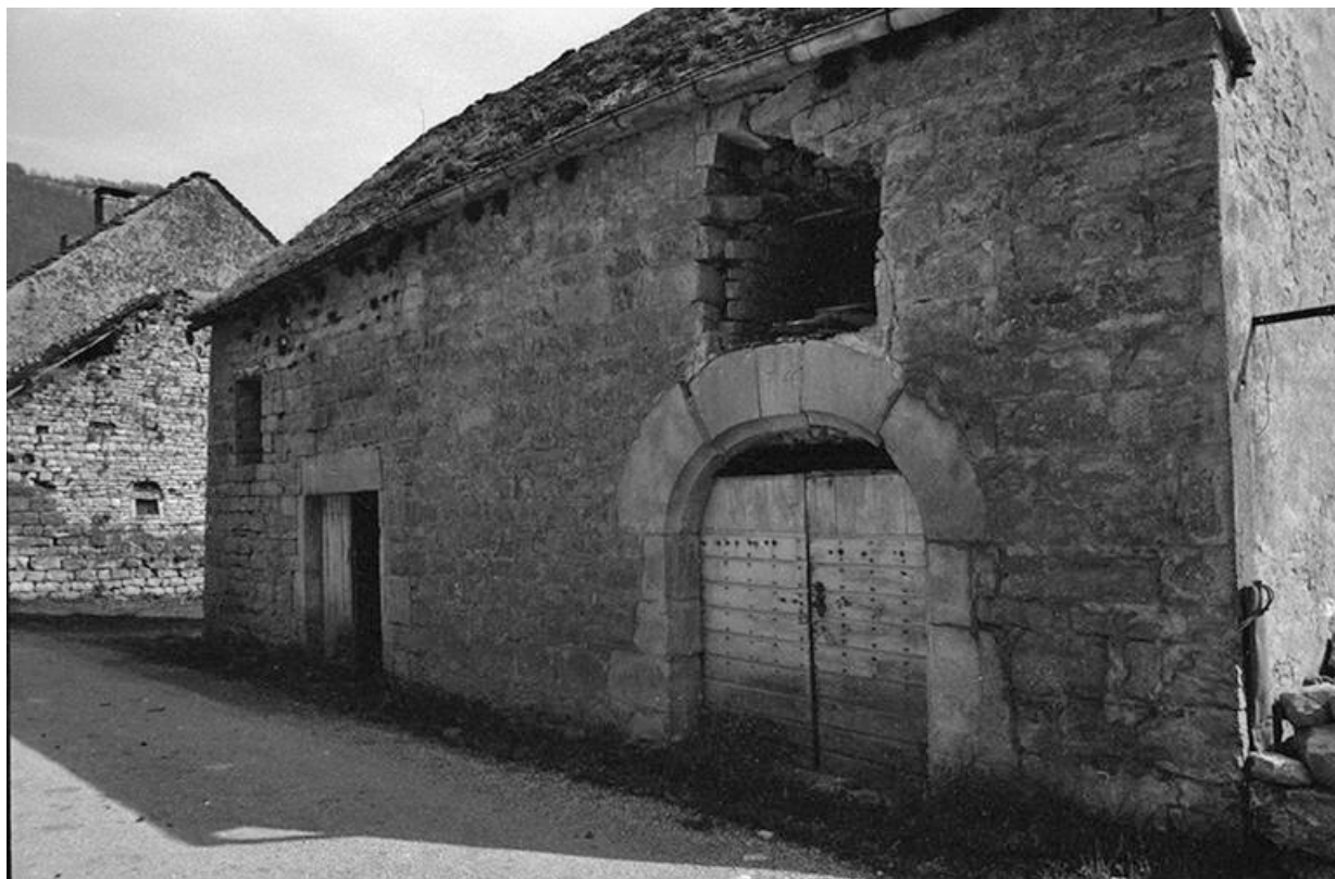
Ferme cadastrée 1964 AB 57-58 : façade antérieure vue de trois-quarts droit. 39, Blois-sur-Seille
