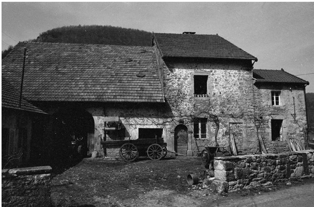
Ferme cadastrée 1964 AB 32 : façades antérieure et latérale droite. 39, Blois-sur-Seille
