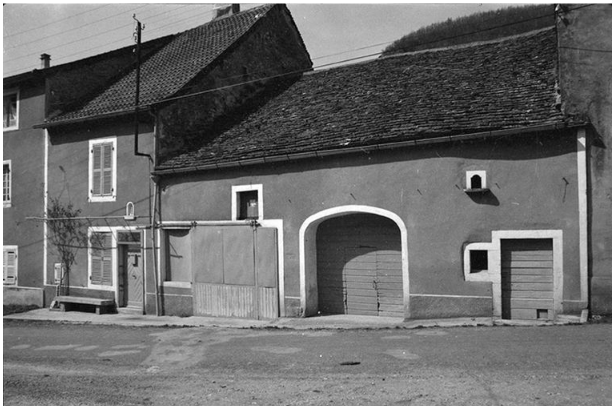
Ferme cadastrée 1964 AB 33 : façade antérieure.
