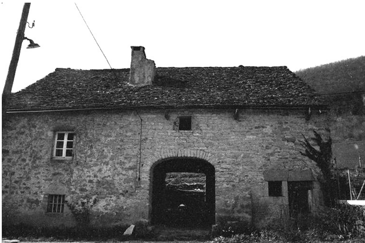
Ferme cadastrée 1964 AB 102 : façade postérieure. A noter le toit de laves. 39, Blois-sur-Seille
