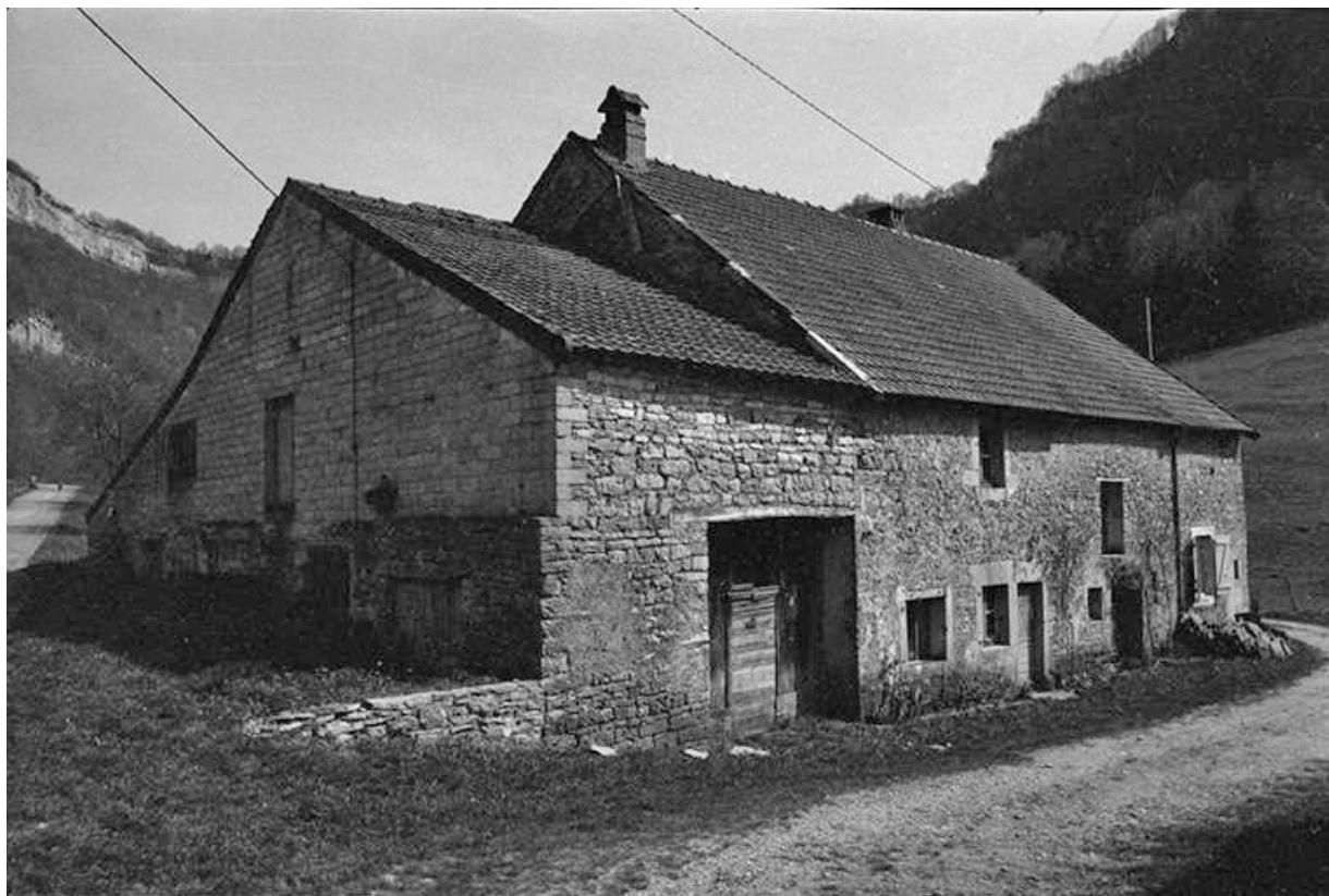
Ferme cadastrée 1964 AB 145 située le long du chemin communal du Mont de Blois à La Marre : façades antérieure et latérale gauche.
