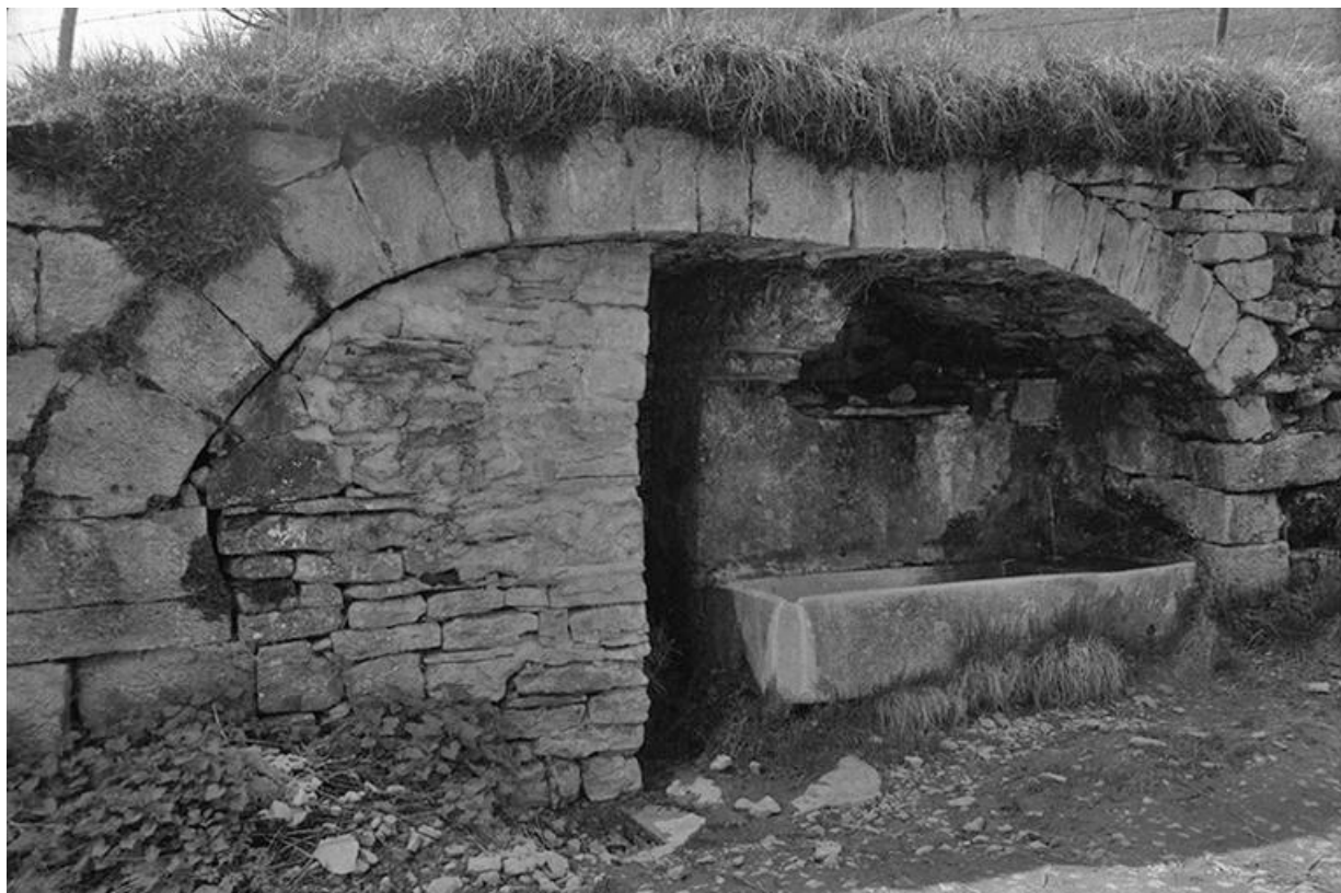
Fontaine cadastrée 1964 AB 110, située au lieudit Chez Rodot : vue d'ensemble. 39, Blois-sur-Seille
