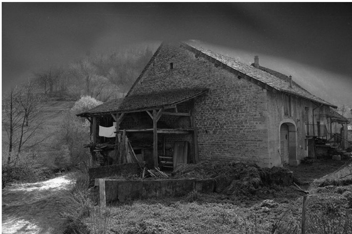
Ferme cadastrée 1964 AB 6 : façades antérieure et latérale gauche.
