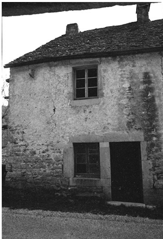
Maison cadastrée 1964 AB 59 : façade antérieure, toit de laves. 39, Blois-sur-Seille
