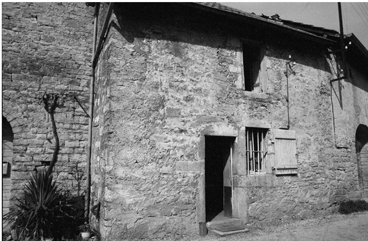
Ferme cadastrée 1964 AB 54 : partie habitation.
