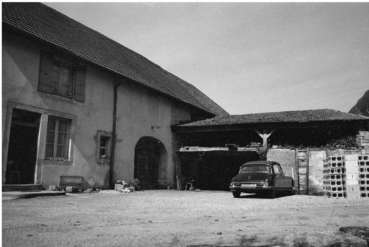
Ferme cadastrée 1964 AB 138 : façade antérieure et hangar sur cour. 39, Blois-sur-Seille
