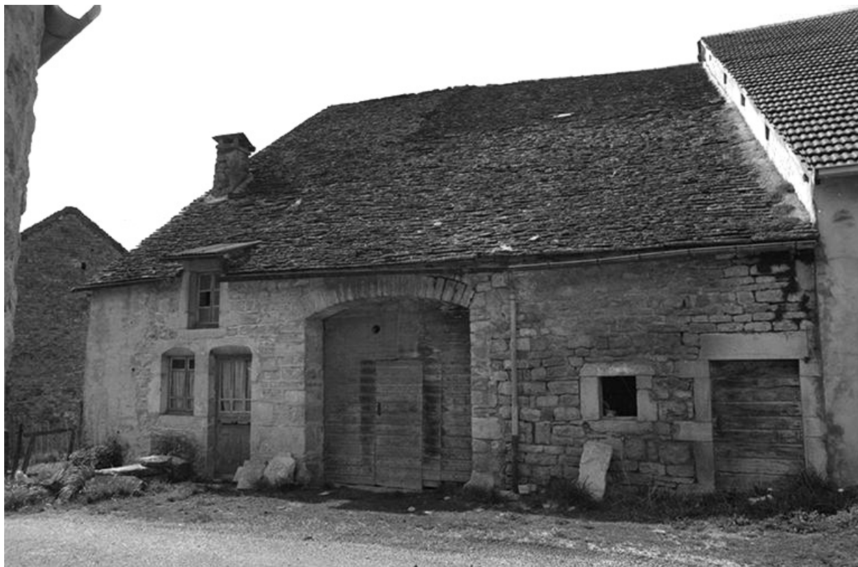
Ferme cadastrée 1964 AB 86 : façade est.
