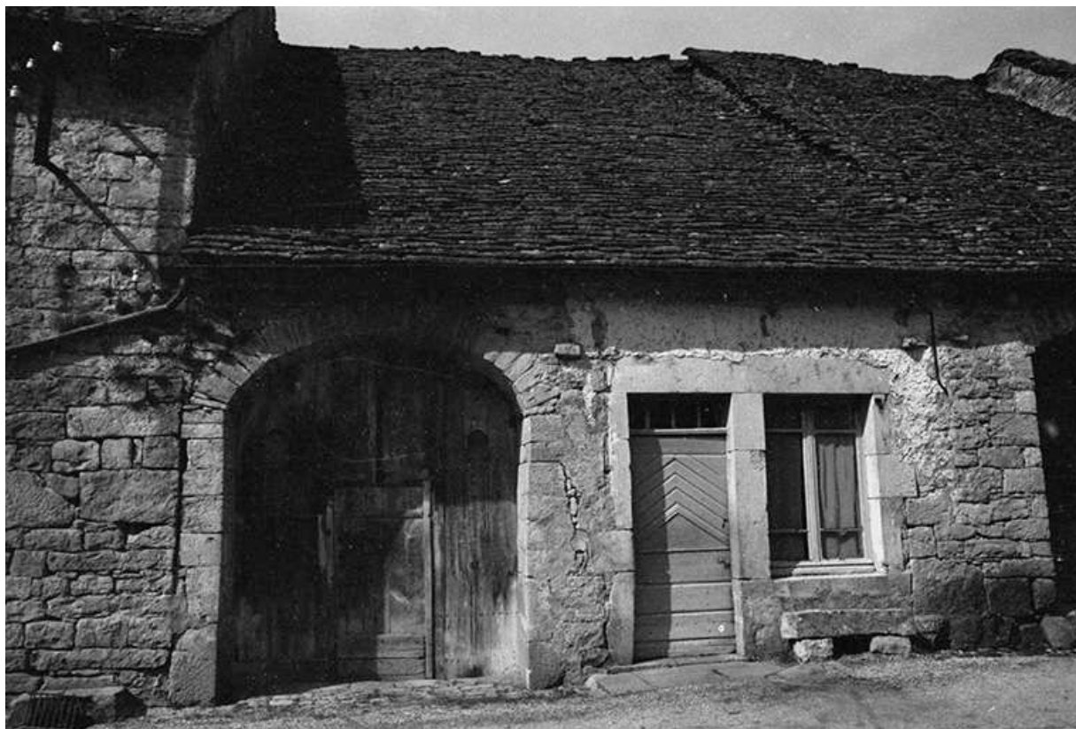
Ferme cadastrée 1964 AB 52 et 53 : façade antérieure vue de face, toits de laves. 39, Blois-sur-Seille
