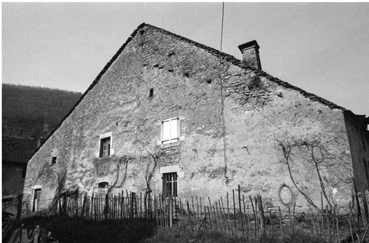
Ferme cadastrée 1964 AB 86 : façade sud. 39, Blois-sur-Seille
