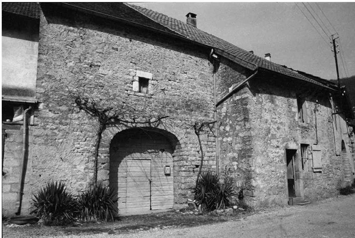
Ferme cadastrée 1964 AB 54 : façade antérieure. 39, Blois-sur-Seille
