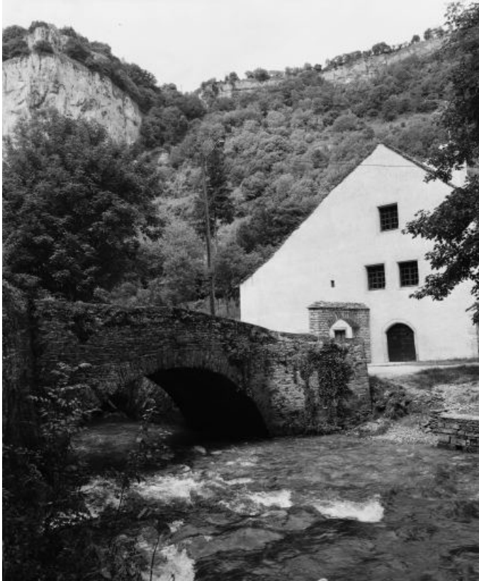
Face amont, vue de trois quarts gauche.
