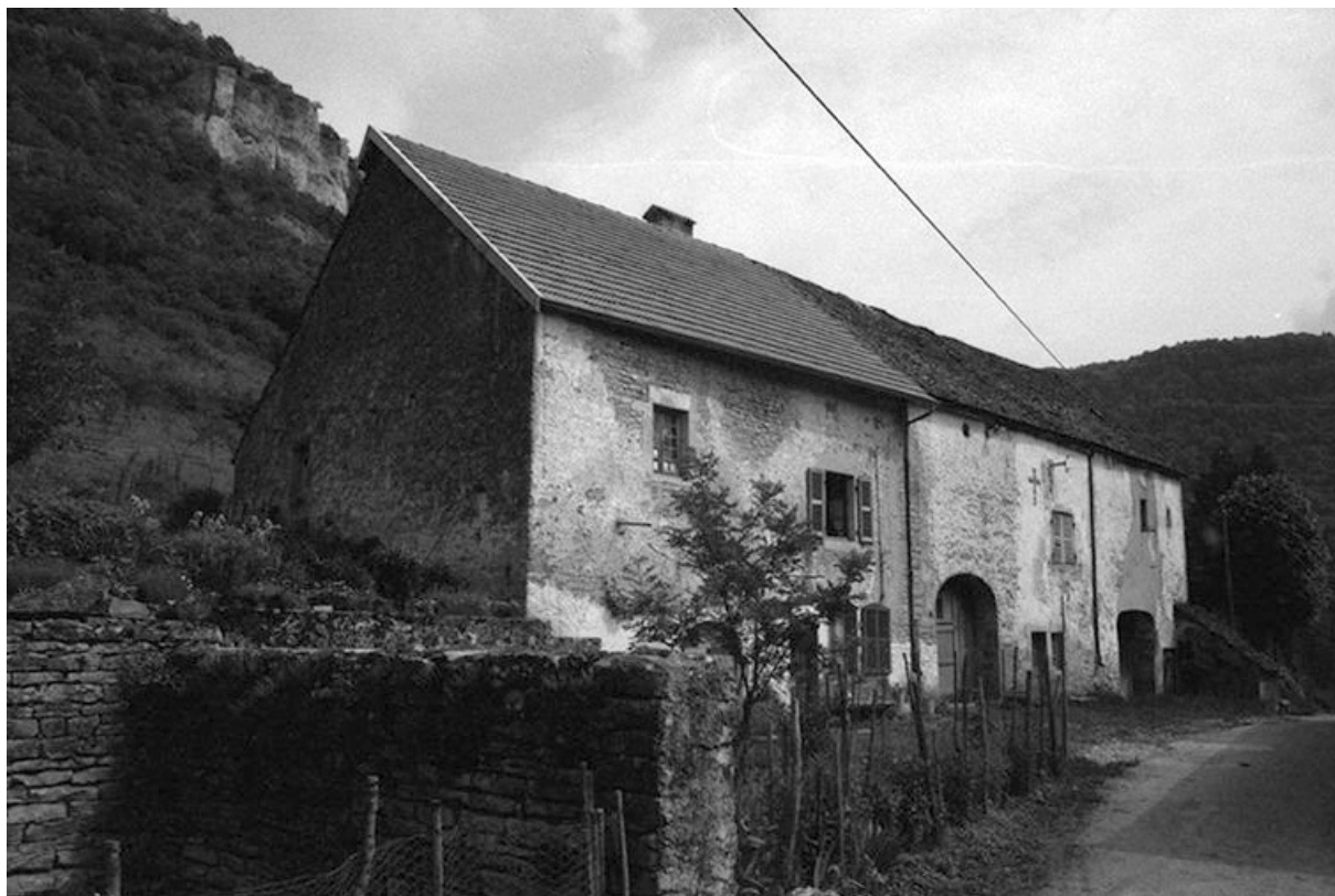
Façade antérieure vue de trois-quarts gauche.
