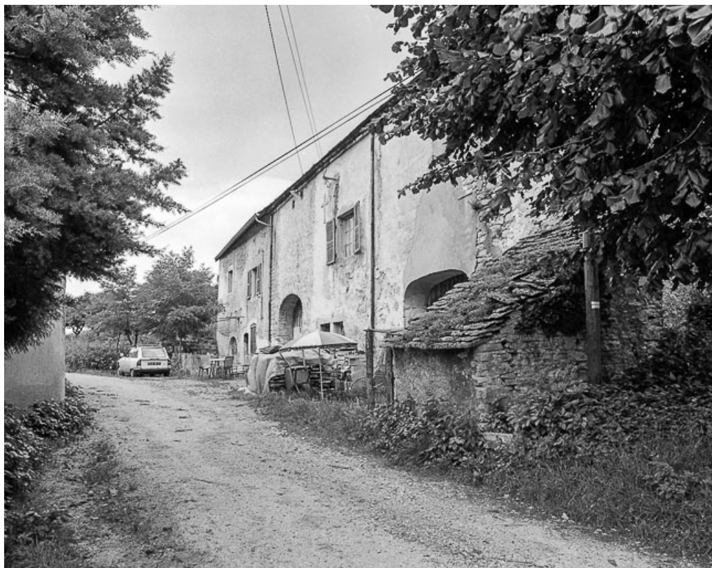
Façade antérieure vue de trois quarts droit. 39, Baume-les-Messieurs rue de la Peyrouse
