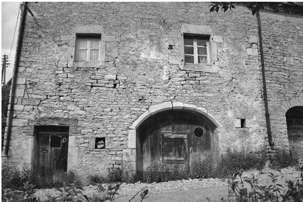
Ferme cadastrée 1960 B 106-107, située au lieudit La Peyrouse : façade antérieure. 39, Baume-les-Messieurs
