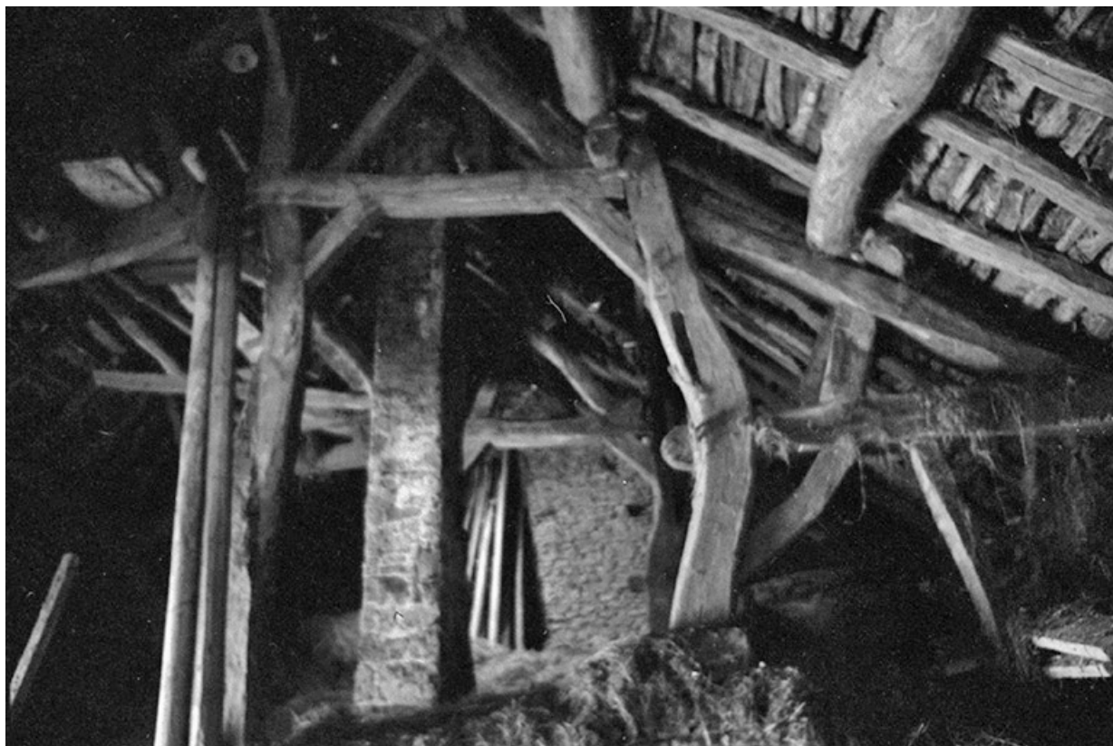
Ferme cadastrée 1960 B 107, située au lieudit La Peyrouse : détail de la charpente d'un toit en laves. 39, Baume-les-Messieurs
