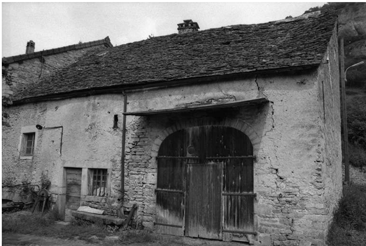
Ferme cadastrée 1960 B 107, située au lieudit La Peyrouse : façade antérieure. 39, Baume-les-Messieurs
