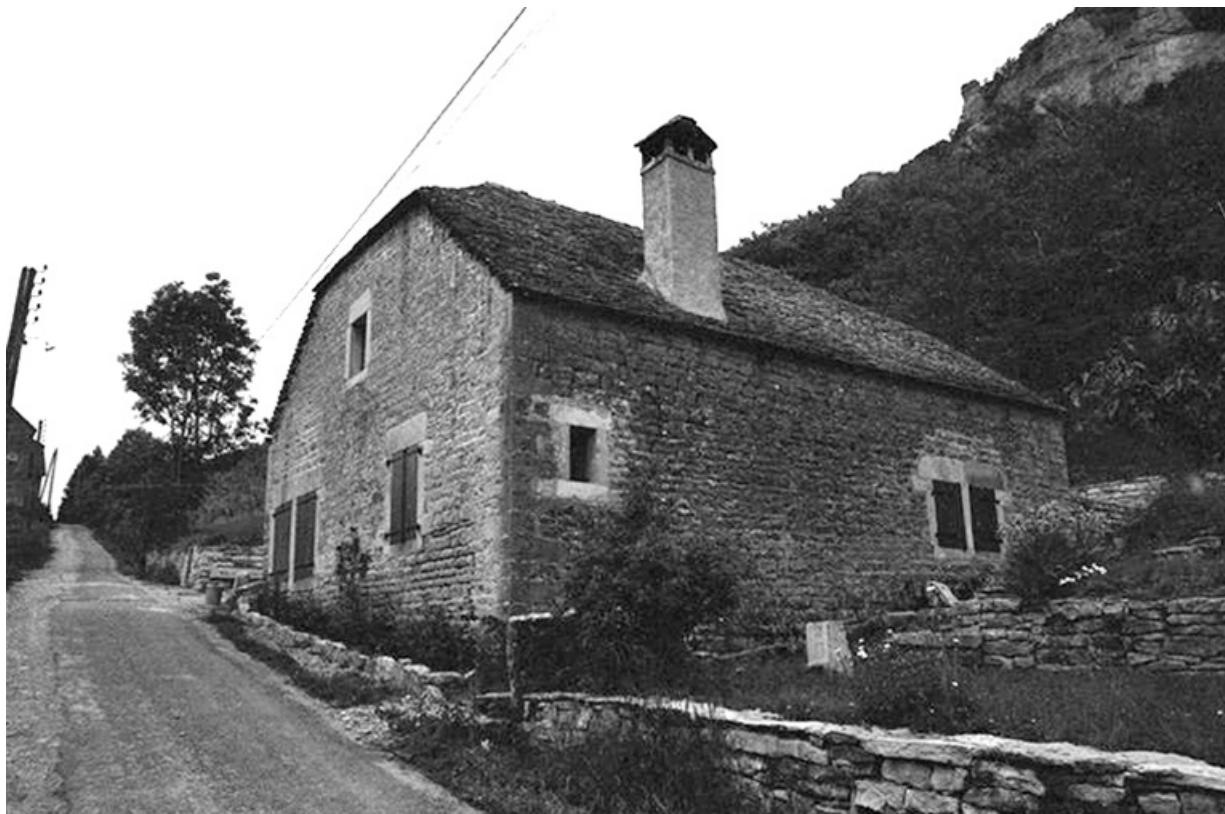
Ferme cadastrée 1960 B 56, située au lieudit La Peyrouse : façade sur rue et façade postérieure. . A noter le toit de laves 39, Baume-les-Messieurs
