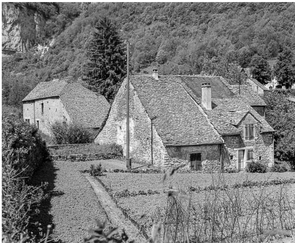
Ferme située rue Moretin : façades antérieure et latérale gauche. 39, Baume-les-Messieurs
