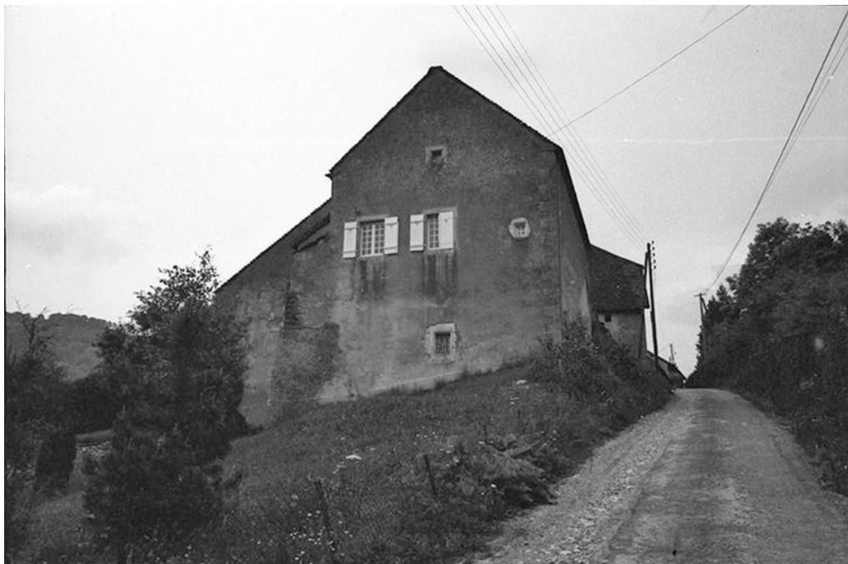
Ferme cadastrée 1960 B 110, située au lieudit La Peyrouse : façade latérale gauche. 39, Baume-les-Messieurs
