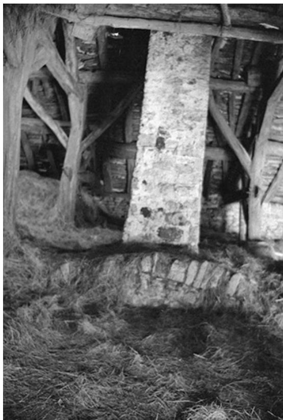
Ferme cadastrée 1960 B 107, située au lieudit La Peyrouse : détail de la charpente d'un toit en laves. 39, Baume-les-Messieurs
