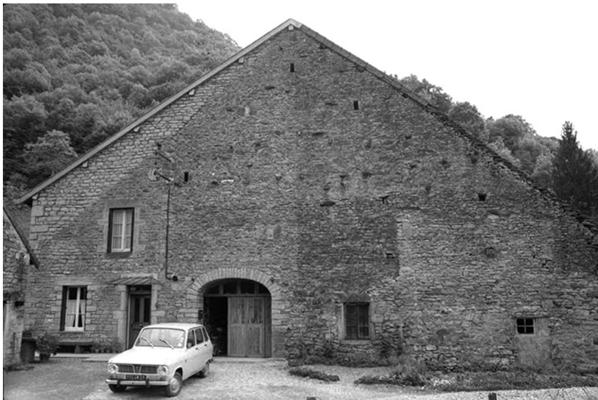
Ferme cadastrée 1960 C 562 , située au lieudit La Peyrouse : façade antérieure. 39, Baume-les-Messieurs
