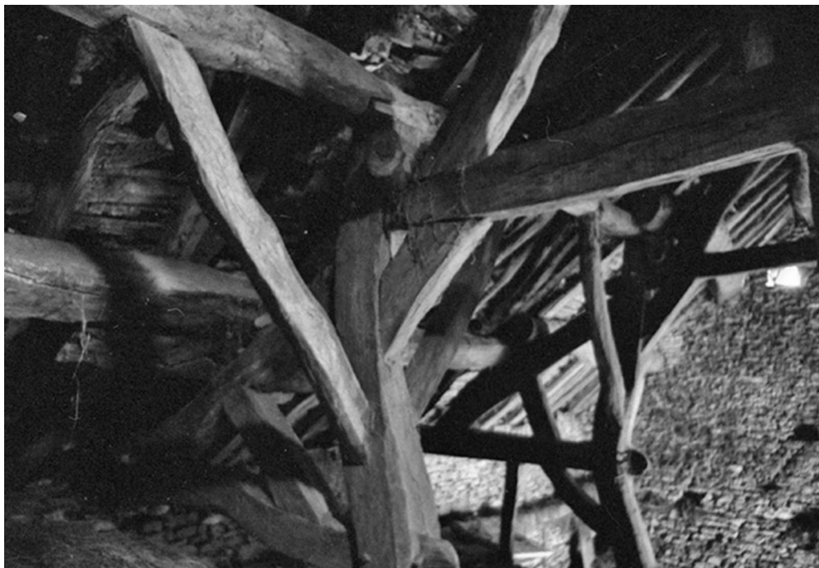
Ferme cadastrée 1960 B 107, située au lieudit La Peyrouse : détail de la charpente d'un toit en laves. 39, Baume-les-Messieurs
