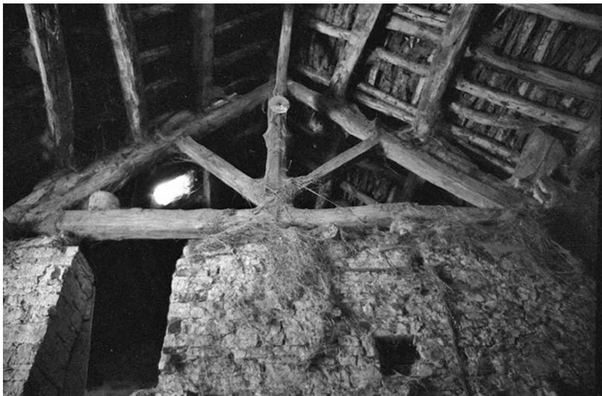
Ferme cadastrée 1960 B 109, située au lieudit La Peyrouse : charpente de toit de laves. 39, Baume-les-Messieurs
