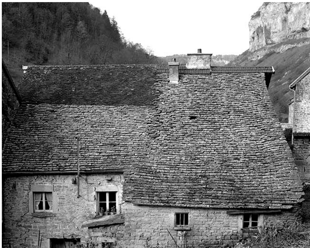
Détail d'une toiture en laves.
