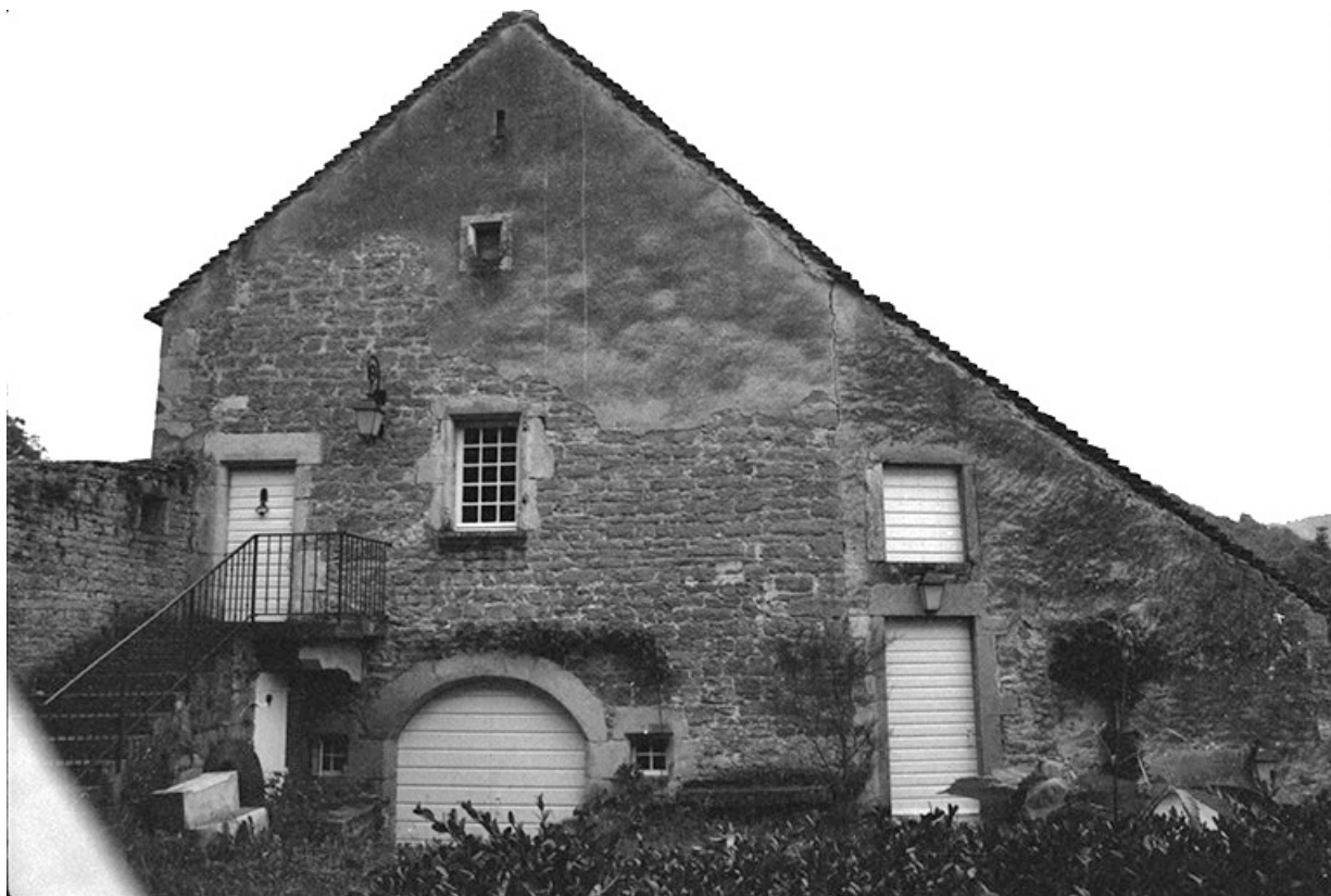
Ferme cadastrée 1960 B 110, située au lieudit La Peyrouse : façade antérieure. 39, Baume-les-Messieurs
