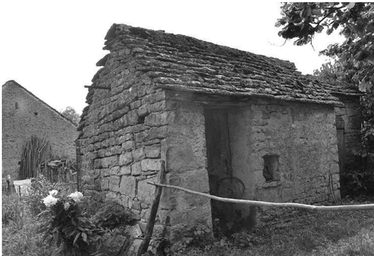
Ferme cadastrée 1960 B 108, située au lieudit La Peyrouse : "abeiller" 39, Baume-les-Messieurs
