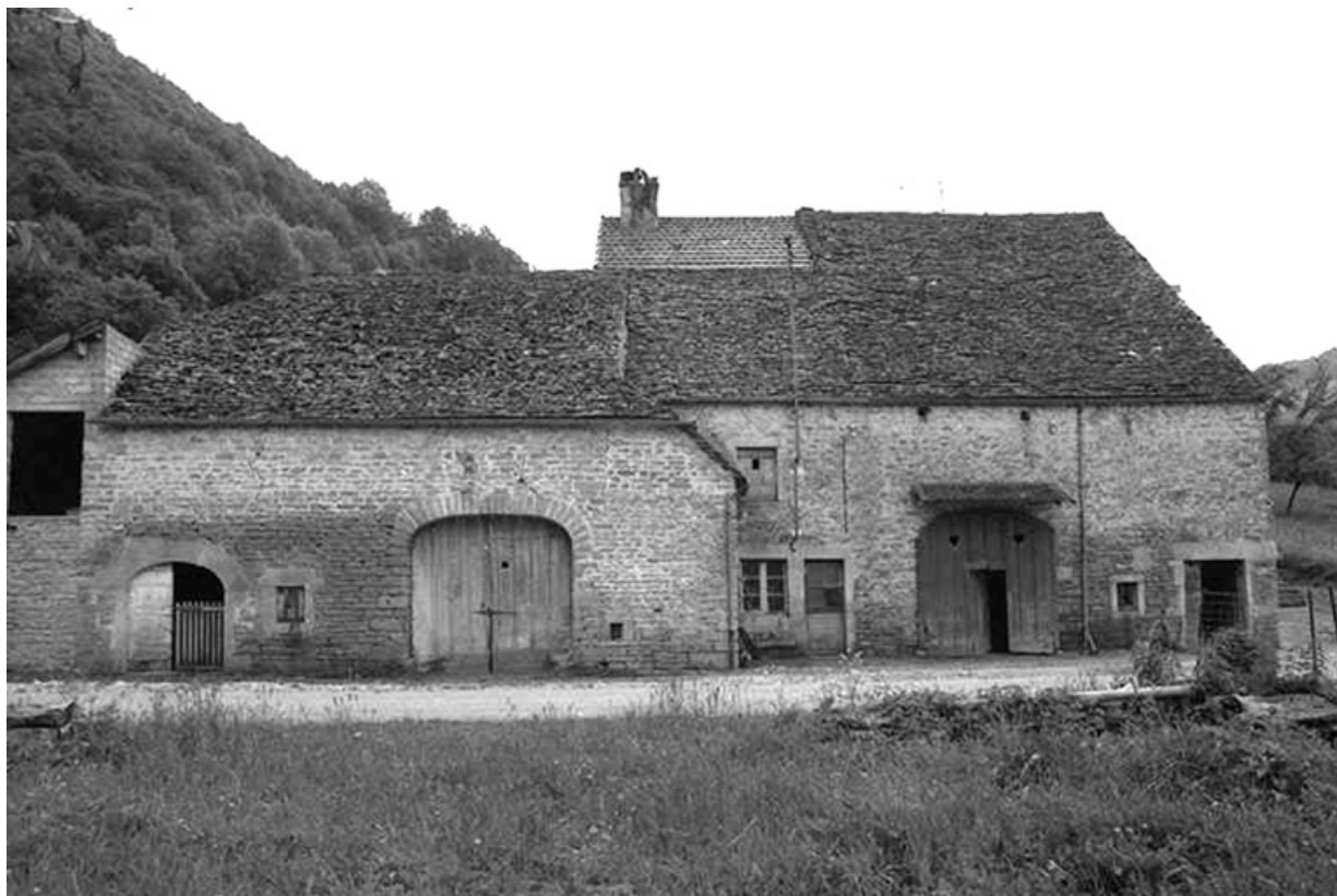
Ferme cadastrée 1960 C 543, située au lieudit Cour froide : façade antérieure. 39, Baume-les-Messieurs
