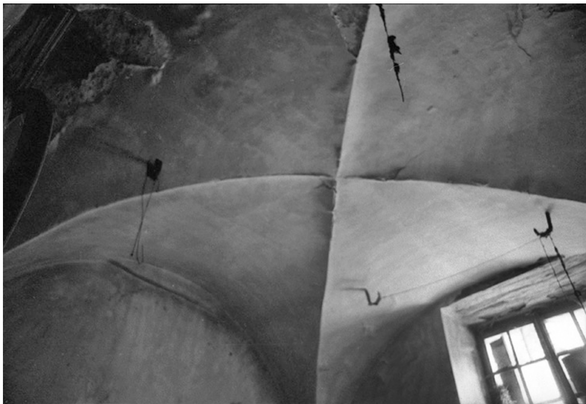
Ferme cadastrée 1960 B 107, située au lieudit La Peyrouse : chambre voûtée. 39, Baume-les-Messieurs
