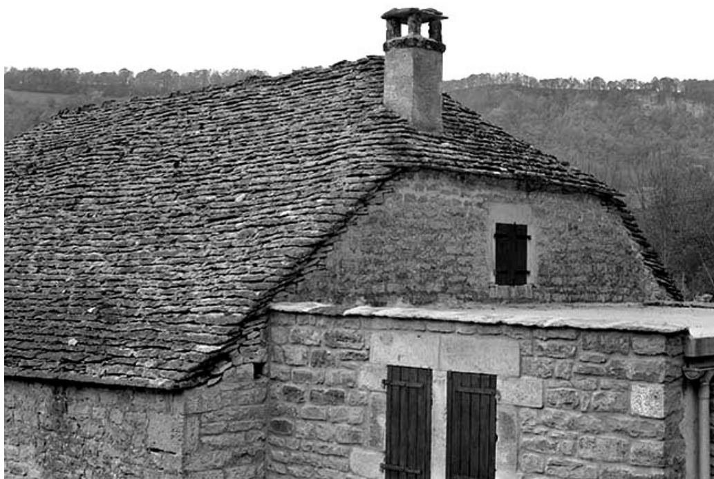
Détail d'une toiture en laves.
