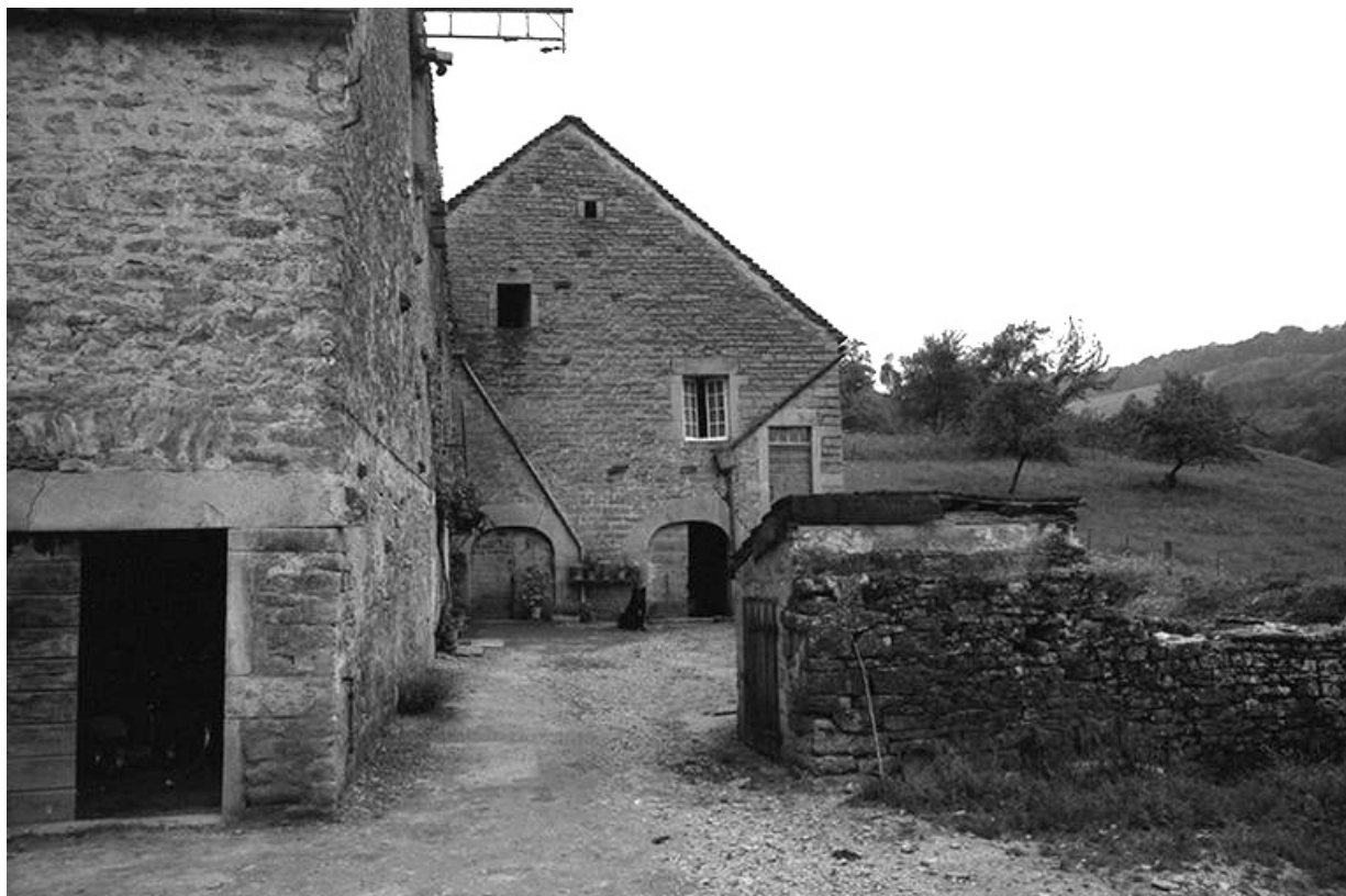
Ferme cadastrée 1960 C 543 , située au lieudit Cour froide : bâtiment sur la cour intérieure. 39, Baume-les-Messieurs
