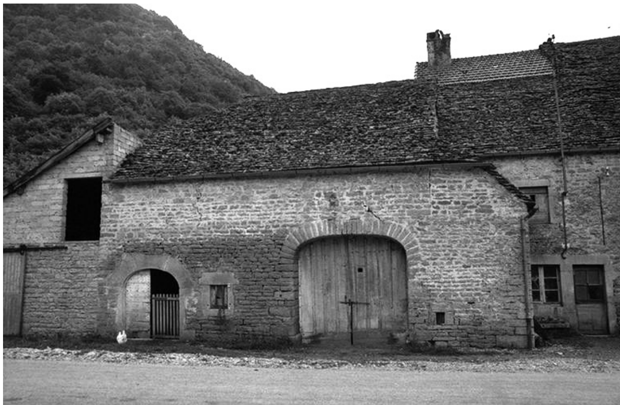
Ferme cadastrée 1960 C 543 , située au lieudit Cour froide : partie agricole. 39, Baume-les-Messieurs
