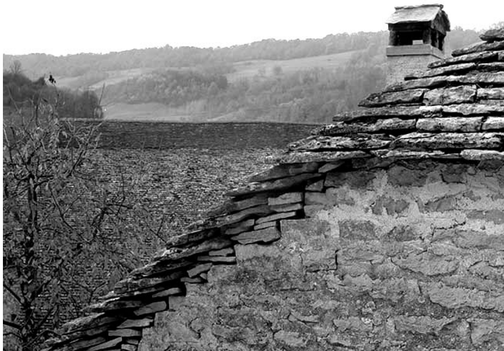
Détail d'une bordure de toit en laves.
