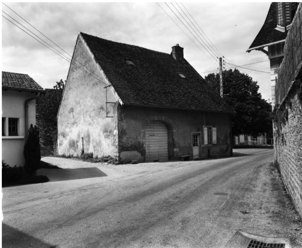
Façades antérieure et latérale gauche.
