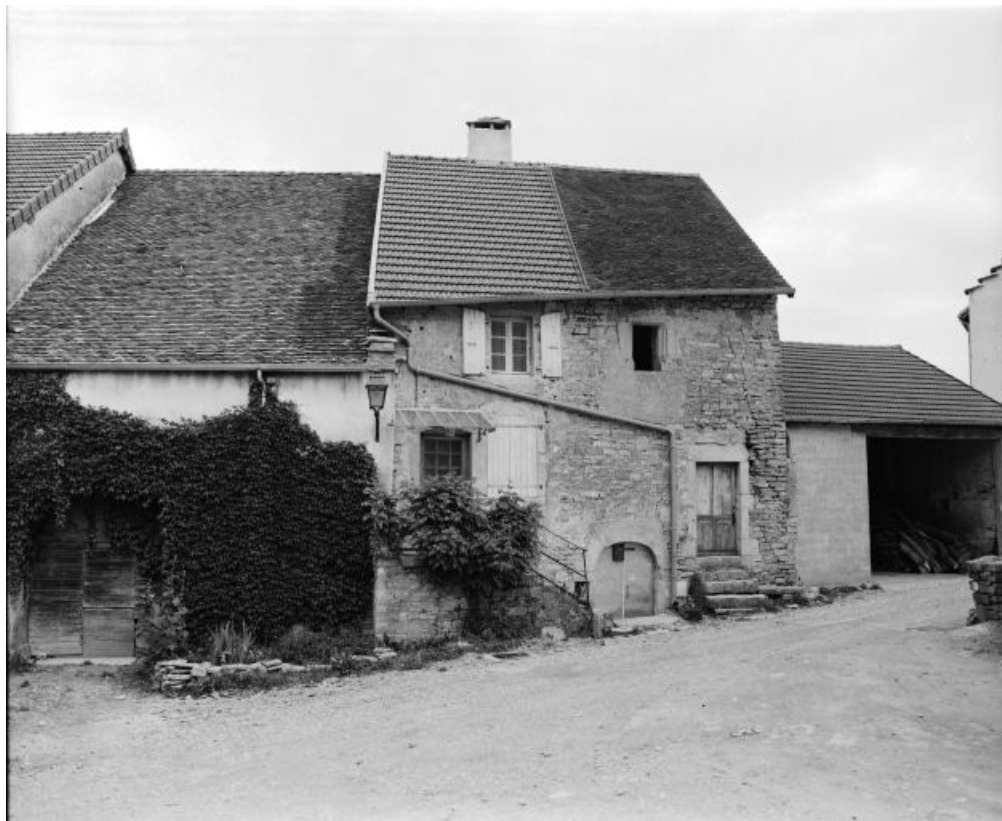
Façade antérieure. 39, Château-Chalon
