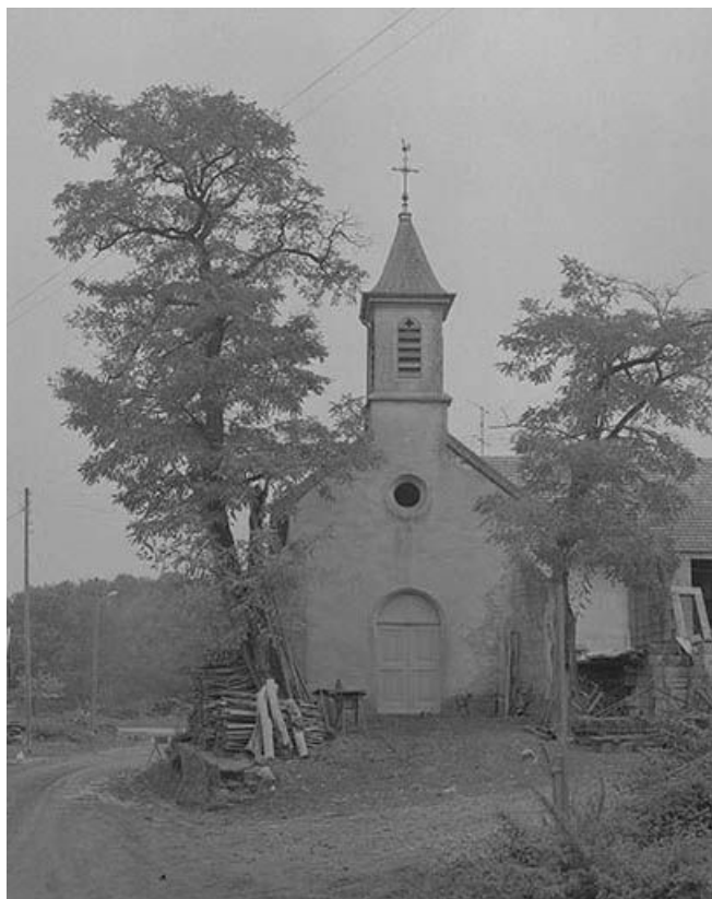
Extérieur : façade antérieure.
