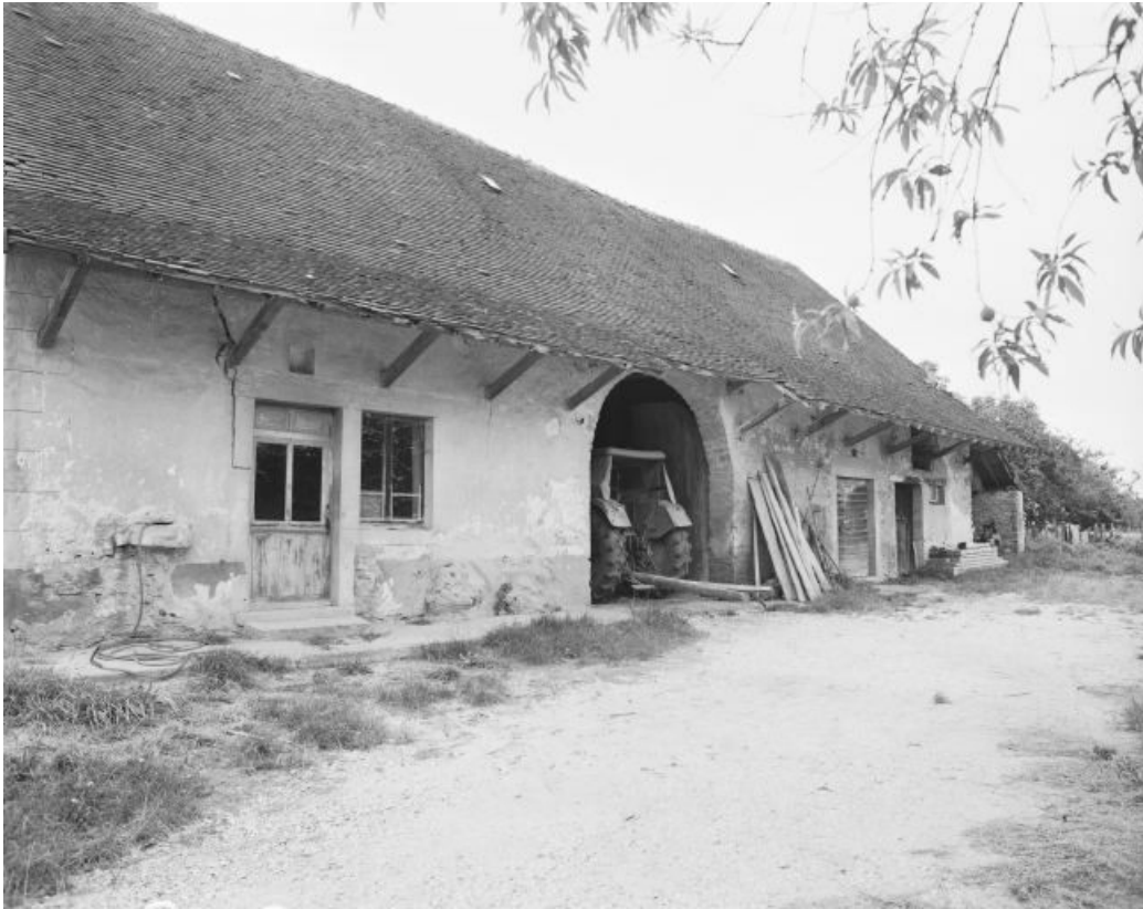
Vue d'ensemble de la façade antérieure.
