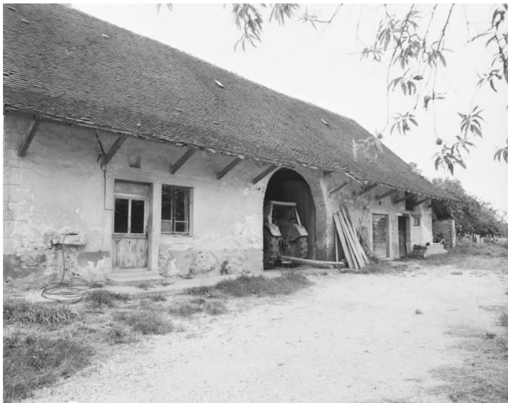
Vue d'ensemble de la façade antérieure.
