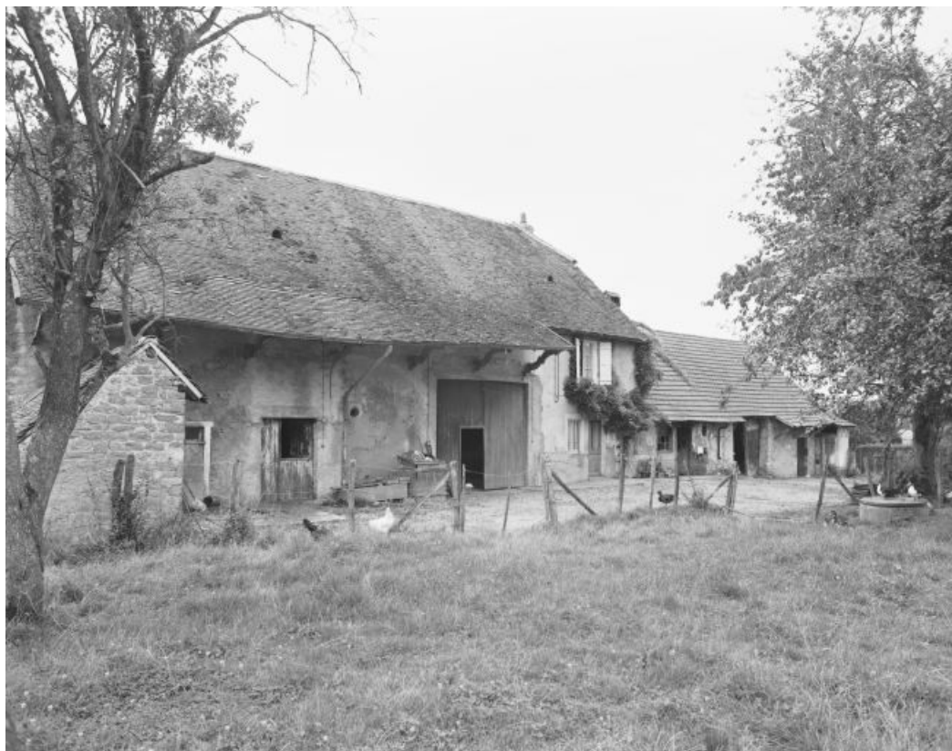
Vue d'ensemble de la façade antérieure.
