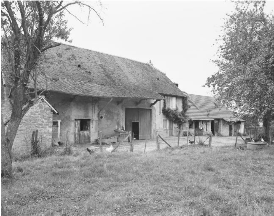
Vue d'ensemble de la façade antérieure.
