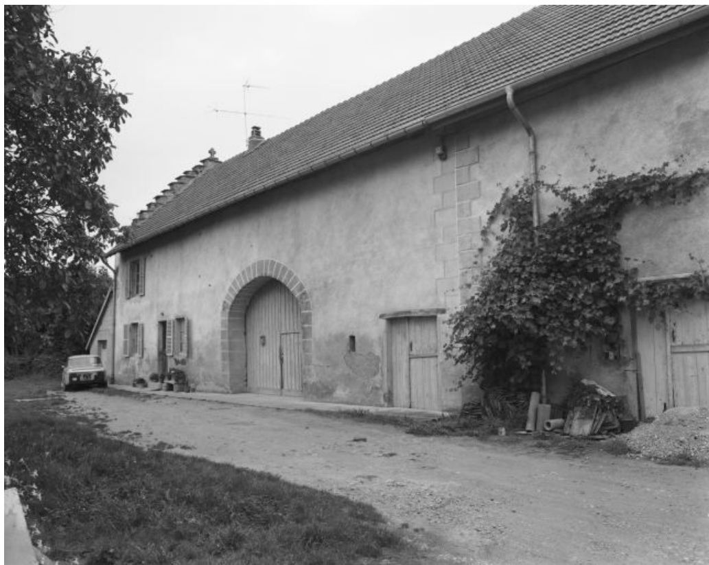
Vue d'ensemble de la façade antérieure.
